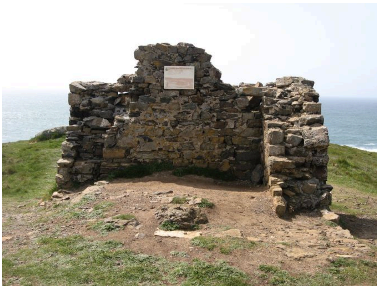
Vue générale du corps de garde de Lostmarc'h
