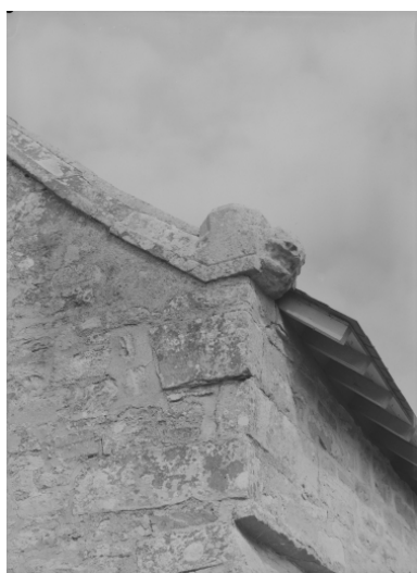
Elévation ouest : détail de la pierre d'assise sSud Phot. François Dagorn IVR53_19683500324V
