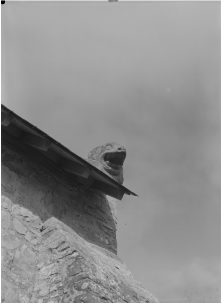
Elévation est : détail de la pierre d'assise sud
