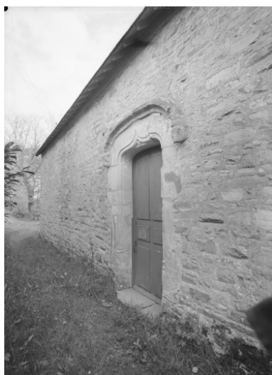
Elévation Nord, porte : vue générale Phot. François Dagorn IVR53_19683500323V
