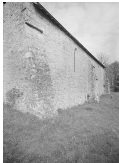
Elévation Sud : vue générale Phot. François Dagorn IVR53_19683500322V
