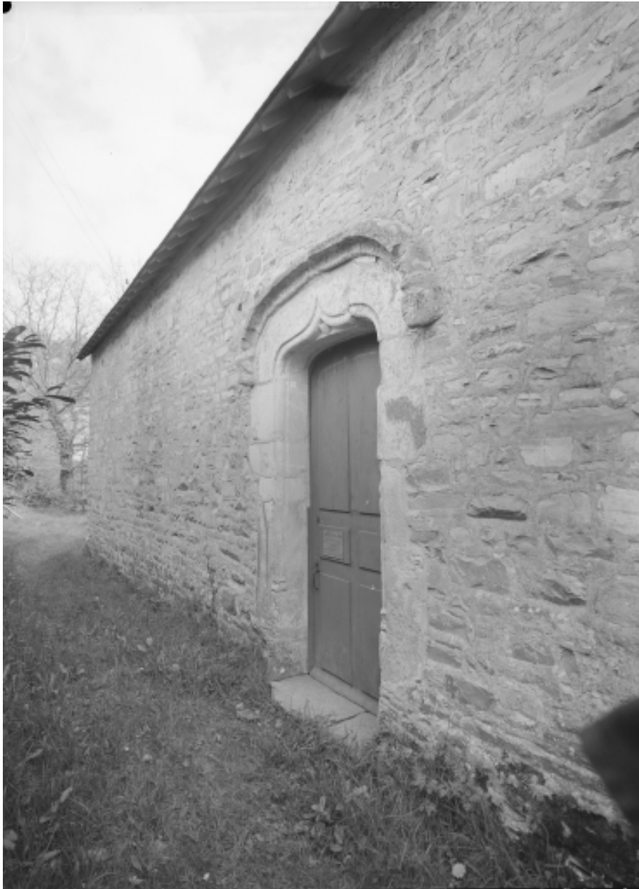
Elévation Nord, porte : vue générale
