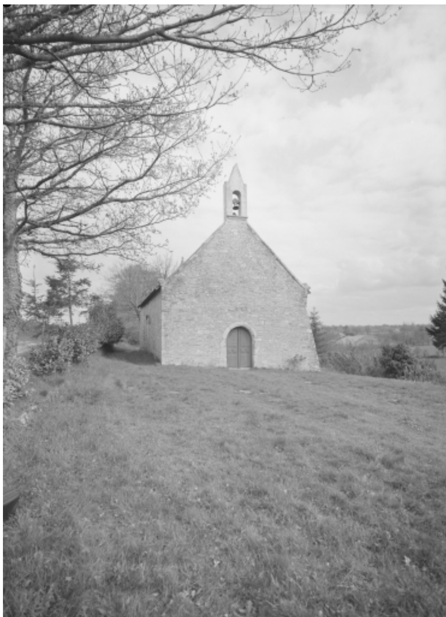
Elévation Ouest : vue générale
