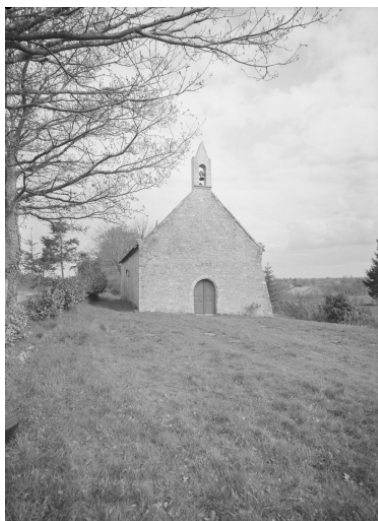
Elévation Ouest : vue générale Phot. François Dagorn IVR53_19683500321V
