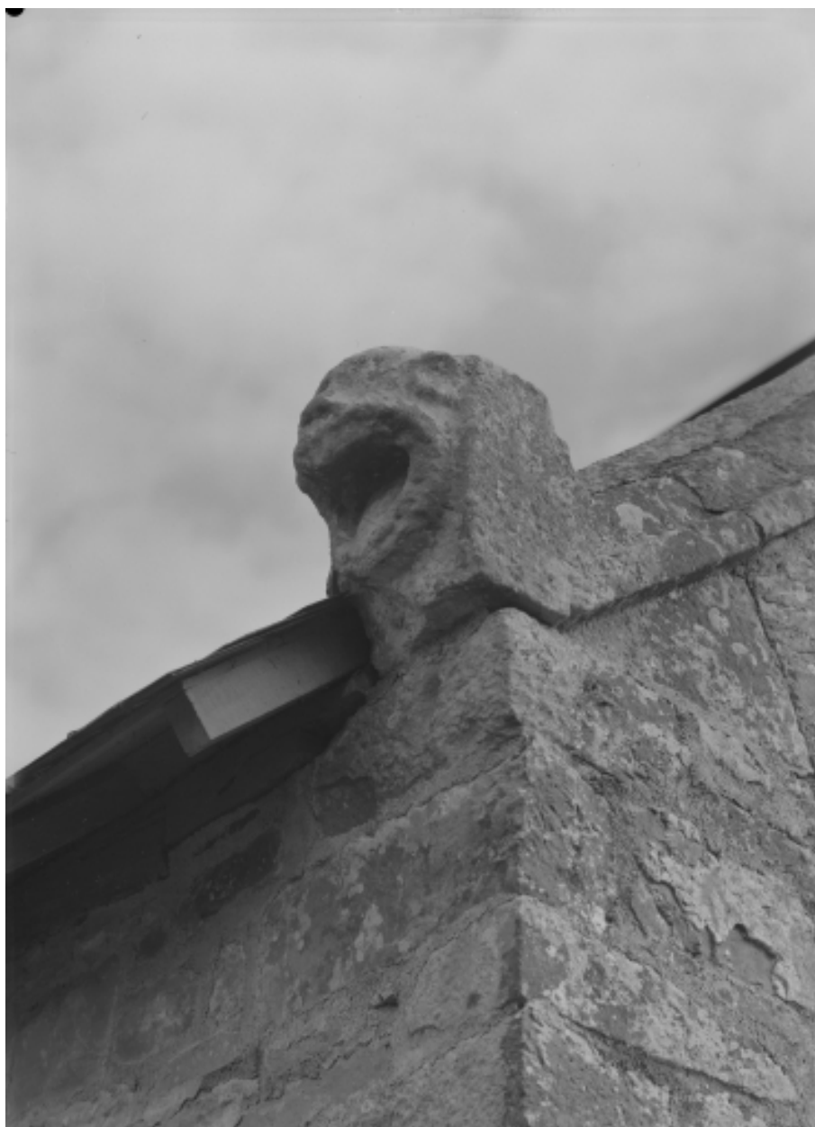
Elévation ouest : détail de la pierre d'assise nord
