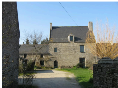
Manoir de Kerandré, façade Sud Phot. Pierre Laurent Constantin IVR53_20225605029NUCA
