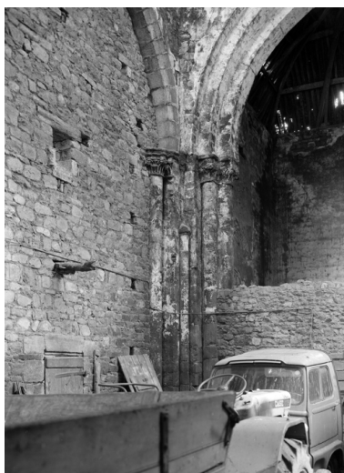
Chapelle : détail d'un pilier Phot. Guy Artur IVR53_19772200034V
