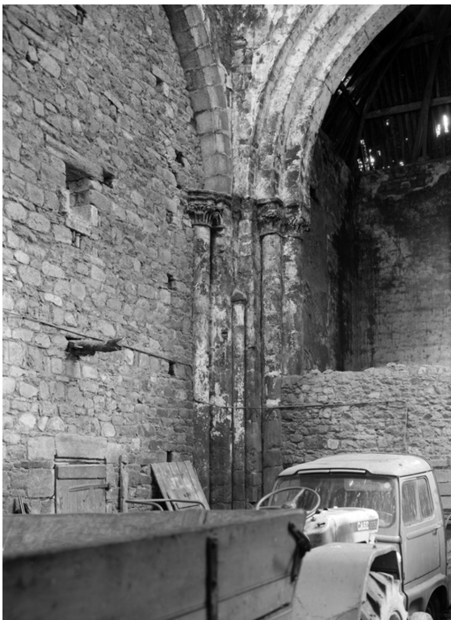
Chapelle : détail d'un pilier
