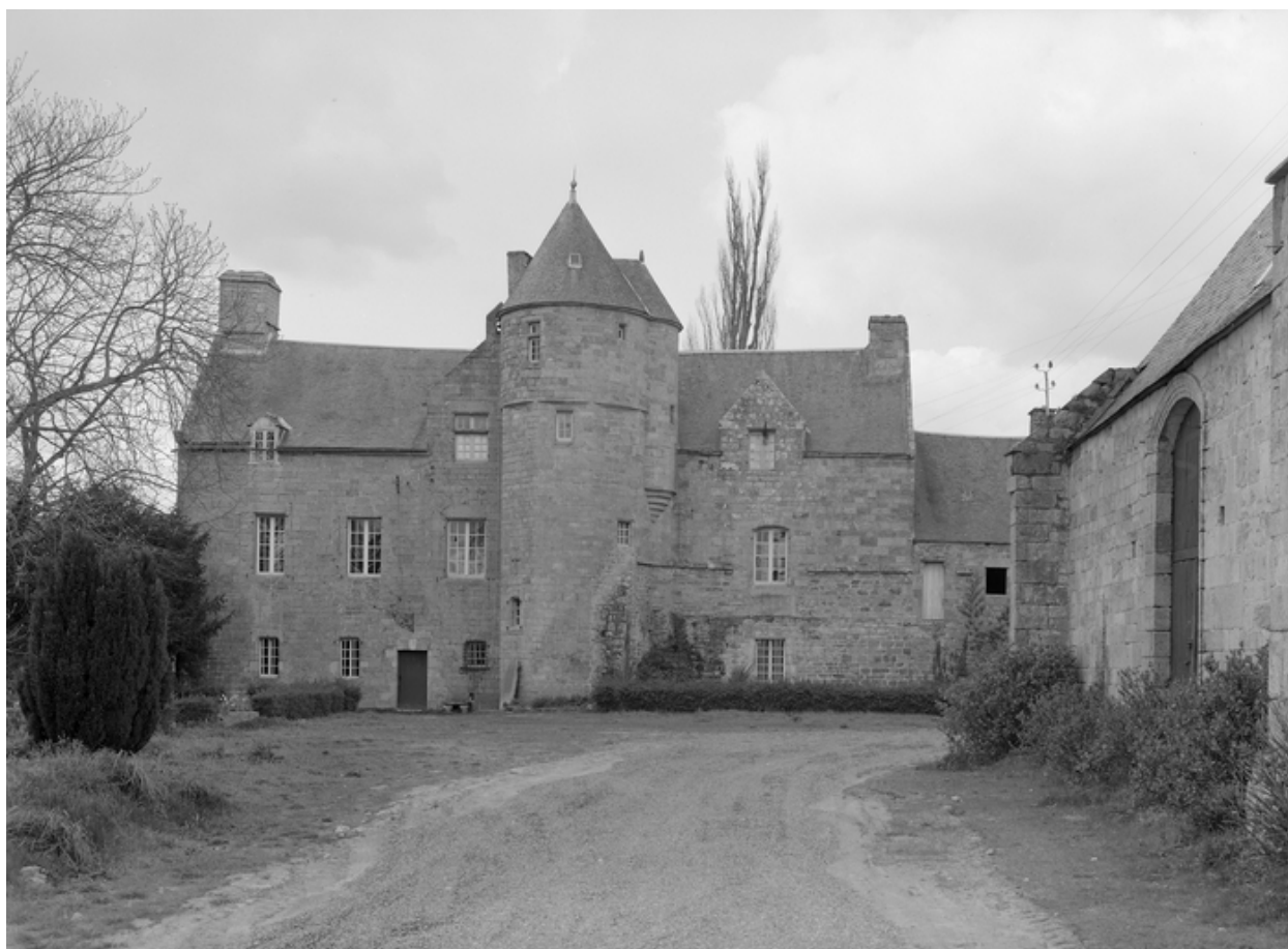
Vue générale de la façade
