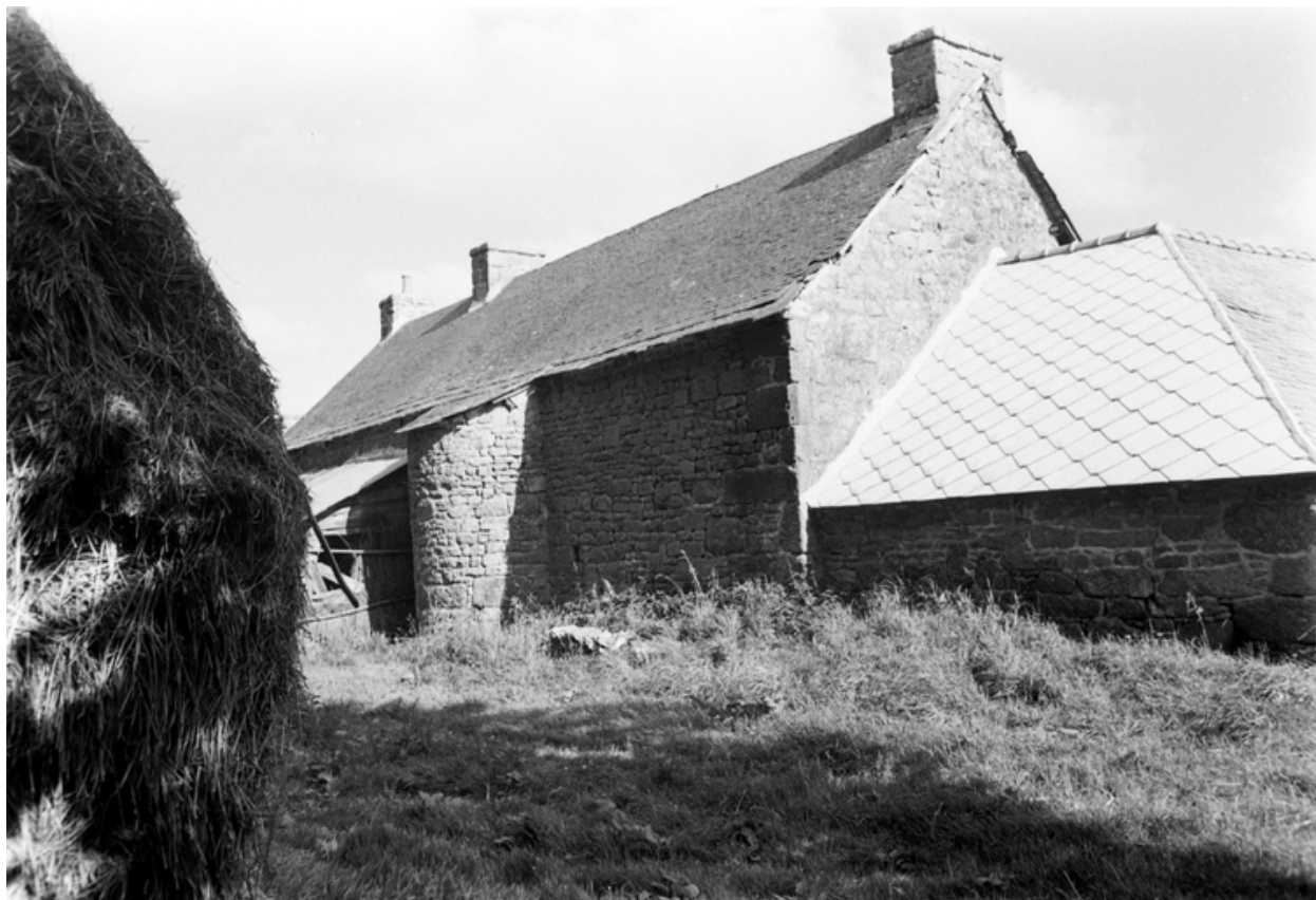
Façade nord : vue d'ensemble
