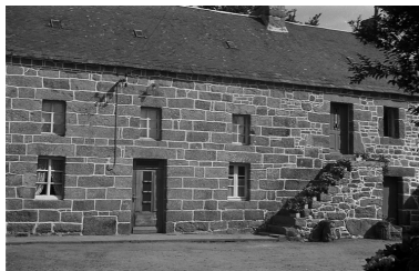
Vue de situation prise du sud ouest Phot. Brulon IVR53_19662200635Z
