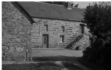
Vue de situation prise du sud ouest Phot. Brulon IVR53_19662200634Z
