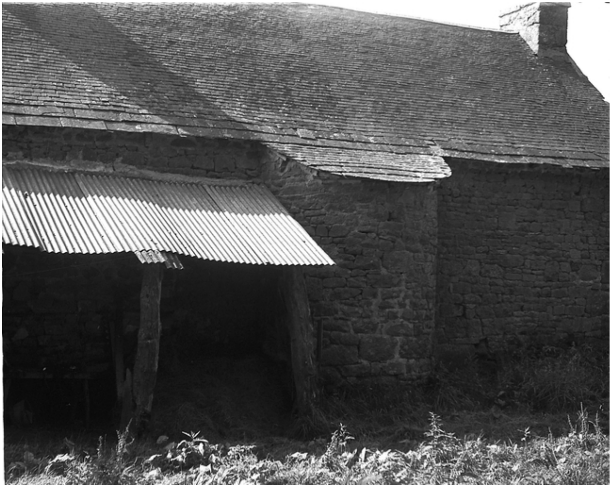
Façade nord : détail de la tourelle
