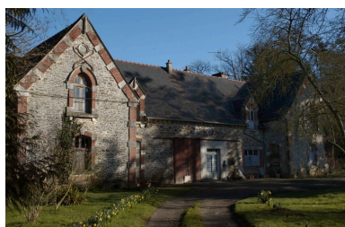
Les commons : vue générale sud-est Phot. Guy Artur, Phot. Norbert Lambart IVR53_20033500528NUCA
