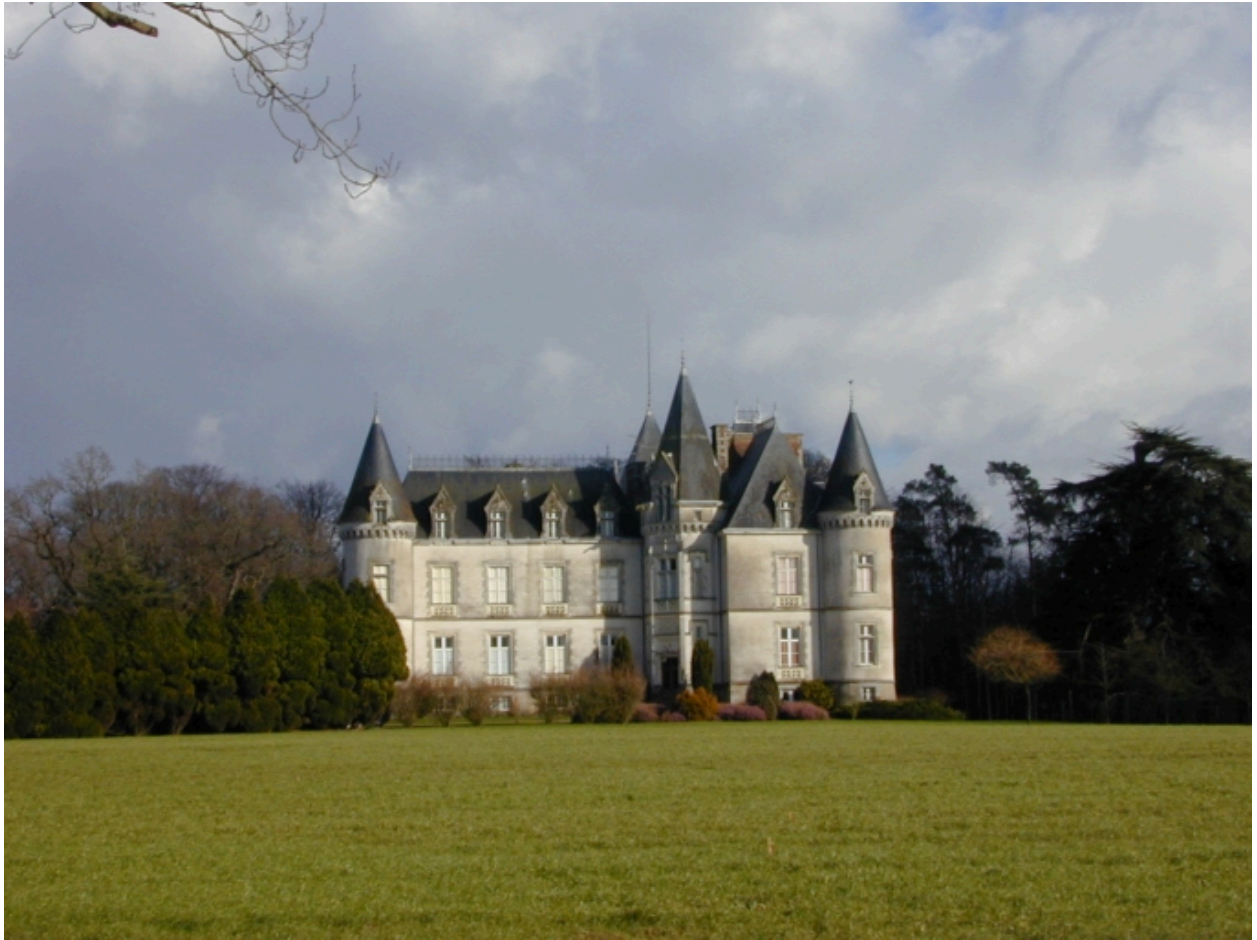
Vue de situation sud-ouest
