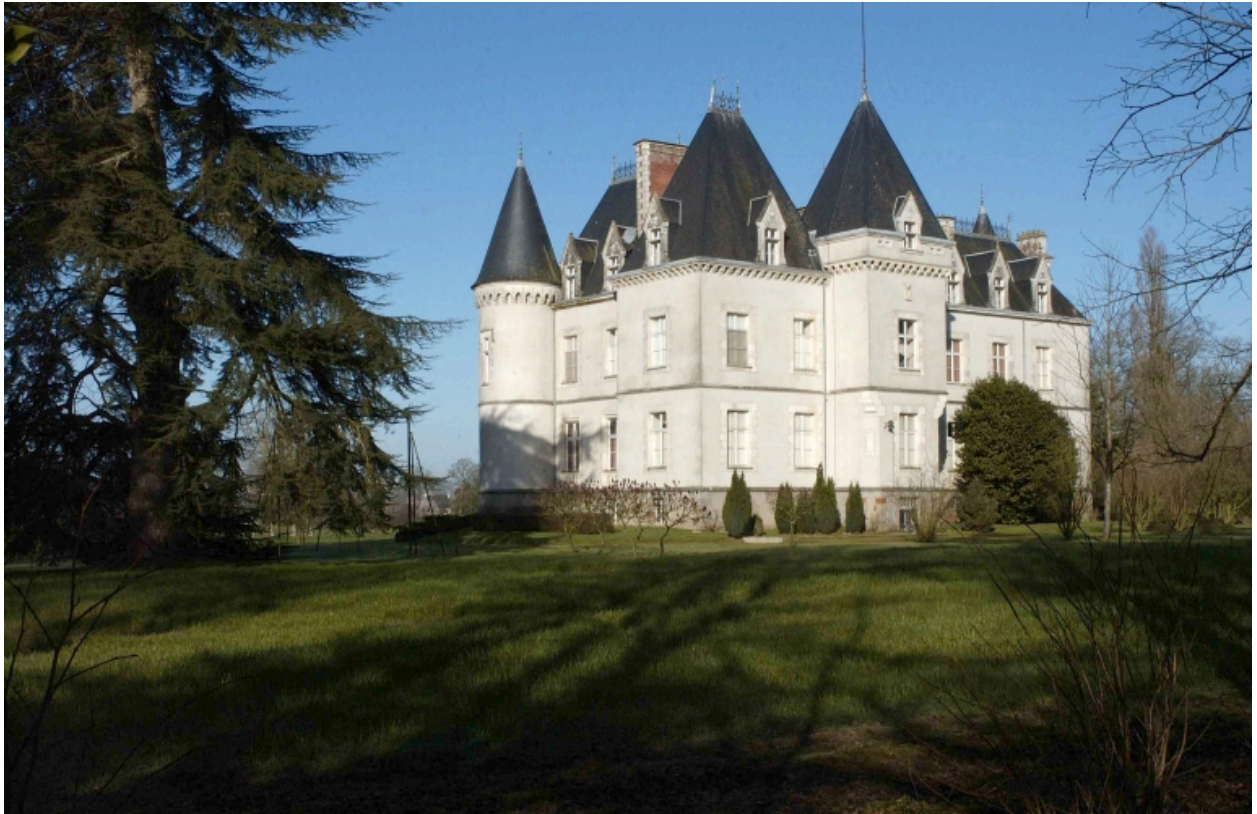
Vue générale nord-est
