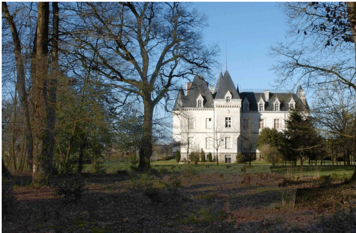
Vue générale nord
