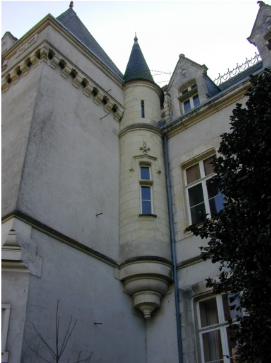
Tourelle en poivrière du pavillon nord : détail
