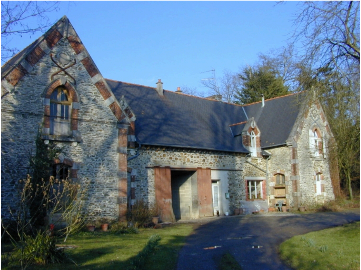
Les communs : vue générale sud-est
