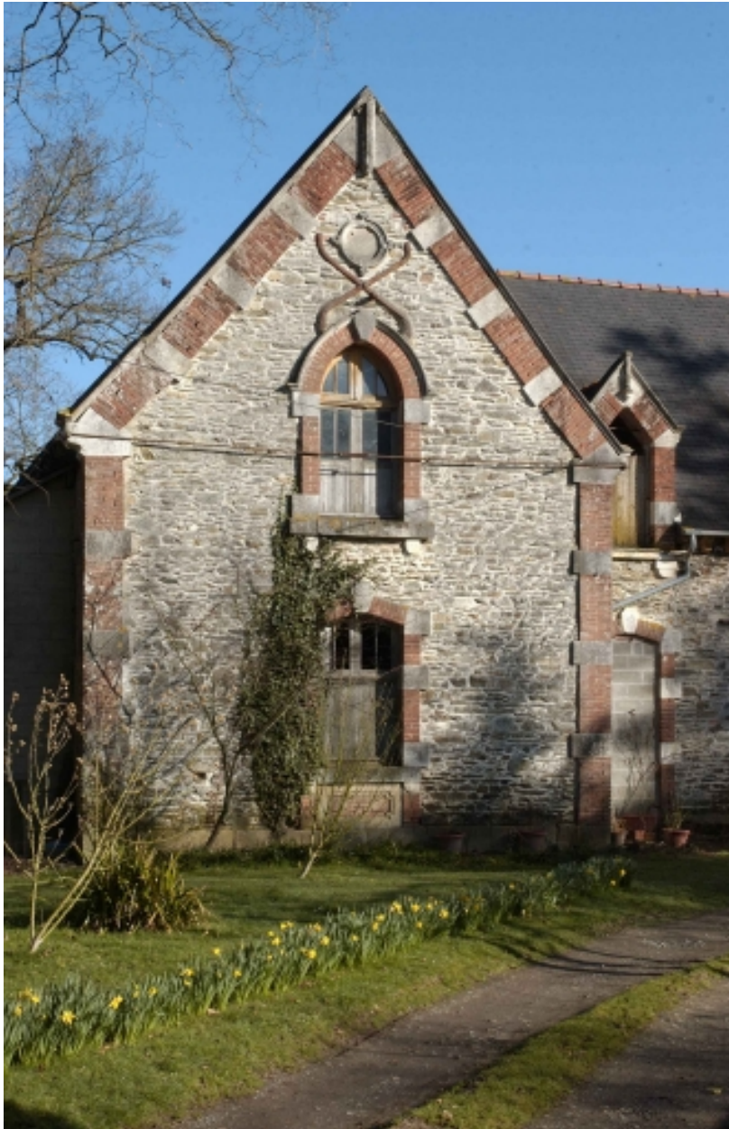
Les communs, façade-pignon de l'aile sud : vue générale
