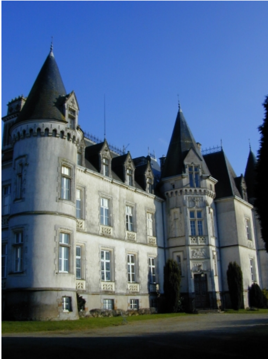
Vue partielle sud-ouest
