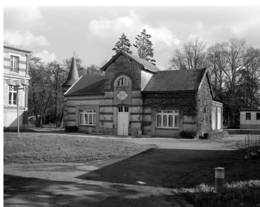
Elévation ouest des écuries. Phot. Guy Artur IVR53_20003500404X
