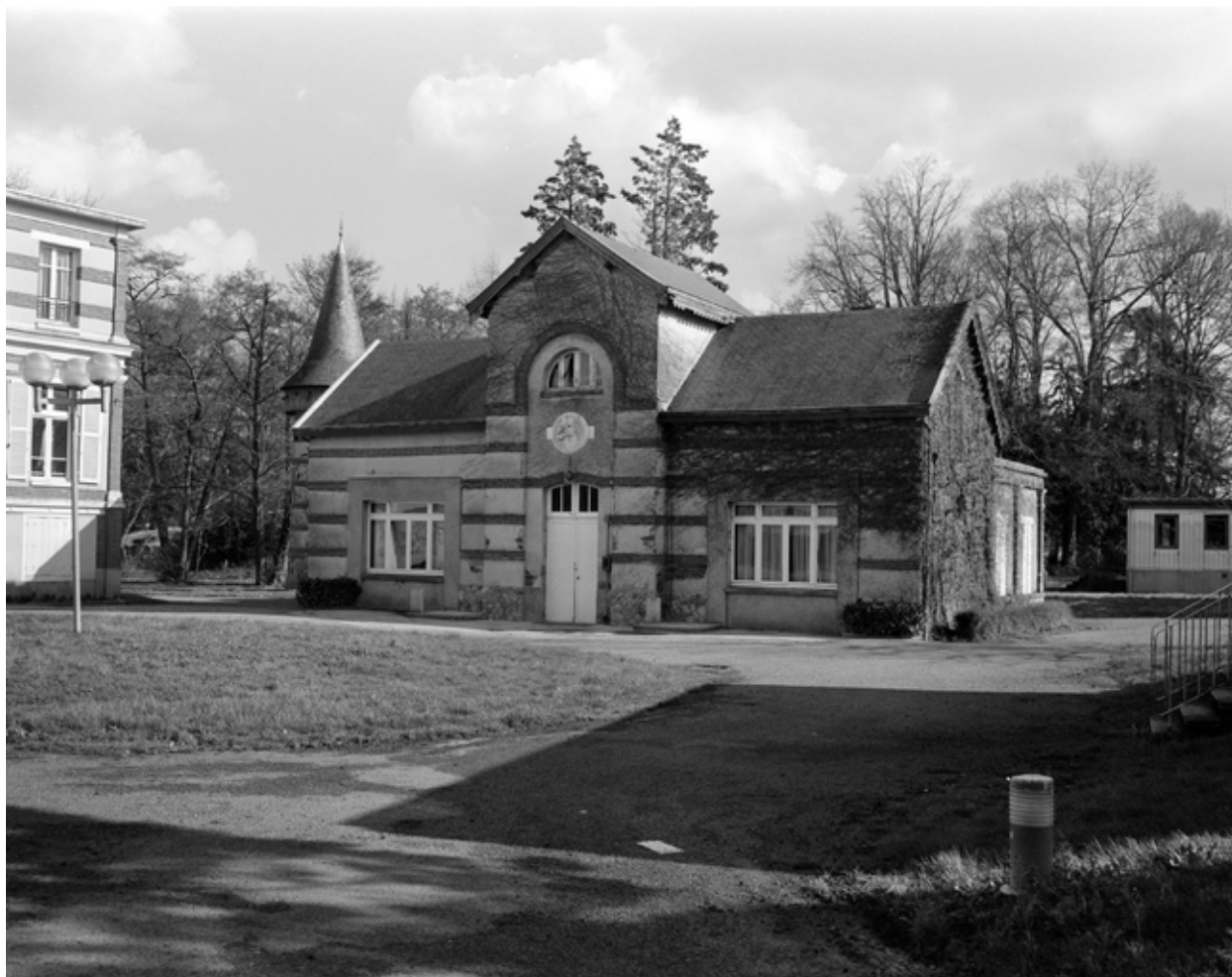
Elévation ouest des écuries.
