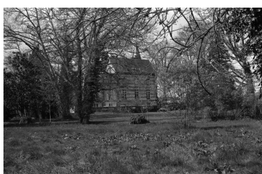
Château de la Janais : vue depuis la propriété Phot. Sylvie Laffiché, Phot. Marie-Madeleine Tugores IVR53_19753506074Z
