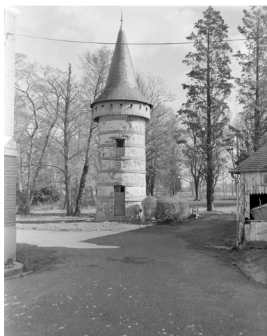
Elévation ouest du pigeonnier. Phot. Guy Artur IVR53_20003500409X
