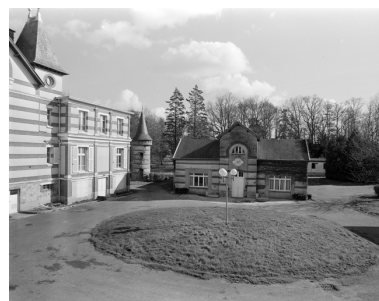
Elévation ouest des écuries. Phot. Guy Artur IVR53_20003500410X
