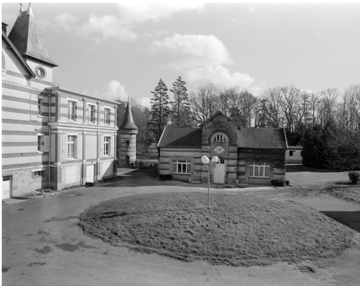
Elévation ouest des écuries.
