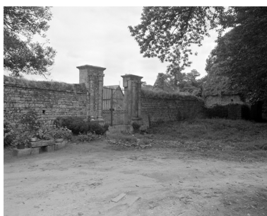
Communs : détail de l'entrée Phot. Guy Artur IVR53_19752200053X
