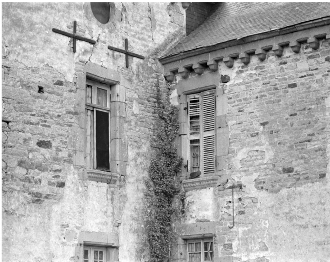
Logis, face ouest : détail fenêtre
