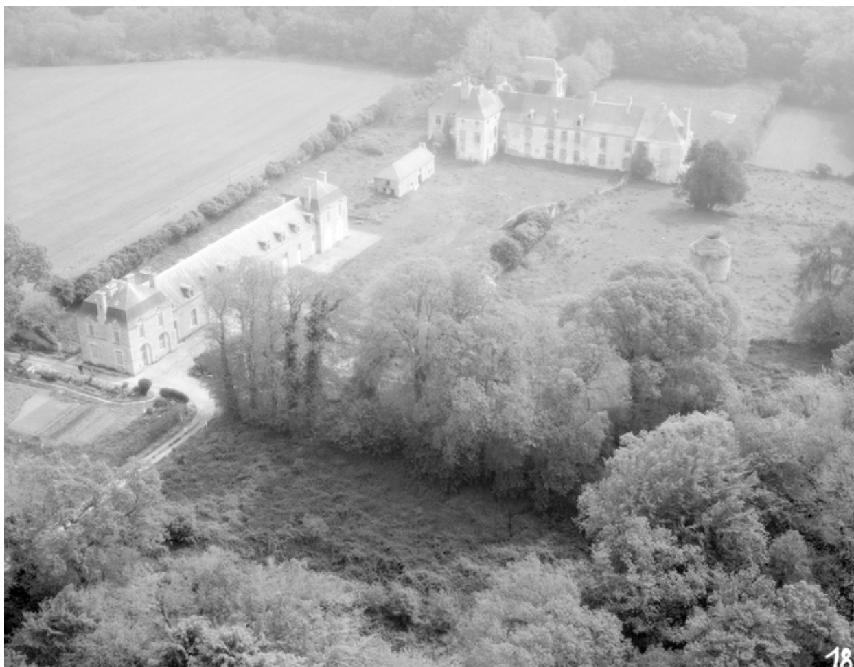
Vue aérienne : vue générale nord
