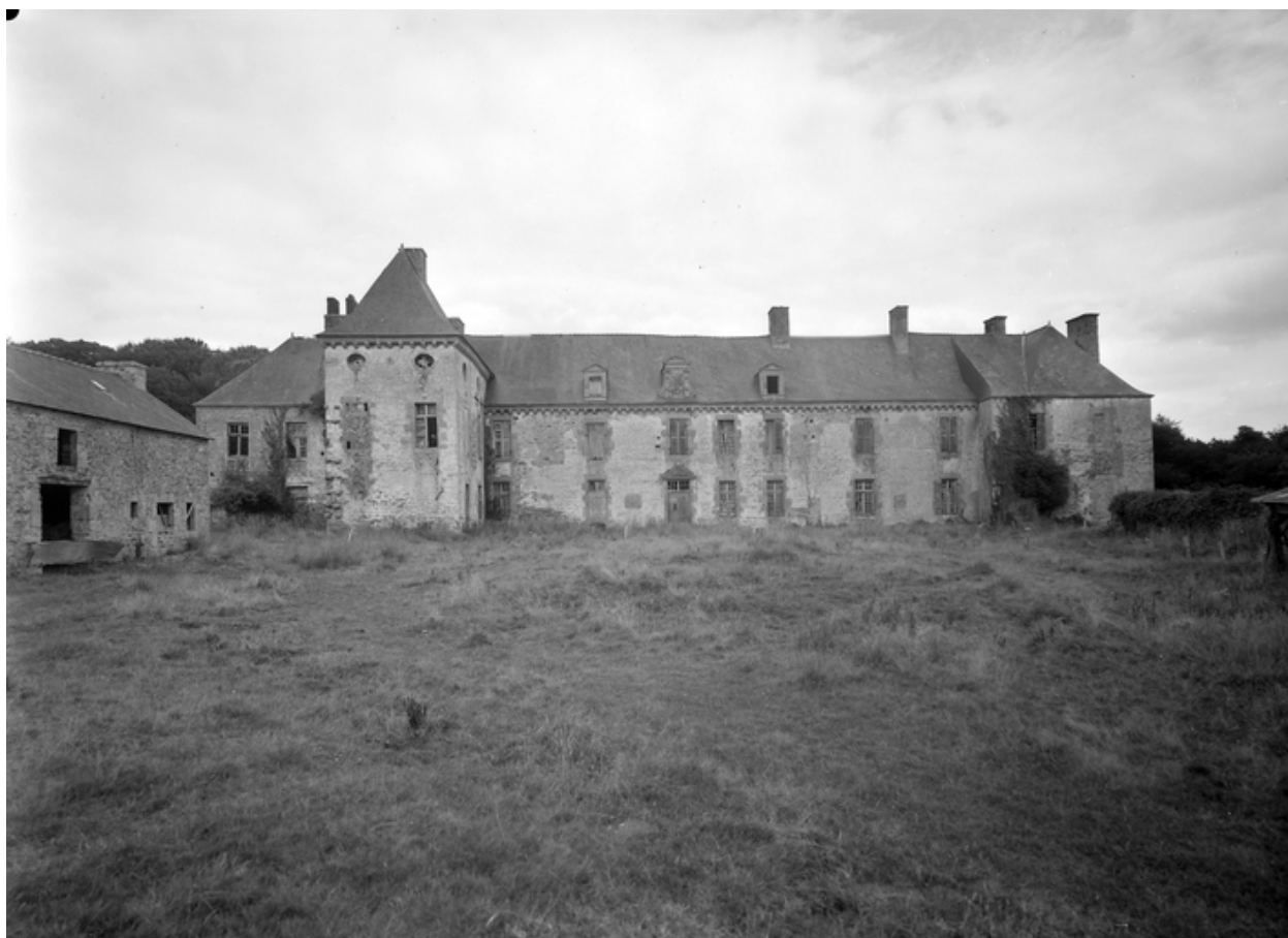
Communs : pignon ouest
