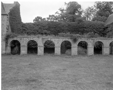
Galerie : détail Phot. Guy Artur IVR53_19752200055X
