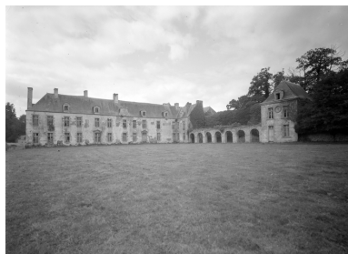
Colombier : voûte et mur à niches Phot. Guy Artur IVR53_19752200047V
