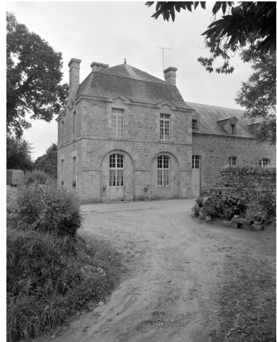
Galerie (aile est-ouest) : façade sud Phot. Guy Artur IVR53_19752200035X
