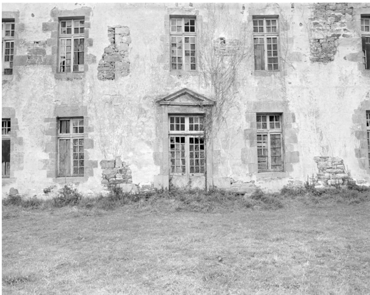
Logis principal : porte nord
