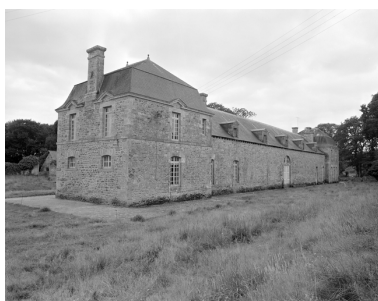
Communs : vue d'un pavillon d'angle (sud-est) Phot. Guy Artur IVR53_19752200043X
