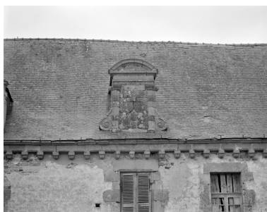
Logis, face ouest : détail lucarne Phot. Guy Artur IVR53_19752200036X
