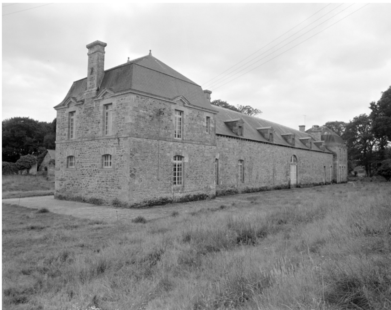
Communs : vue d'un pavillon d'angle (sud-est)
