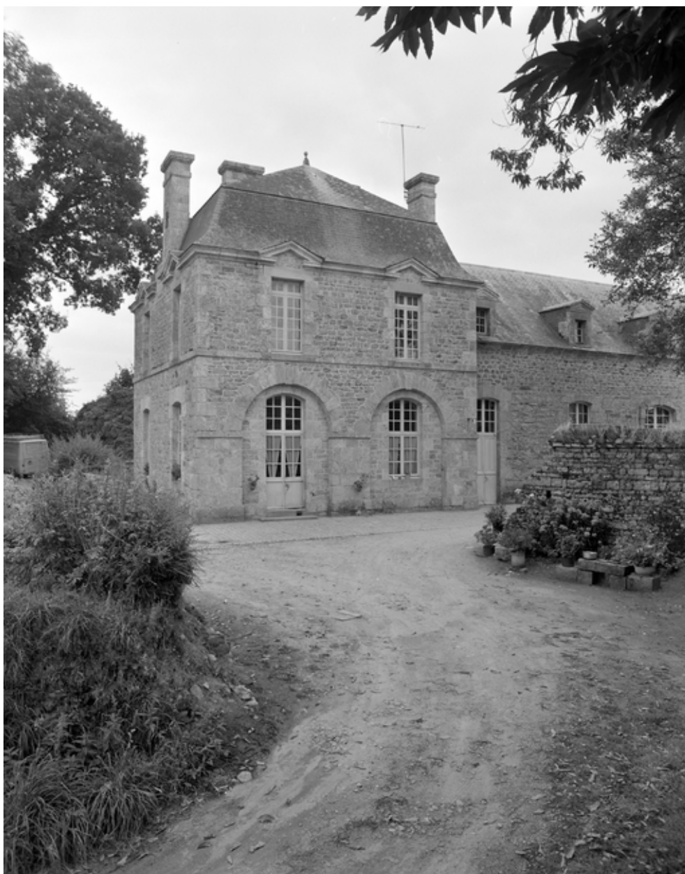
Galerie (aile est-ouest) : façade sud
