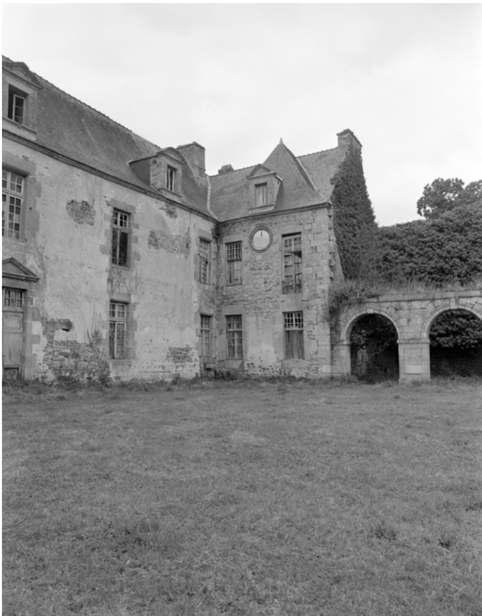
Aile est-ouest, corps de bâtiment secondaire : face sud
