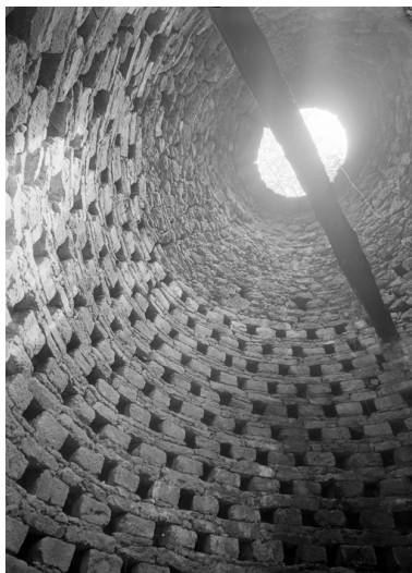
Colombier : voûte et mur à niches Phot. Guy Artur IVR53_19752200049V
