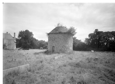
Colombier : vue générale Phot. Guy Artur IVR53_19752200044V
