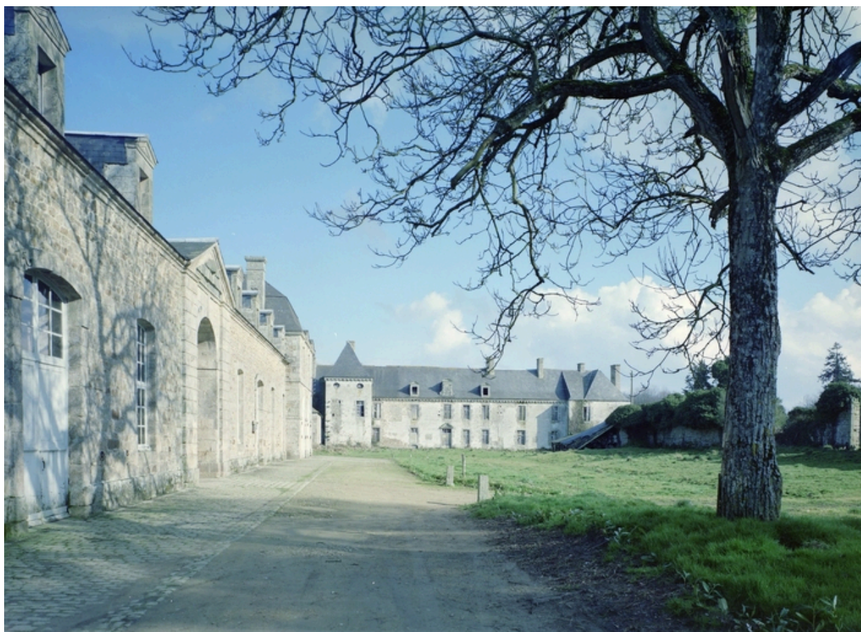
Vue prise de l'accès
