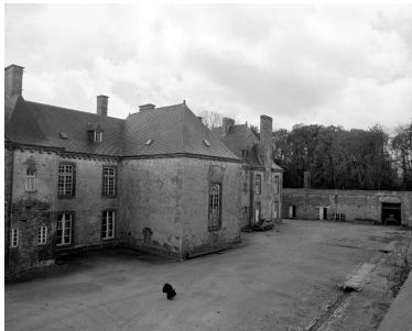
Logis, élévation nord et cour. Phot. Guy Artur IVR53_19822900390X
