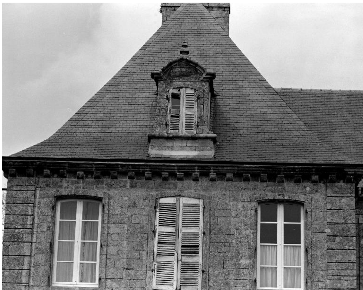
Elévation sud, aile gauche, lucarne.
