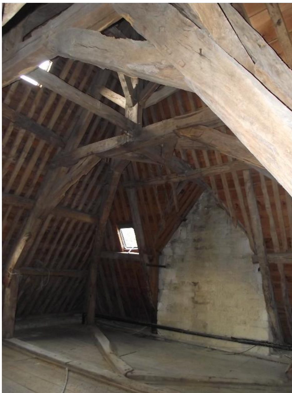
Etage sous comble, château du Guilguiffin
