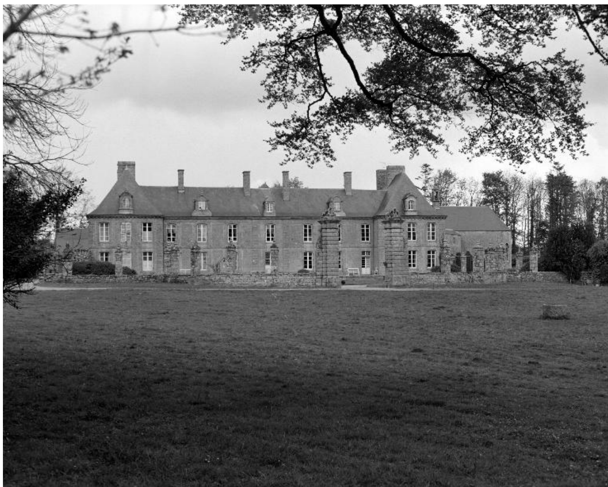
Vue générale prise du sud.
