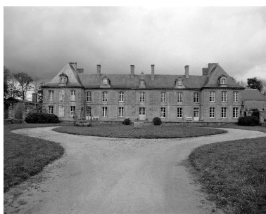
Logis, élévation sud. Phot. Guy Artur IVR53_19822900393X
