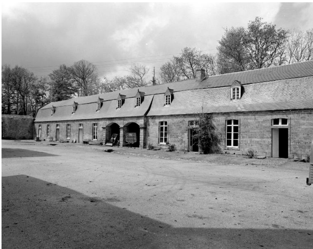
Communs, élévation sud, vue générale.
