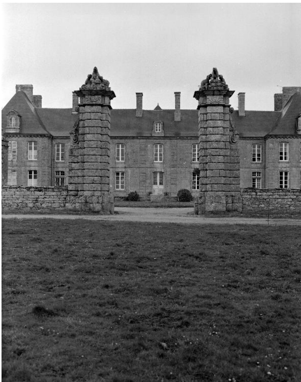
Piliers d'entrée, vue générale.
