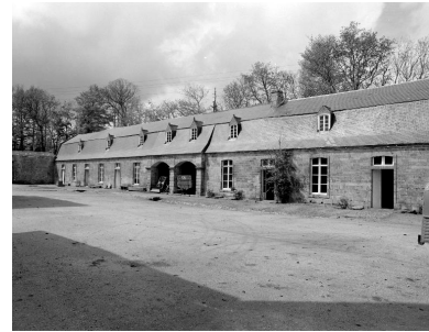
Communs, élévation sud, vue générale. Phot. Guy Artur IVR53_19822900387X
