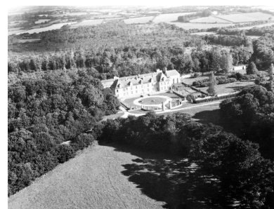
Vue aérienne sud Phot. Guy Artur IVR53_19812900052X
