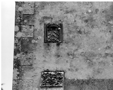
Chapelle, élévation ouest, blason. Phot. Guy Artur, Phot. Norbert Lambart IVR53_19822900385X
