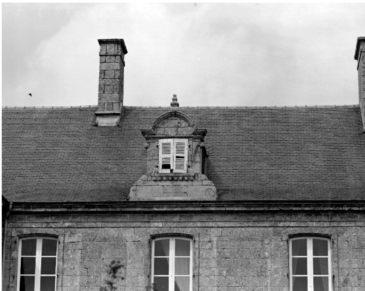
Elévation sud, corps central, lucarne.
