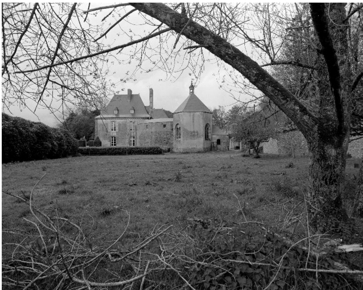
Elévation est, logis et chapelle.
