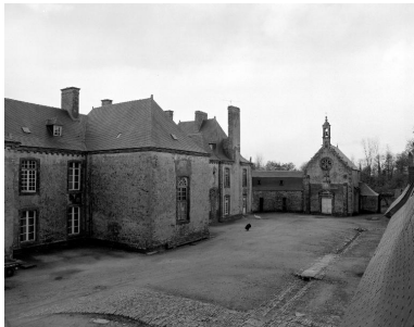
Logis, élévation nord et chapelle. Phot. Guy Artur IVR53_19822900389X
