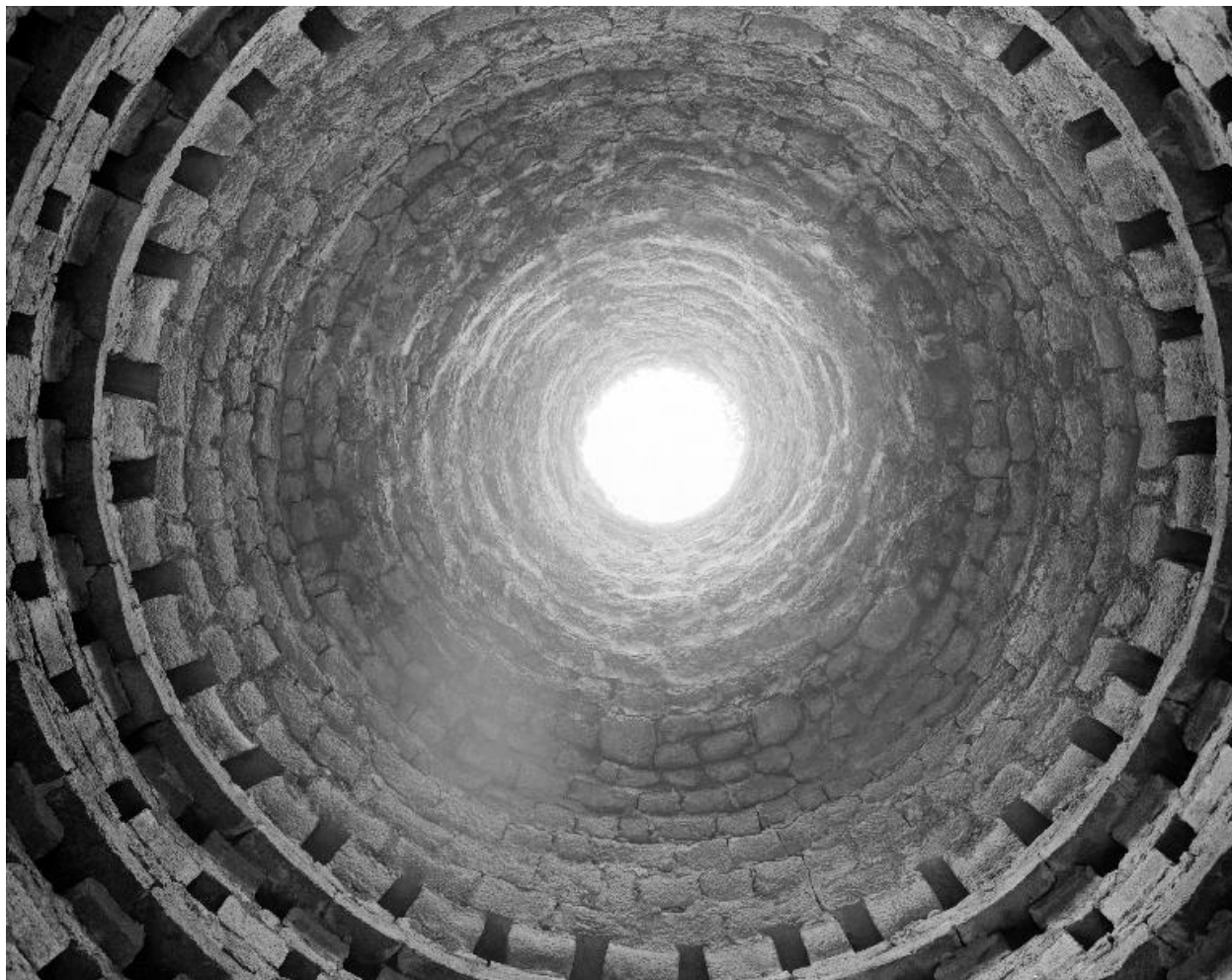
Colombier, vue intérieure.
