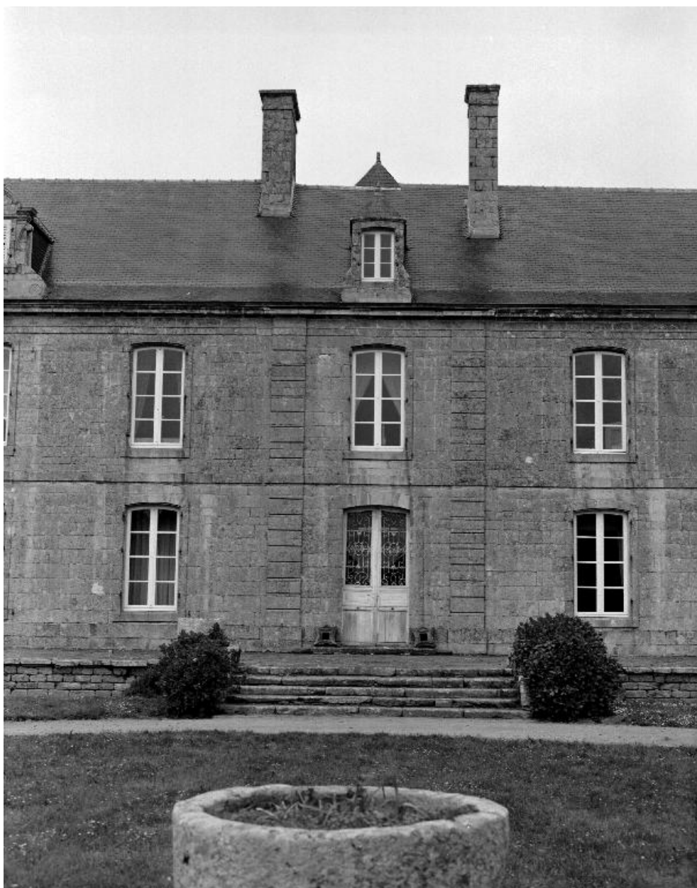
Logis, élévation sud, travée centrale (état en 1982)
