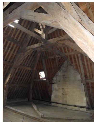
Etage sous comble, château du Guilguiffin Phot. Philippe Davy IVR53_20172905701NUCA
