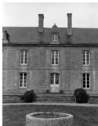
Logis, élévation sud, travée centrale (état en 1982) Phot. Guy Artur IVR53_19822900382X
