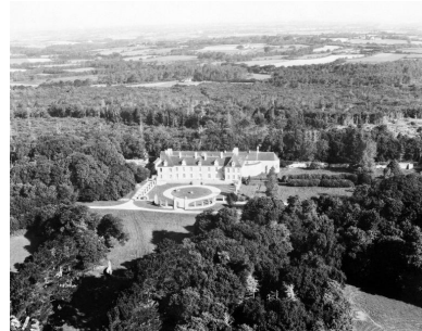
Vue aérienne sud Phot. Guy Artur IVR53_19812900053X
