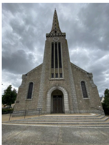
Vue ouest Phot. Baptiste Oligo IVR53_20255610859NUCA
