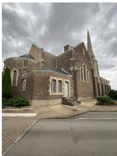
Vue sud-est Phot. Baptiste Oligo IVR53_20255610856NUCA
