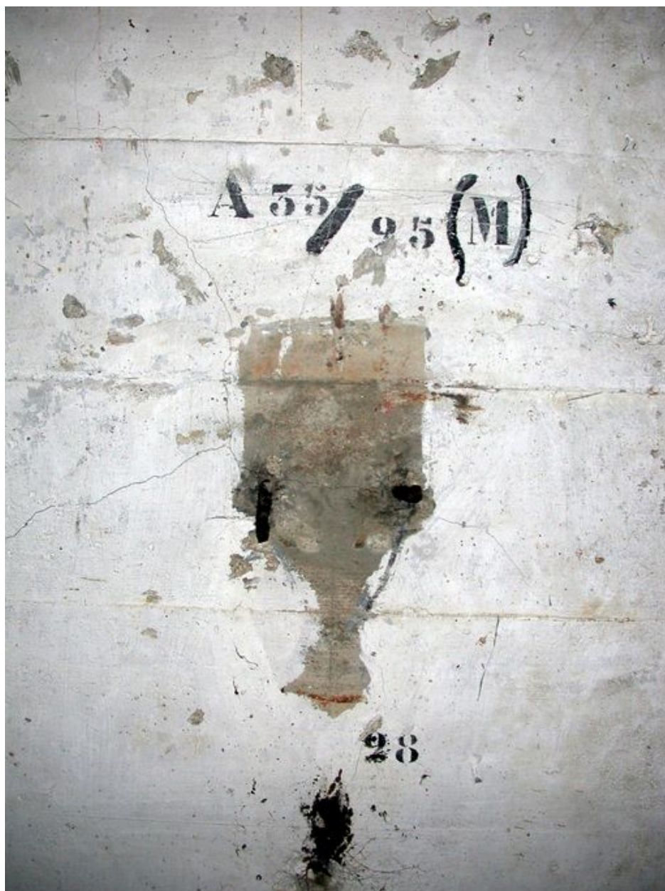
Vue intérieure : détail de la numérotation (état en 2003). Juste en dessous se trouvait le boîtier de connexion téléphonique
