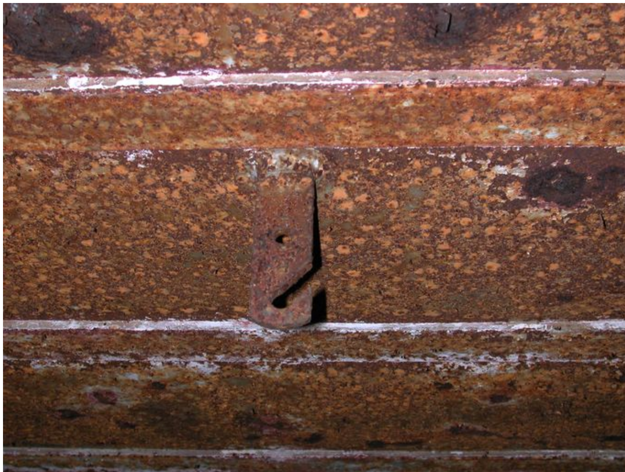
Vue intérieure : détail de l'un des crochets de couchettes de la salle de garde/pièce de vie (état en 2003)
