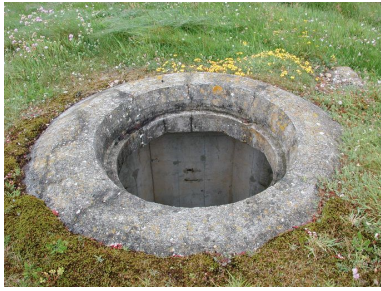
Vue du poste d'observation dit Tobruk (état en 2003) Phot. Guillaume Lécueillier IVR53_20032902486NUCA
