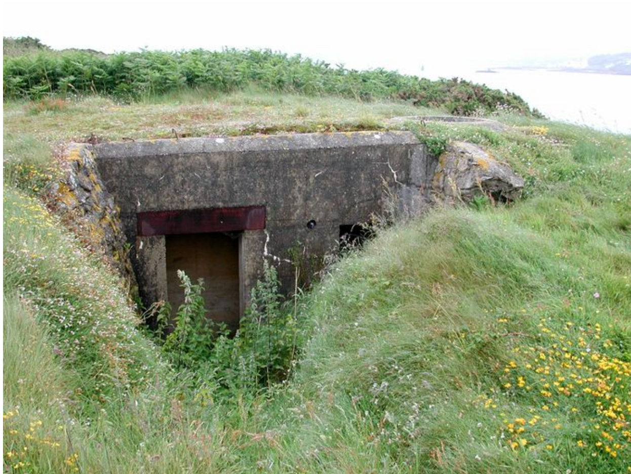
Vue de l'entrée sud (état en 2003)
