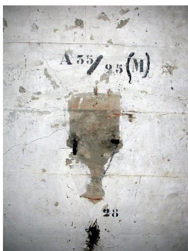
Vue intérieure : détail de la numérotation (état en 2003). Juste en dessous se trouvait le boîtier de connexion téléphonique Phot. Guillaume Lécueillier IVR53_20032902483NUCA
