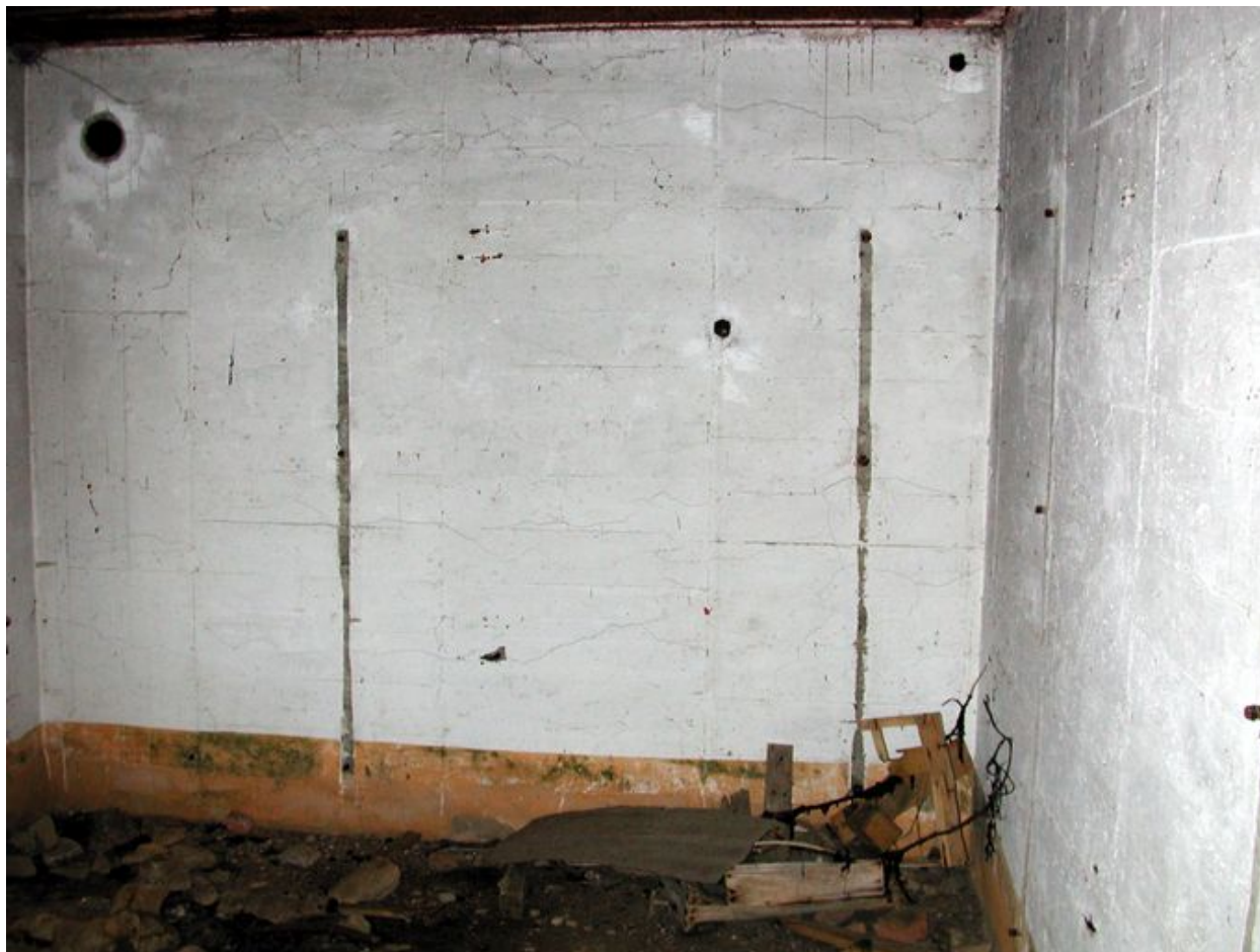
Vue intérieure : salle de garde/pièce de vie (état en 2003). Les murs ont conservé leurs peintures d'origine
