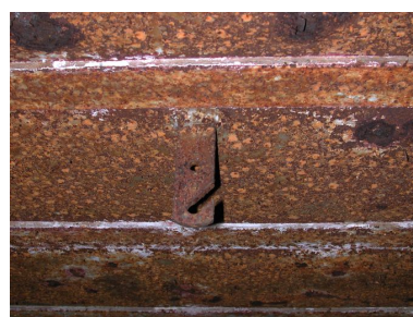
Vue intérieure : détail de l'un des crochets de couchettes de la salle de garde/pièce de vie (état en 2003) Phot. Guillaume Lécueillier IVR53_20032902485NUCA
