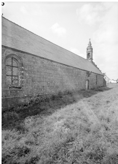
Face nord : vue générale Phot. François Dagorn IVR53_19752200423V
