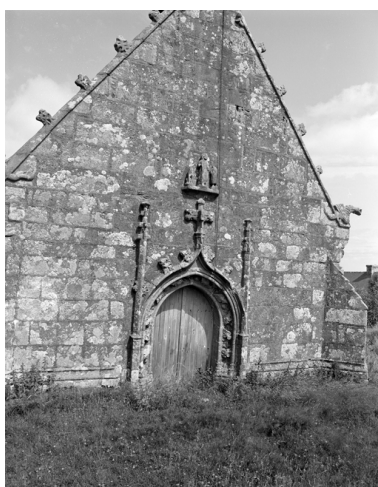
Face ouest : détail de la porte Phot. François Dagorn IVR53_19752200433X
