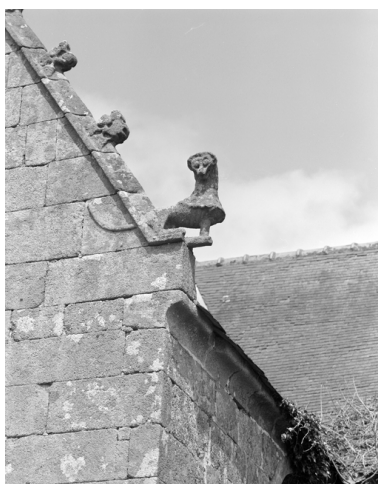
Détail des crossettes de rampants nord et sud Phot. François Dagorn IVR53_19752200428X
