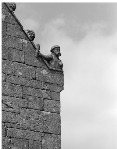
Chevet : détail des crosettes de rampants nord et sud Phot. François Dagorn IVR53_19752200427X
