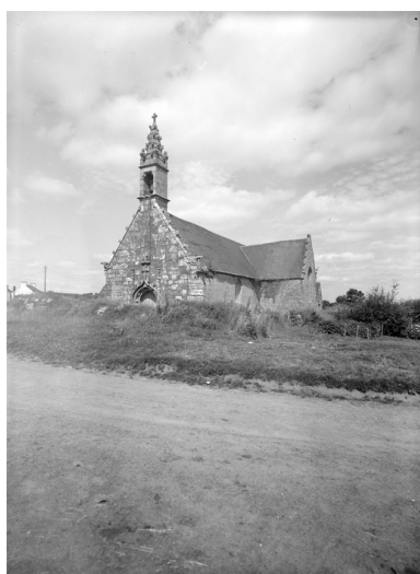
Face sud-ouest : vue générale Phot. François Dagorn IVR53_19752200421V
