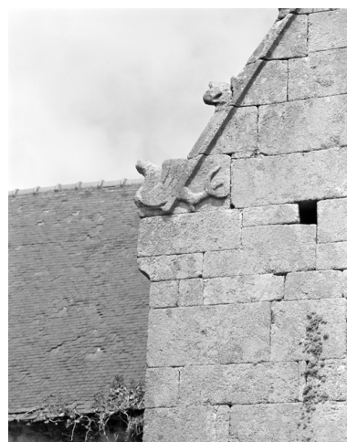
Détail des crossettes de rampants nord et sud Phot. François Dagorn IVR53_19752200429X
