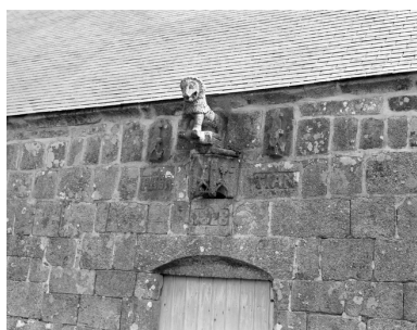
Face nord : détail porte et fleuron la surmontant Phot. François Dagorn IVR53_19752200434X
