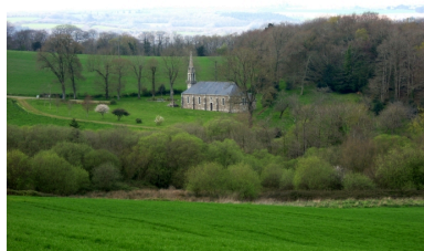
Dinéault, chapelle Saint-Dispar : vue de situation depuis le sud-est Phot. Gwénaél Fauchille IVR53_20082905589NUCA
