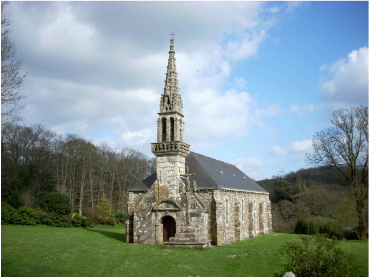
Dinéault, chapelle Saint-Dispar : vue générale sud-ouest
