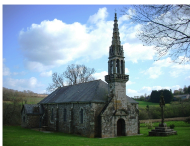
Dinéault, chapelle Saint-Dispar : vue générale nord-ouest Phot. Gwénaél Fauchille IVR53_20082905593NUCA
