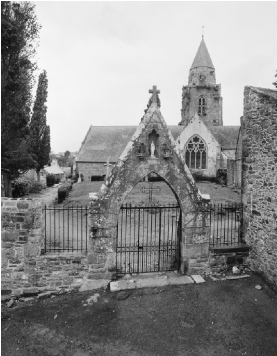
Elévation sud, portail : vue générale
