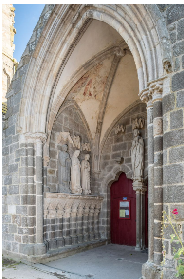
Le porche nord, vue générale Phot. Charlotte Barraud IVR53_20213501120NUCA
