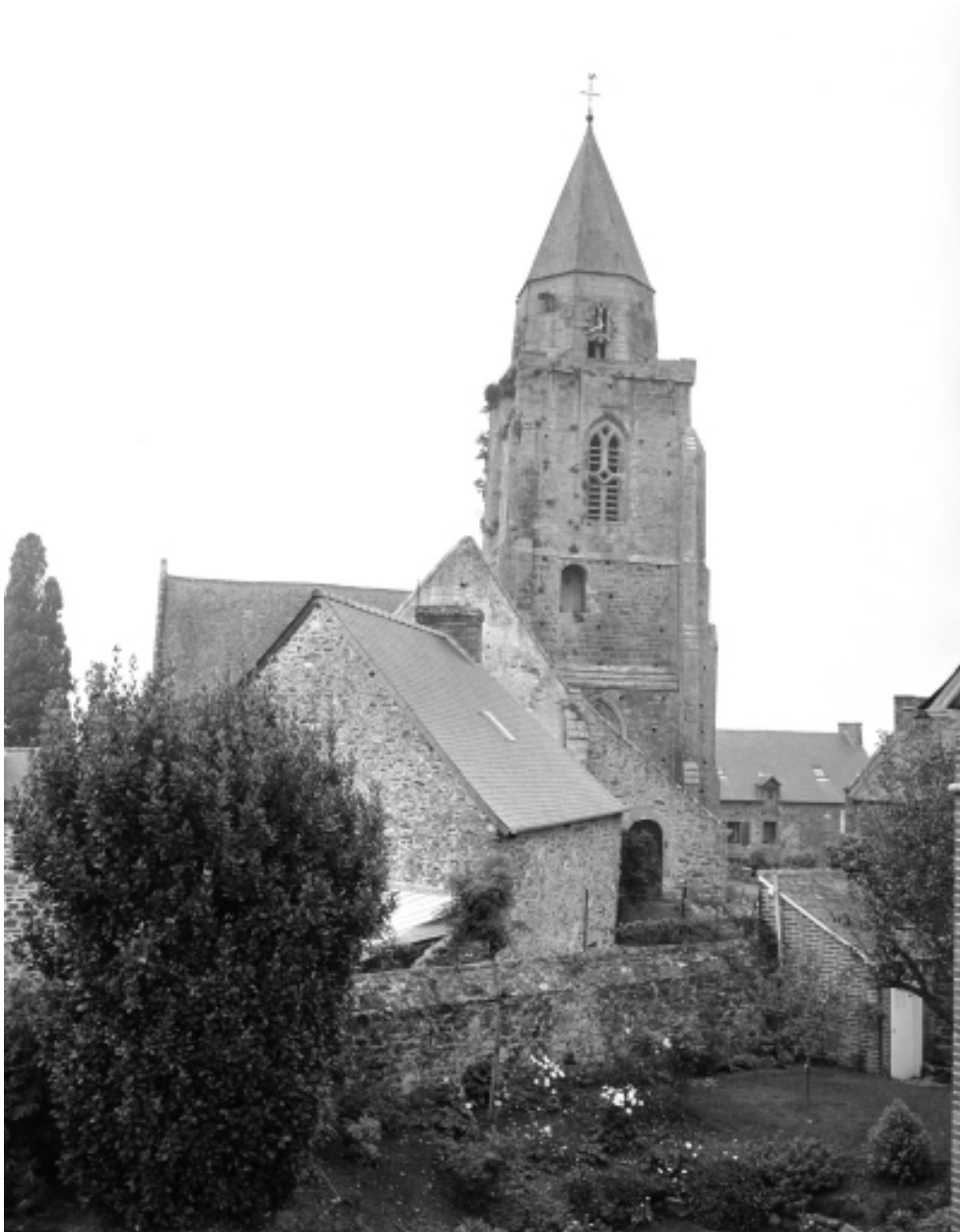
Elévation est : vue générale
