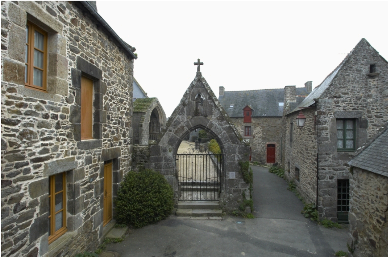
Enclos du cimetière, portail nord, rue de la Grande Cohue
