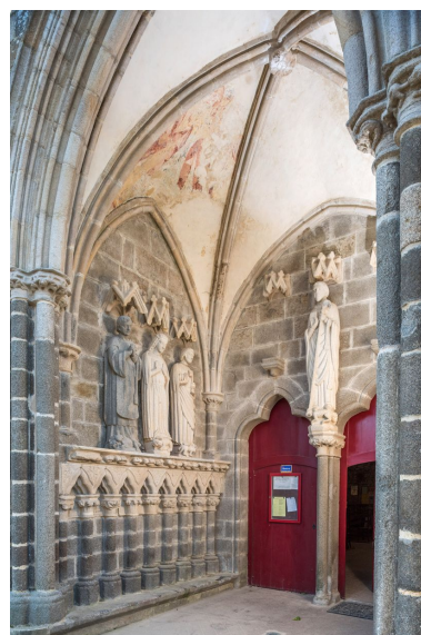
Le porche nord, vue générale Phot. Charlotte Barraud IVR53_20213501121NUCA
