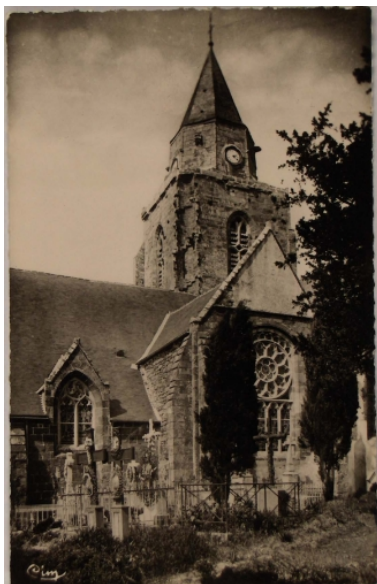
Elévation sud. (Carte postale ancienne, A.D.35 : 6Fi 07) Repro. Véronique Orain, Repro. Archives départementales d'Ile-et-Vilaine IVR53_20063517182NUCA
