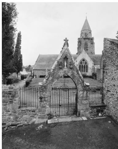
Elévation sud, portail : vue générale Phot. Guy Artur, Phot. Norbert Lambart IVR53_19943501908X
