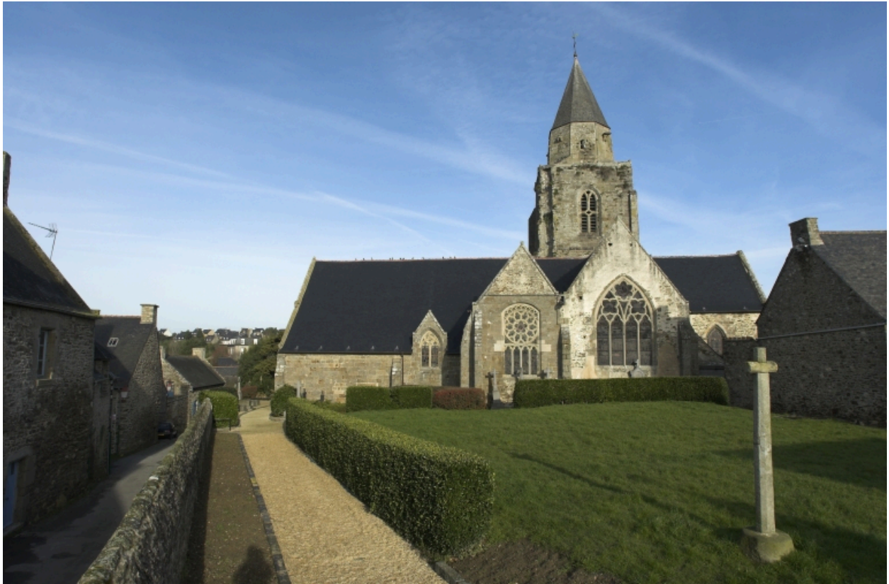
Vue générale sud
