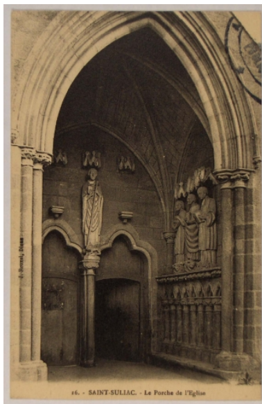
Porche nord, vue de trois quart. (A.D.35 : 6Fi 09) Repro. Véronique Orain, Repro. Archives départementales d'Ille-et-Vilaine IVR53_20063517180NUCA
