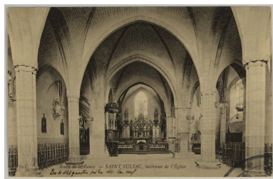
Vue intérieure. (Carte postale ancienne, A.D.35 : 6Fi 17) Repro. Véronique Orain, Repro. Archives départementales d'Ille-et-Vilaine IVR53_20063517176NUCA
