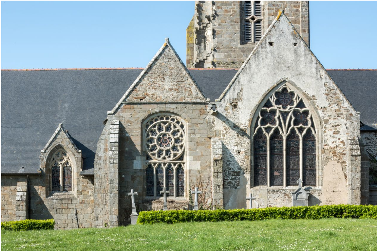
Succession de pignons et réseaux du XIVe-XVe siècles sur la façade méridionale
