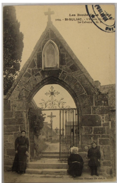
Enclos du cimetière, portail nord avec grille. (Carte postale ancienne, A.D.35 : 6Fi 12) Repro. Véronique Orain, Repro. Archives départementales d'Ille-et-Vilaine IVR53_20063517177NUCA
