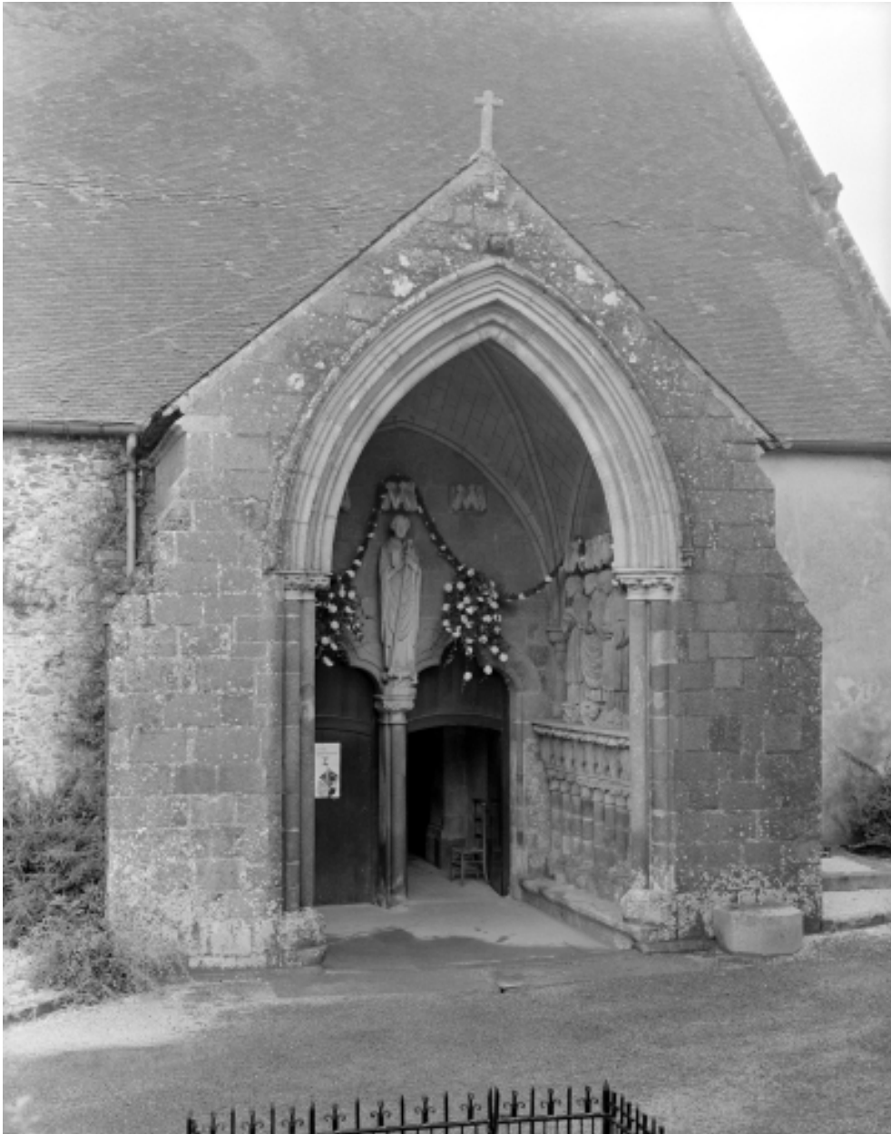
Elévation nord, porche : vue générale
