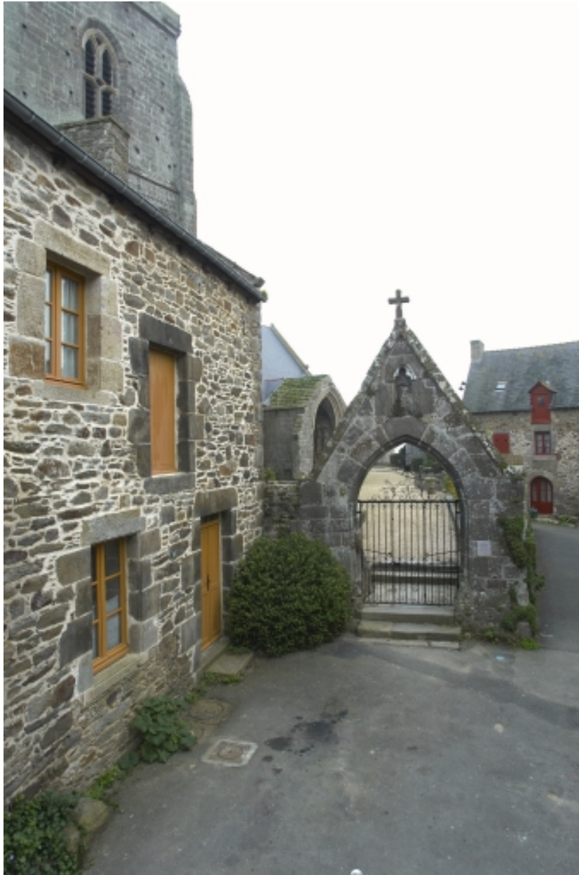
Enclos du cimetière, portail nord, rue de la Grande Cohue
