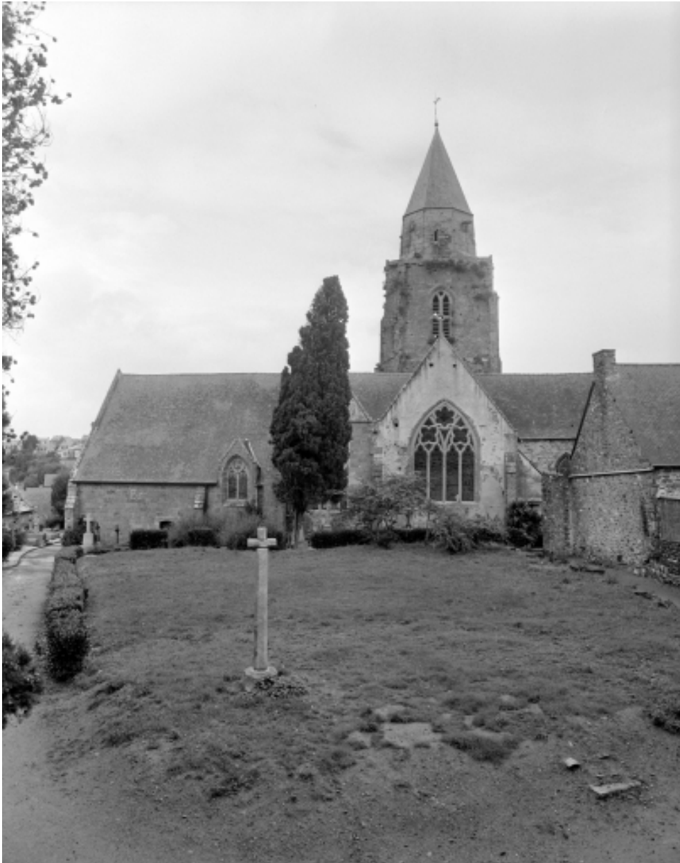
Elévation sud : vue générale
