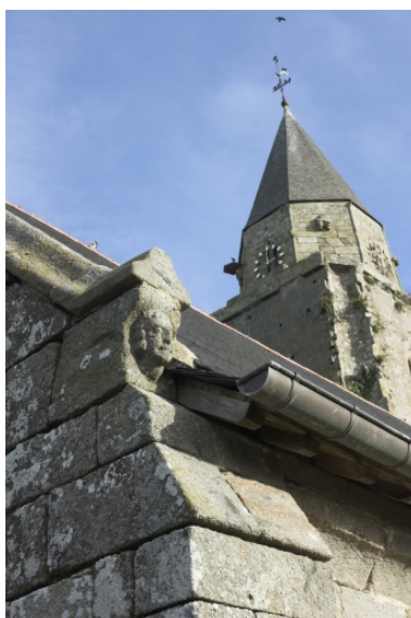
Amortissement de pignon avec tête sculptée Phot. Bernard Bègne IVR53_20073500067NUCA
