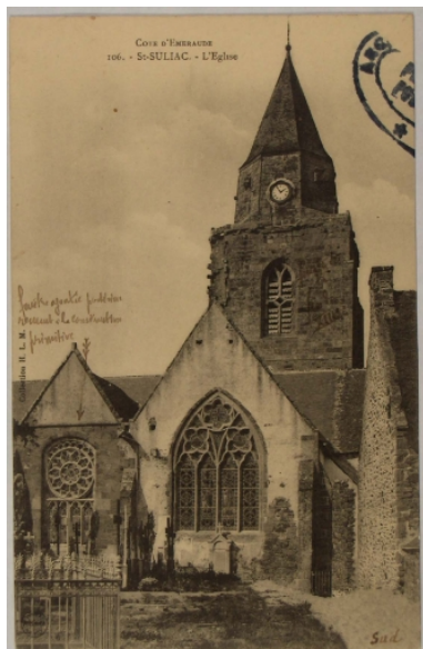
Elévation sud. (Carte postale ancienne, A.D.35 : 6Fi 03) Repro. Véronique Orain, Repro. Archives départementales d'Ile-et-Vilaine IVR53_20063517186NUCA
