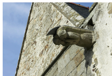
Gargouille sud, à personnages Phot. Bernard Bègne IVR53_20073500066NUCA
