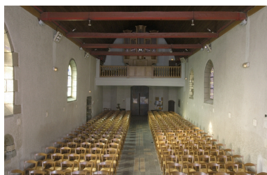
Vue intérieure prise du chœur vers la nef Phot. Alain Dagorn IVR53_20053500492NUCA
