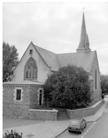
Vue générale nord est Phot. Guy Artur, Phot. Norbert Lambart IVR53_19943501524X
