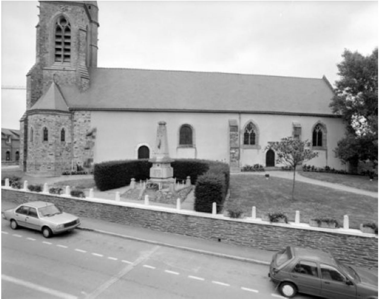
Vue générale sud
