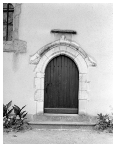
Mur sud ; partie est, porte
