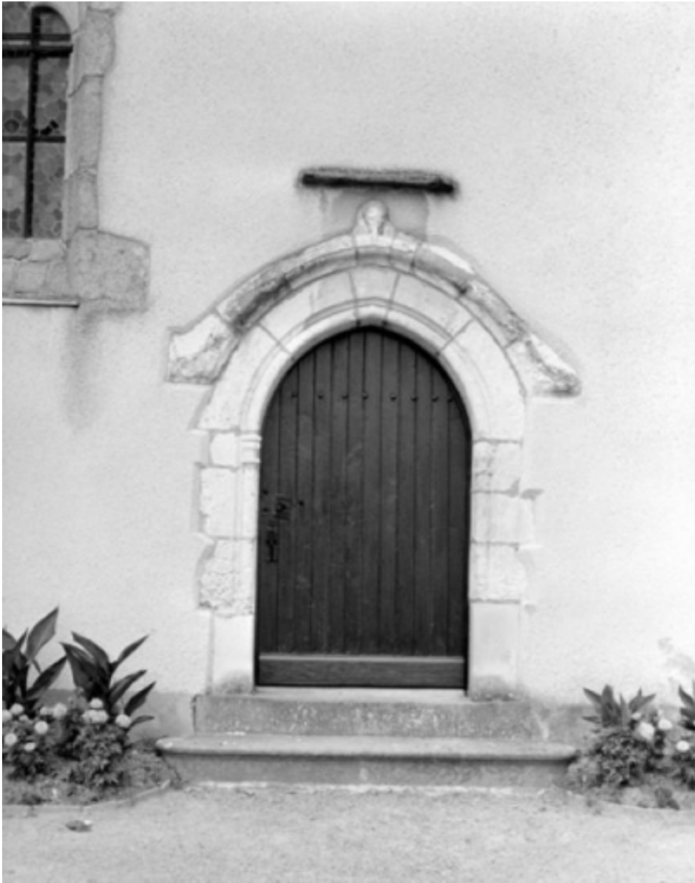
Mur sud ; partie est, porte
