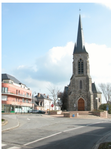
Vue générale ouest Phot. Claude Quillivic IVR53_20053505265NUCA
