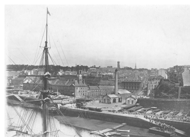
Vue de l'arsenal de Brest vers 1880 : porte Tourville, magasin de la machine d'épuisement (pompe), forme de construction, bassin de radoub de Troulan dit forme de Brest, magasin général. Axe de la rue Pasteur Repro. Archives municipales et communautaires. Brest Métropole Océane, Phot. Guillaume (retouche) Lécueillier, Autr. Auteur inconnu IVR53_20082908753NUC
