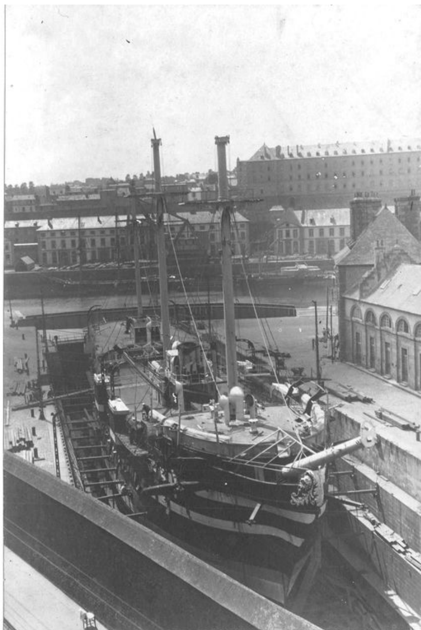
Vue de l'arsenal de Brest vers 1880 : forme de construction, bassin de radoub de Troulan dit forme de Brest
