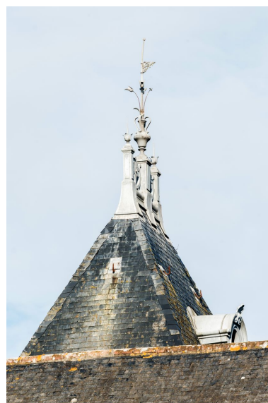
Détail d'un épi de faitage, escalier nord Phot. Charlotte Barraud IVR53_20222200011NUCA
