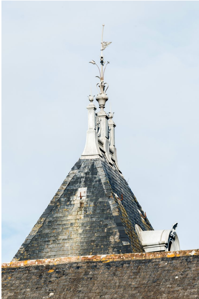
Détail d'un épi de faîtage, escalier nord
