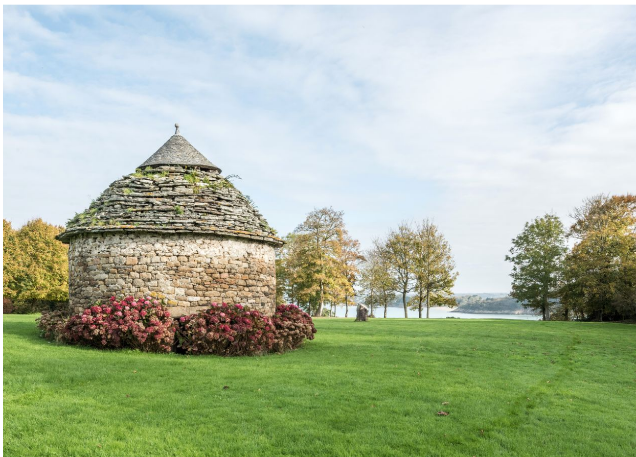
Vue générale du colombier
