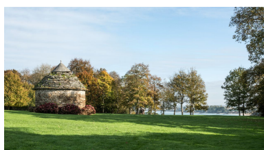
Vue de situation du colombier surplombant l'Arguenon à l'est du château Phot. Charlotte Barraud IVR53_20222200013NUCA
