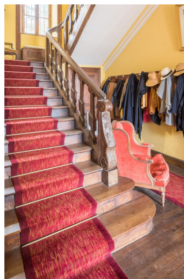
Vue intérieure, départ de l'escalier à balustres de section carrée Phot. Charlotte Barraud IVR53_20222200447NUCA
