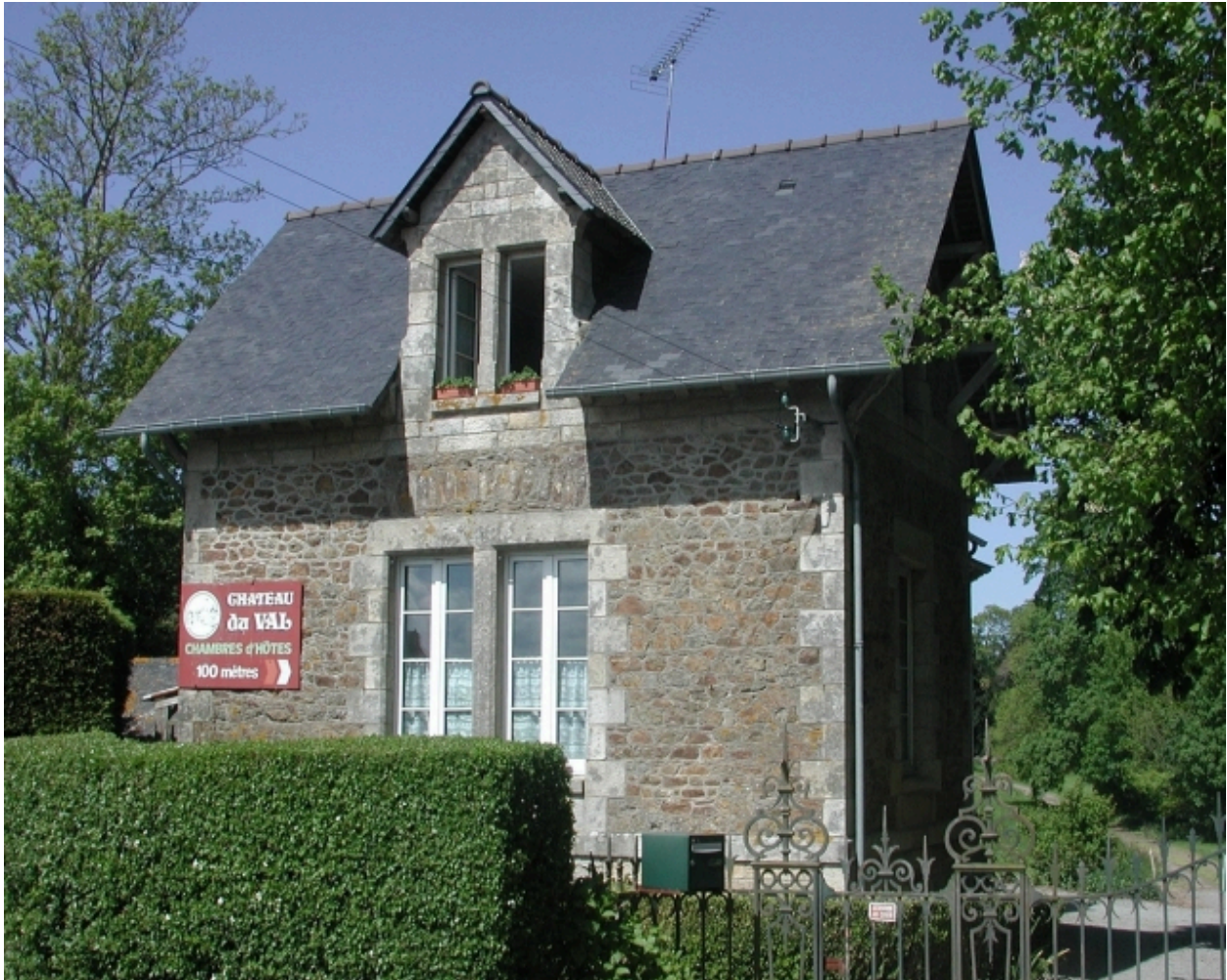
Conciergerie. Vue prise côté sud.
