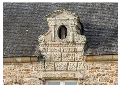
Détail d'une lucarne ornée de pilastres et volutes, coiffée d'un fronton triangulaire Phot. Charlotte Barraud IVR53_20222200001NUCA
