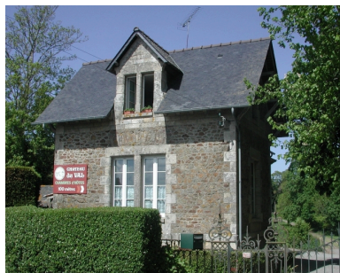
Conciergerie. Vue prise côté sud.
