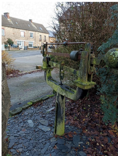
Appareil de mesure, 1 Rue de la Bascule IVR53_20263510454NUCA
