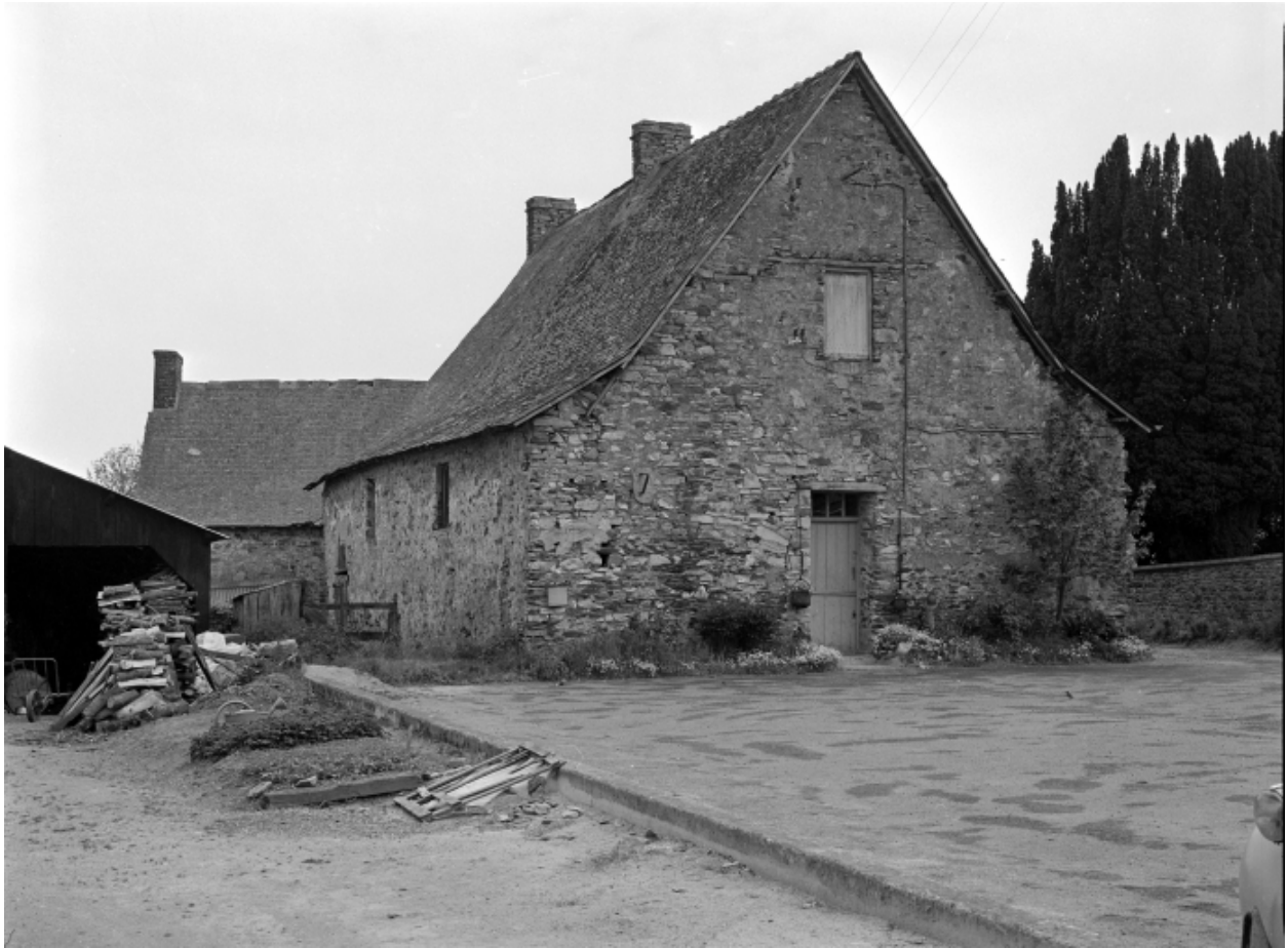
Elévation ouest, vue générale.
