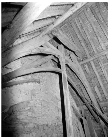
Ancienne charpente. Phot. Jean-Pierre Ducouret IVR53_19803500598X
