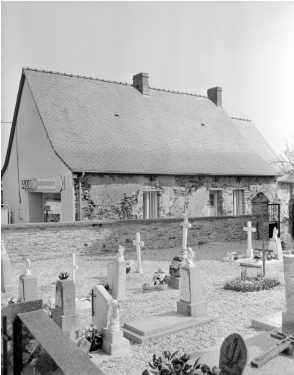
Elévation latérale : vue générale
