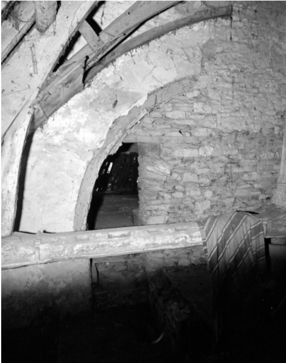
Détail de charpente.
