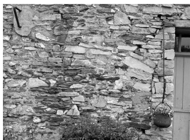
Pignon ouest, détail de l'appareil et trace d'une ancienne porte en plein cintre. Phot. Jean-Pierre Ducouret IVR53_19803500655X
