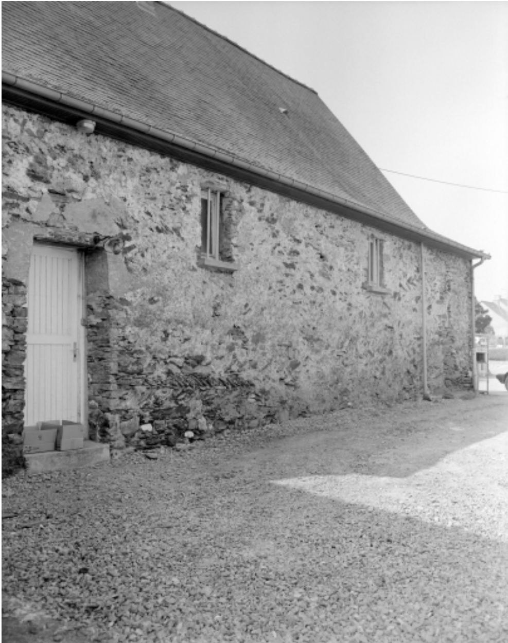
Elévation latérale : vue générale
