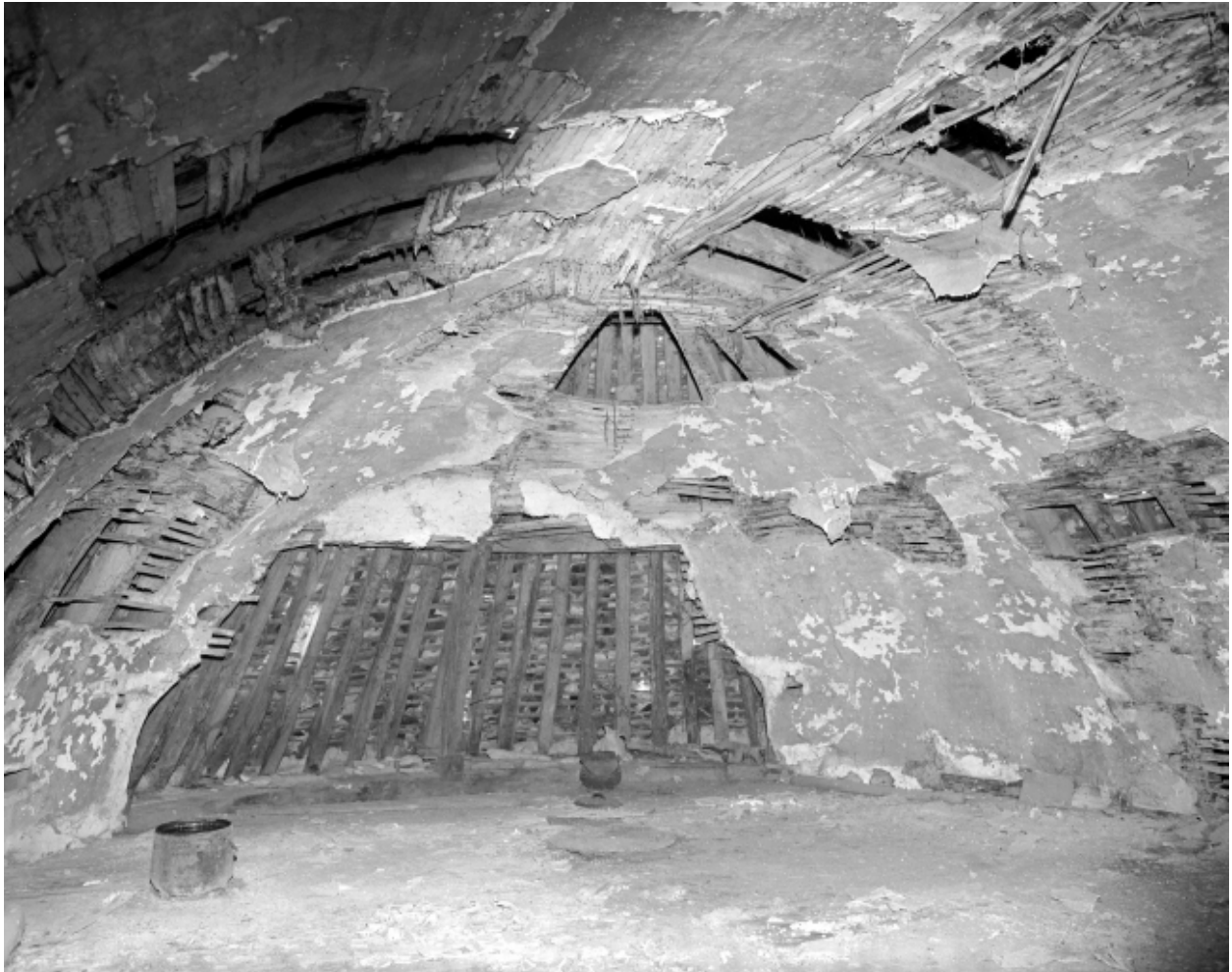
Détail arc de charpente.
