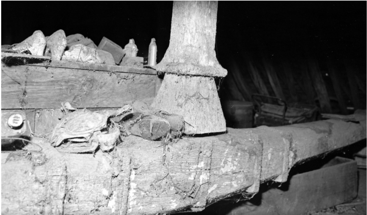
Détail de charpente.
