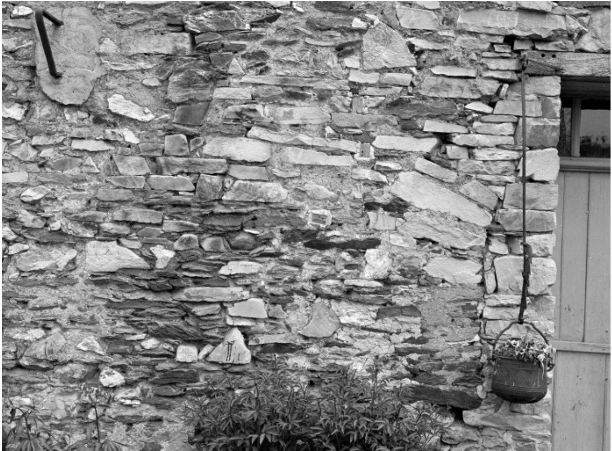
Pignon ouest, détail de l'appareil et trace d'une ancienne porte en plein cintre.
