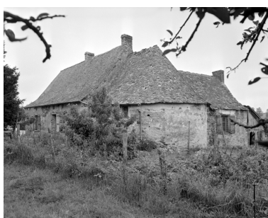
Elévation sud-est, vue générale. Phot. Jean-Pierre Ducouret IVR53_19803500595X
