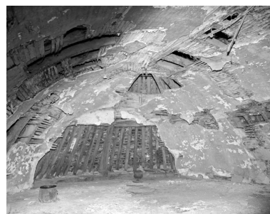
Détail arc de charpente. Phot. Jean-Pierre Ducouret IVR53_19803500591X
