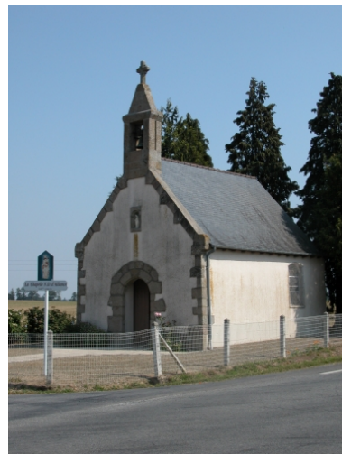
Vue générale sud-ouest Phot. Claude Quillivic IVR53_20043515742NUCA
