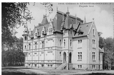
Vue de la façade principale Phot. Elise Lauranceau IVR53_20042905472NUCB
