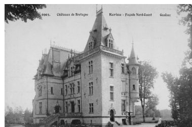
Vue de la façade nord-ouest Phot. Elise Lauranceau IVR53_20042905471NUCB
