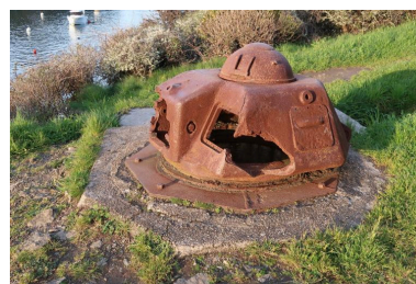
Vue de détail de la tourelle (état en 2024). Elle porte des traces d'impacts Phot. Guillaume Lécueillier IVR53_20242911115NUCA
