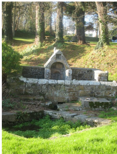
Vue générale de la fontaine Saint-Eloi Phot. Françoise Péron IVR53_20072908912NUCA
