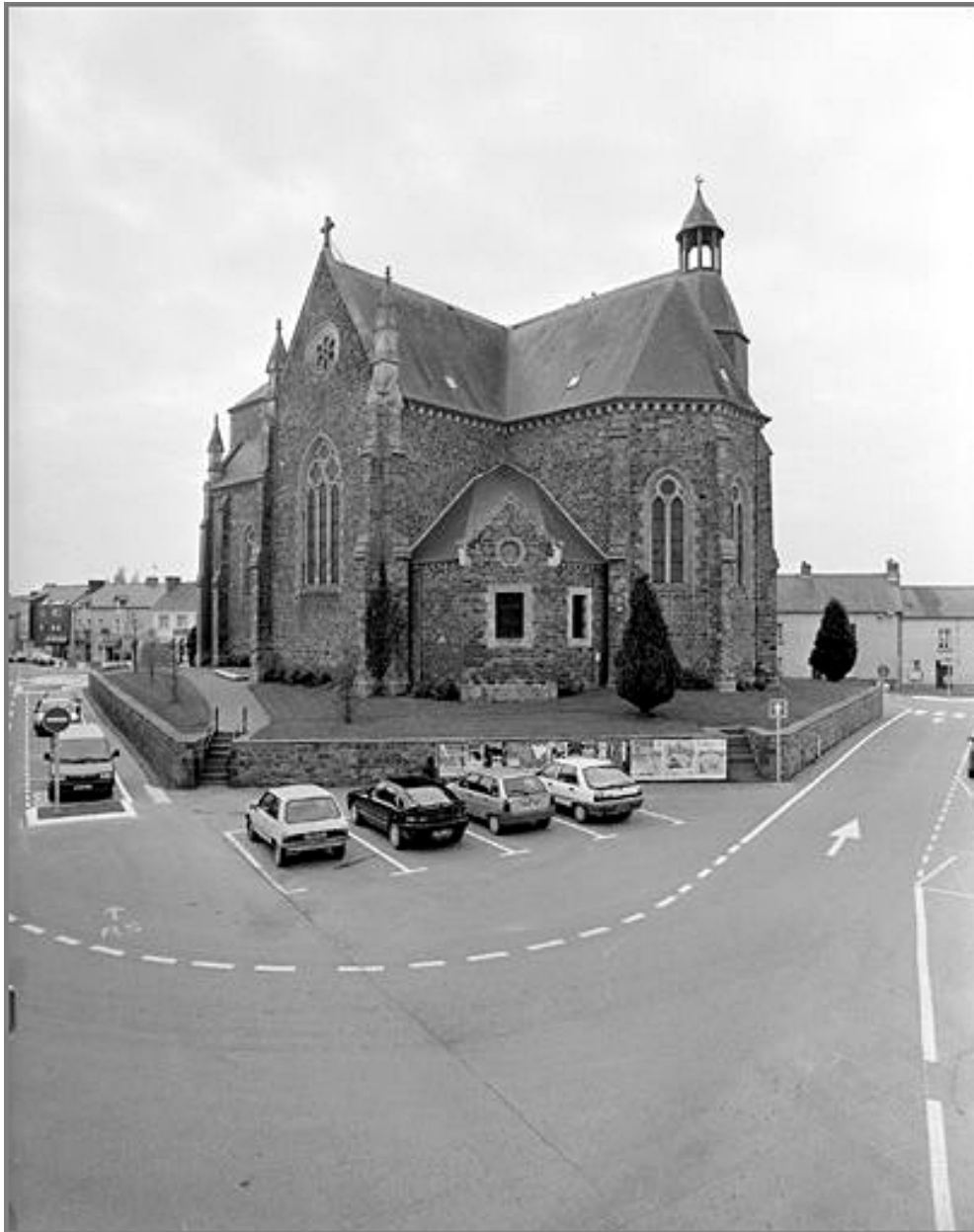
Elévation Nord-Ouest : vue générale
