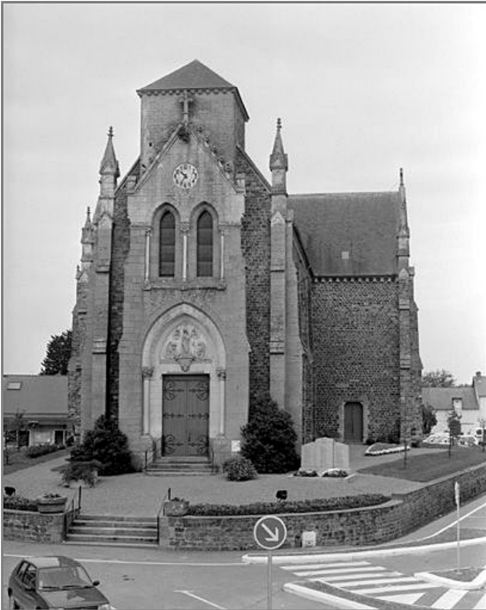
Elévation Est : vue générale
