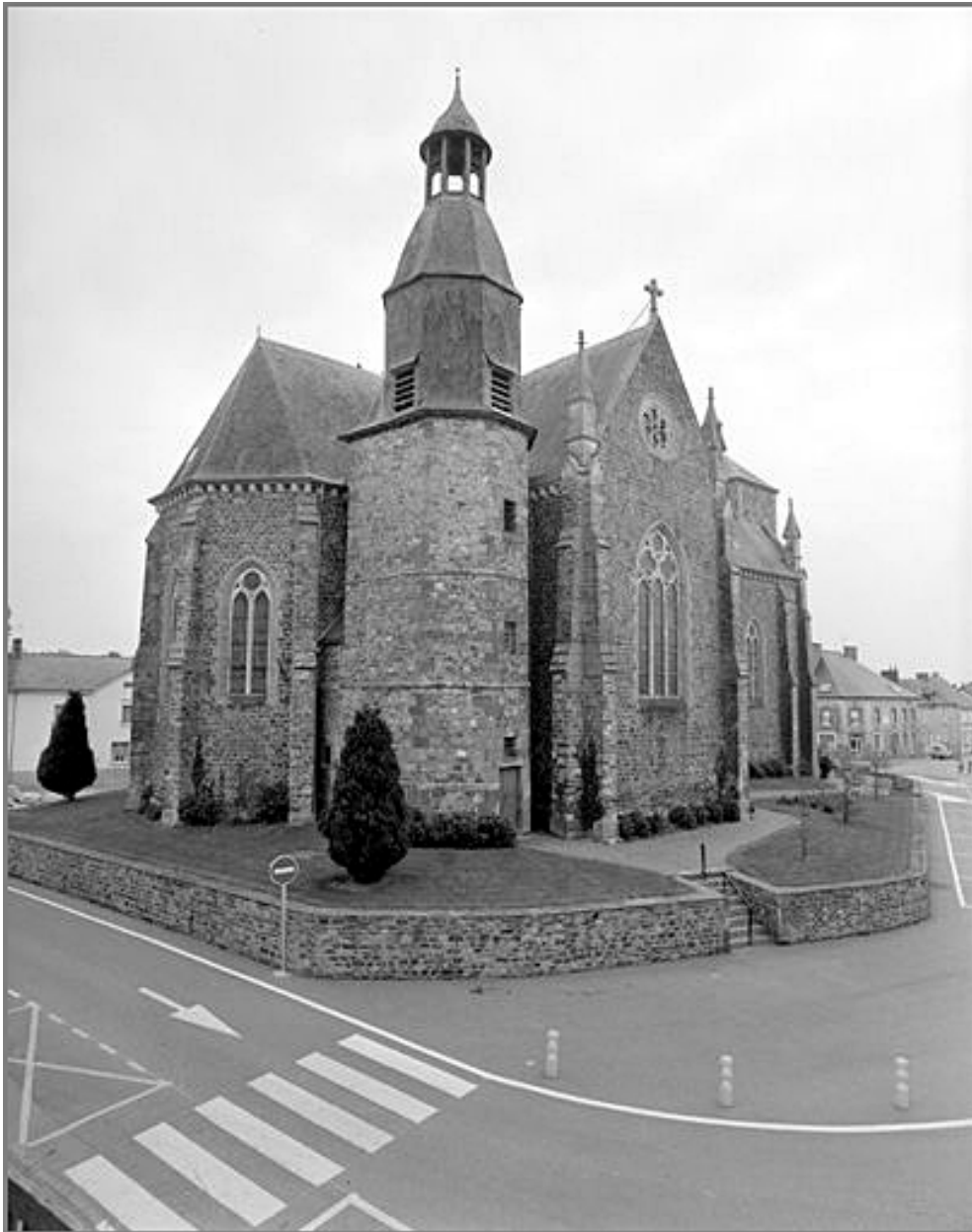
Elévation Sud-Ouest : vue générale
