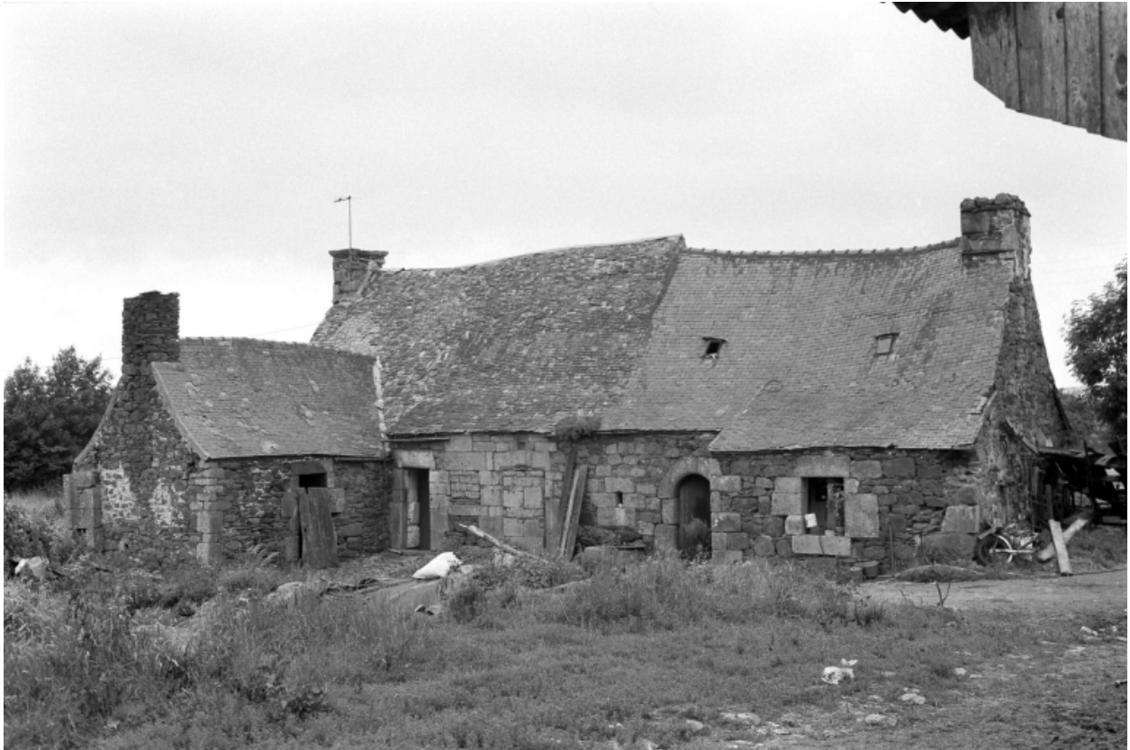
Hellegoat Braz. Vestiges de l'ancien manoir du Hellegoat, 1660, remontés début 19e siècle. Vue générale est. Etat en 1974
