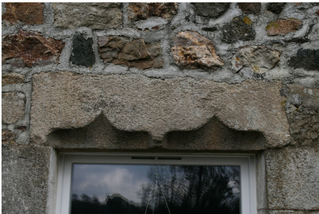
Kersilé. Détail d'un vestige de fenêtre du 16e siècle. Section B2 parcelle 800
