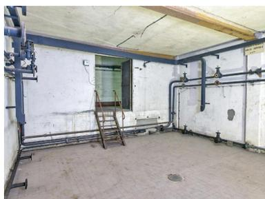
Vue du deuxième étage : "réserve à gas-oil" : 24 m<sup>3</sup> (fonction de 1966). Les traces des cuves circulaires sont visibles sur le carrelage. Sur le panneau à droite, on peut lire "Caisses de réserve / Gas-oil centrale / 4 x 3 m<sup>3</sup>"
