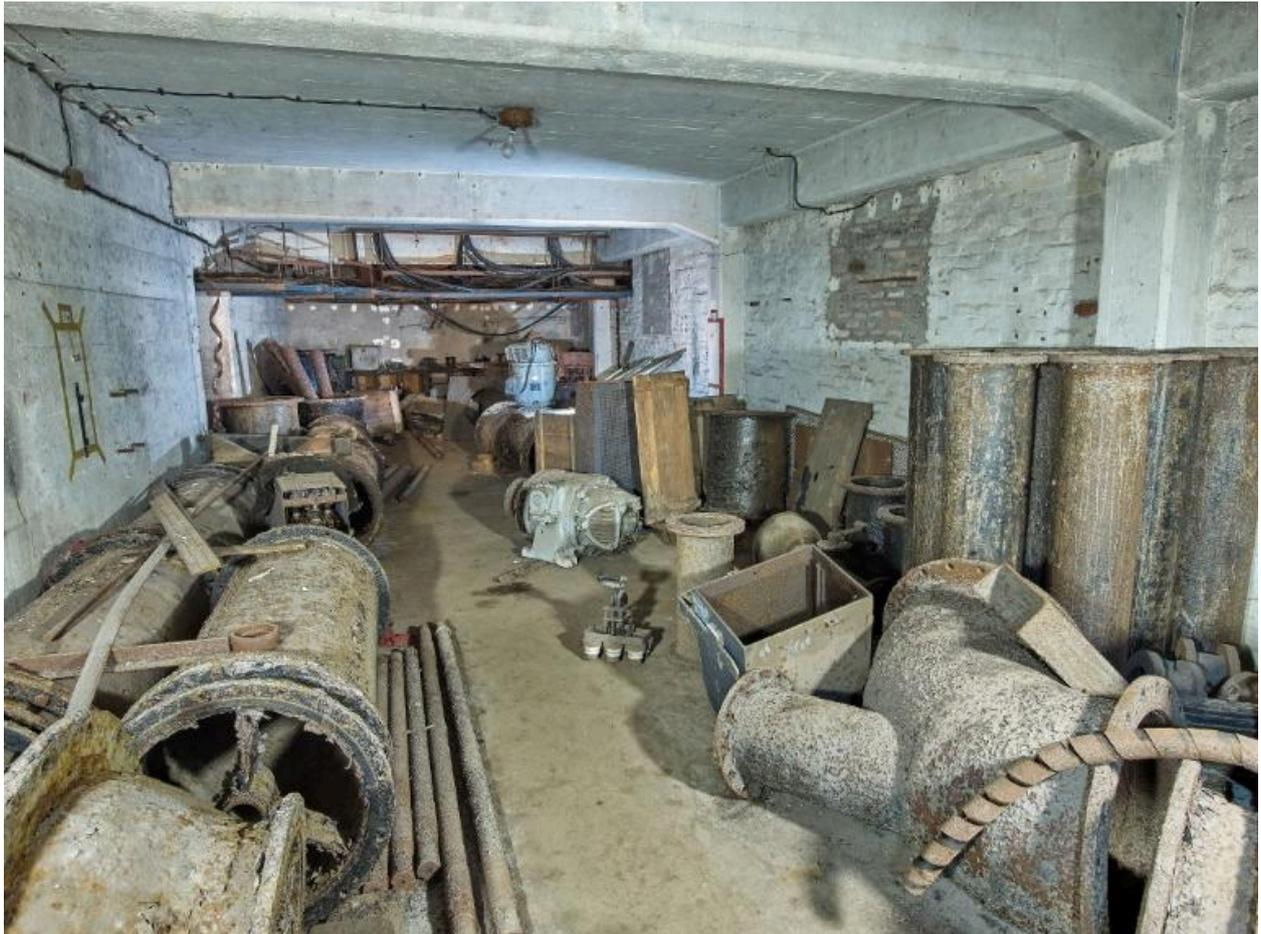
Vue du sous-sol de la centrale électrique : atelier de réparation et magasin de stockage. On reconnaît des pièces détachées de pompe des bassins et des éléments électrique : moteurs, interrupteurs et tableaux...
