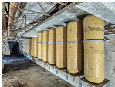
Vue du sous-sol de la salle des groupes électrogènes diesel : ensemble de réservoir d'air comprimé. Ces réservoirs datent de la période française
