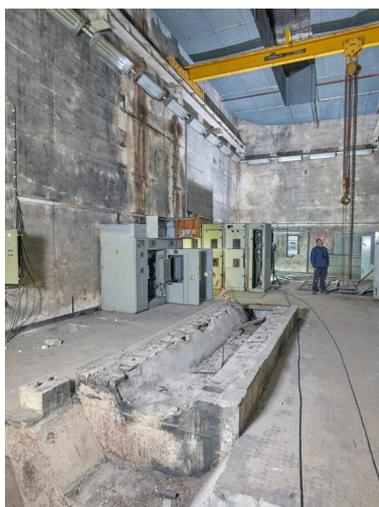
Vue générale de la chaufferie (fonction en 1945) avec son pont roulant. Le pont roulant d'une capacité de 10 tonnes est de marque "FENWICK" (PB2-78). Au premier plan, l'emplacement d'une machine. Sur les murs, plafonnier rectangulaire de type néon
