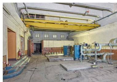
Vue de la salle des groupes électrogènes diesel : extrémité est (production d'air comprimé). Sur son chemin de roulement, le pont roulant d'une capacité de 5 tonnes. Les quatre fenêtres correspondent à deux bureaux situés au premier étage
