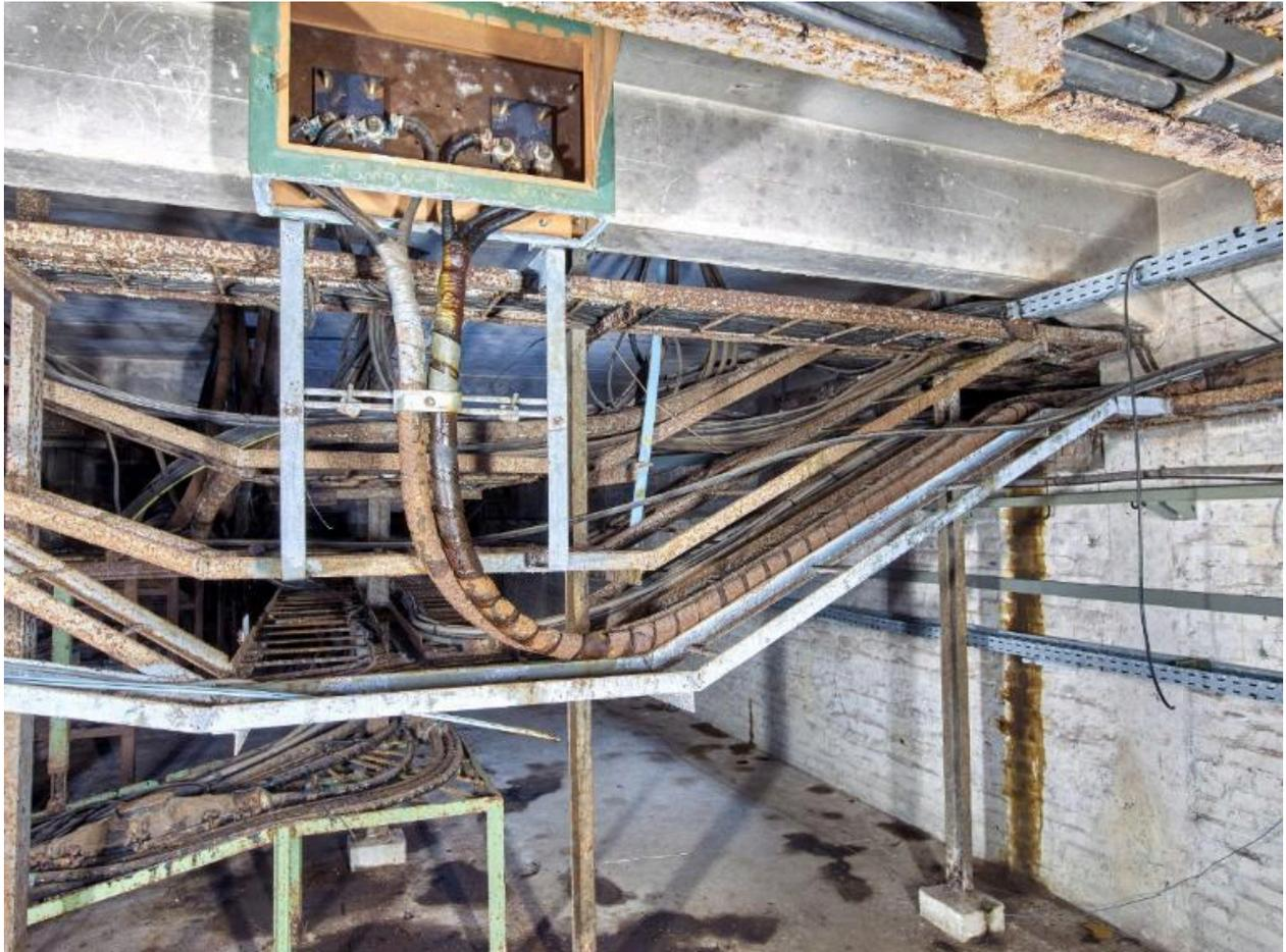
Vue du sous-sol de la centrale électrique : chemin de câble électrique sur plusieurs niveaux et boîtier de connexion. Poteaux, poutres et dalle de plancher sont en béton armé ; les murs de refend sont en brique
