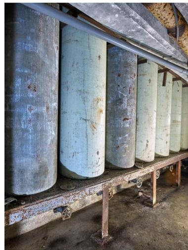
Vue du sous-sol de la salle des groupes électrogènes diesel : extrémité est, ensemble de réservoir d'air comprimé. Ces réservoirs datent de la période allemande
