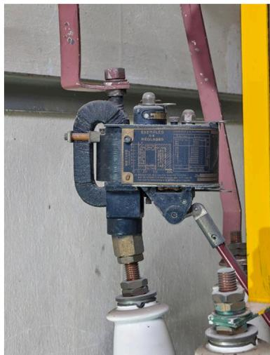
Vue de l'une des cellules hautes-tensions situées au deuxième étage : cellule n° 22, disjoncteur des Forges et ateliers des productions électriques de Jeumont
