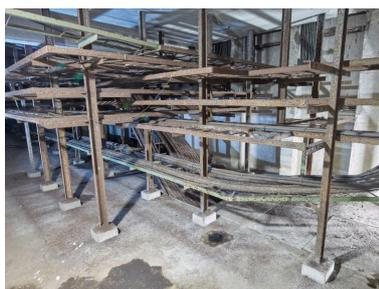
Vue du sous-sol de la centrale électrique : chemin de câble électrique sur plusieurs niveaux. Poteaux, poutres et dalle de plancher sont en béton armé
