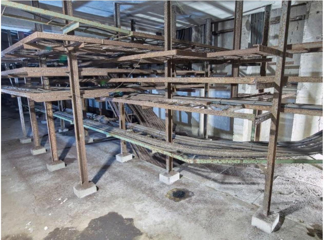
Vue du sous-sol de la centrale électrique : chemin de câble électrique sur plusieurs niveaux. Poteaux, poutres et dalle de plancher sont en béton armé
