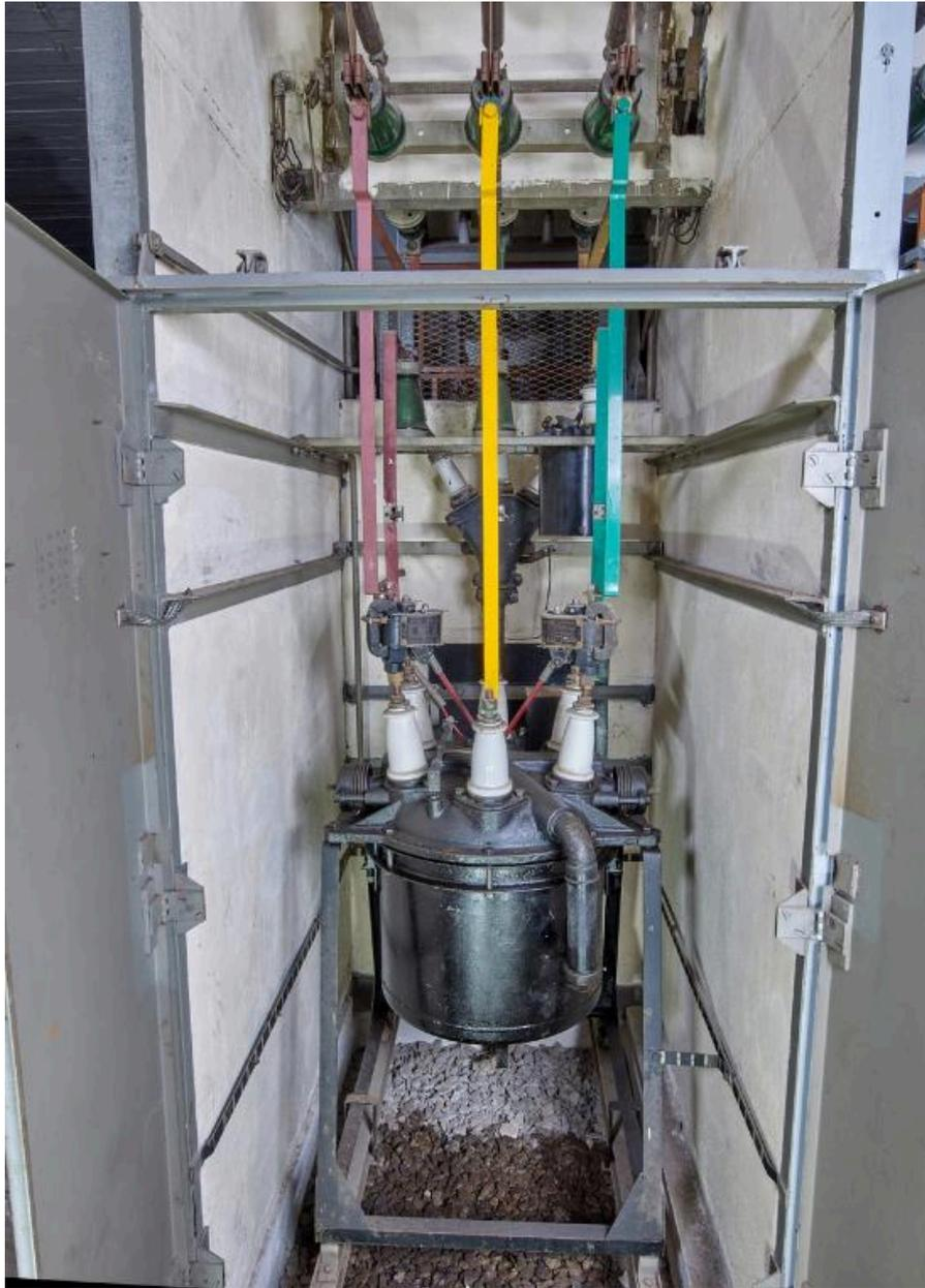
Vue de l'une des cellules hautes-tensions situées au deuxième étage : cellule n° 22, disjoncteur des Forges et ateliers des productions électriques de Jeumont. La cuve est remplie d'huile pour dissiper la chaleur : elle s'ouvre avec deux câbles
