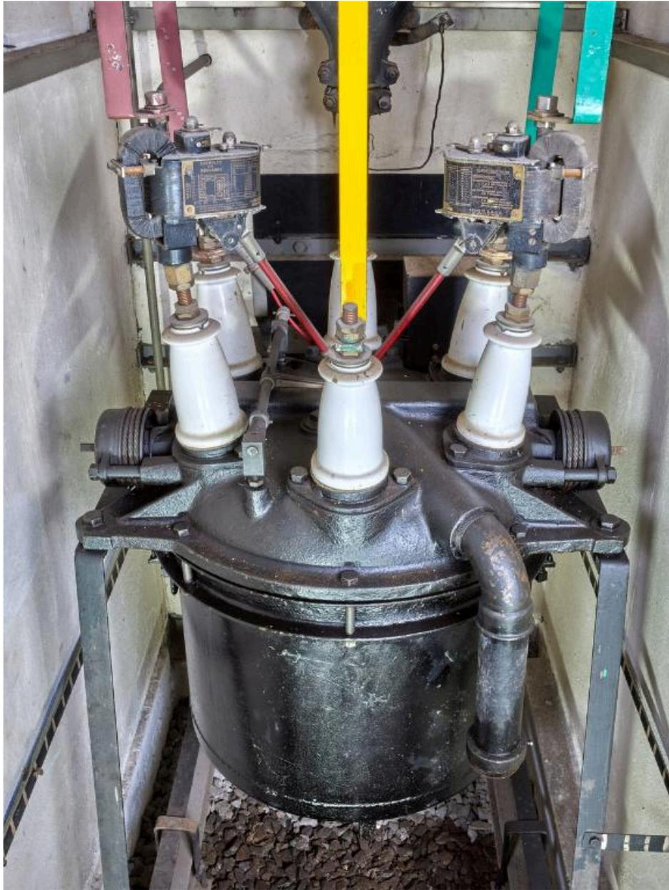
Vue de l'une des cellules hautes-tensions situées au deuxième étage : cellule n° 22, disjoncteur des Forges et ateliers des productions électriques de Jeumont. La cuve est remplie d'huile pour dissiper la chaleur : elle s'ouvre avec deux câbles
