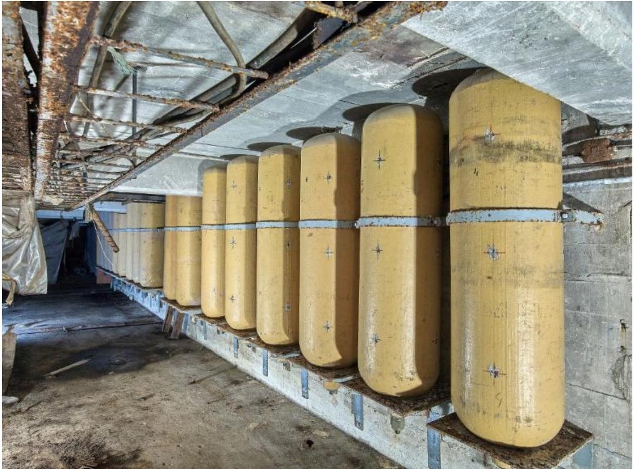
Vue du sous-sol de la salle des groupes électrogènes diesel : ensemble de réservoir d'air comprimé. Ces réservoirs datent de la période française
