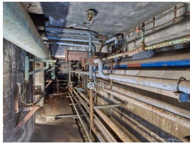
Vue du sous-sol de la salle des groupes électrogènes diesel : réseaux de tuyauterie liés au refroidissement des moteurs (eau douce, eau de mer)
