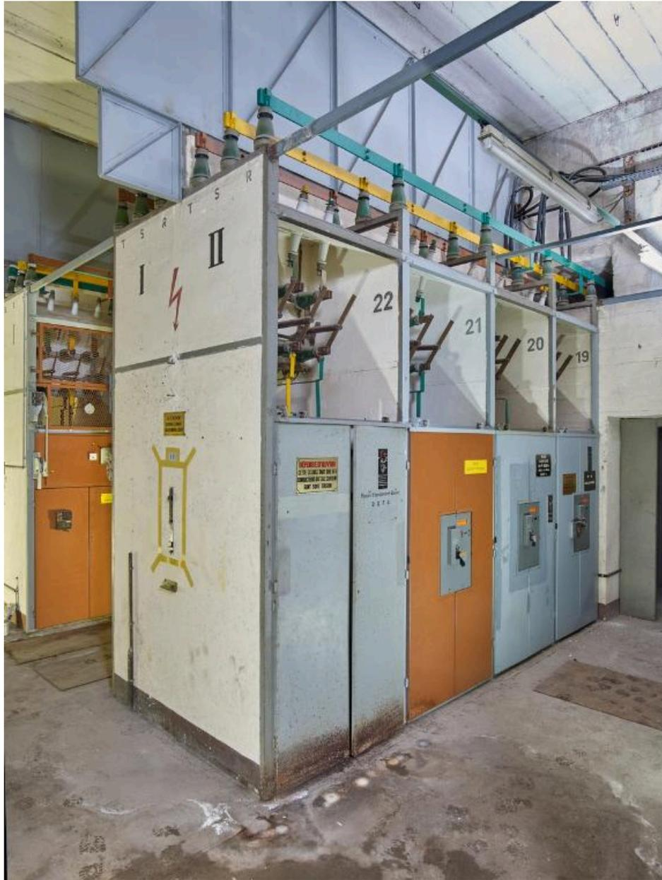
Vue des cellules hautes-tensions situées au deuxième étage : cellules n° 19 à 22. Les cellules sont des armoires métalliques modulaires qu'on assemble et relie entre elles.
