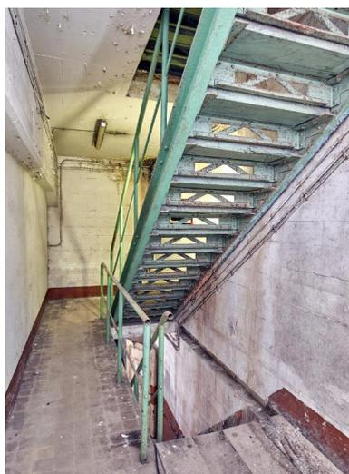
Vue de l'une des volets de l'escalier préfabriqué métallique nord : les marches sont en bois comme les paliers (les paliers sont démontables, afin de permettre des manutentions)
