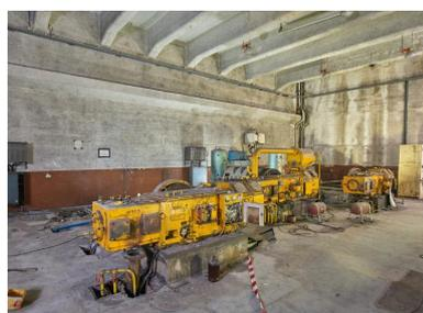
Vue de la salle des groupes électrogènes diesel : ensemble de trois groupes électrogènes alimentant des moteurs asynchrones des Ateliers Bernard Bonnefond Saint-Étienne
