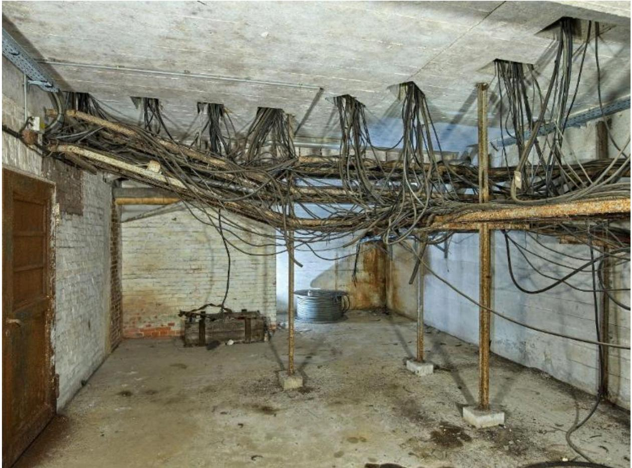
Vue du sous-sol de la centrale électrique : chemin de câble électrique alimentant la salle de commande située au rez-de-chaussée. Les murs de refend sont en brique
