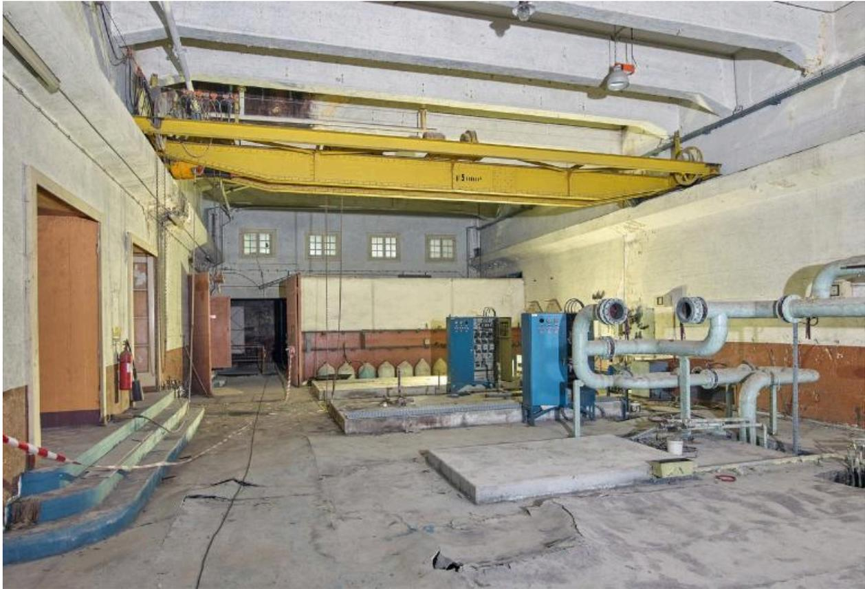
Vue de la salle des groupes électrogènes diesel : extrémité est (production d'air comprimé). Sur son chemin de roulement, le pont roulant d'une capacité de 5 tonnes. Les quatre fenêtres correspondent à deux bureaux situés au premier étage
