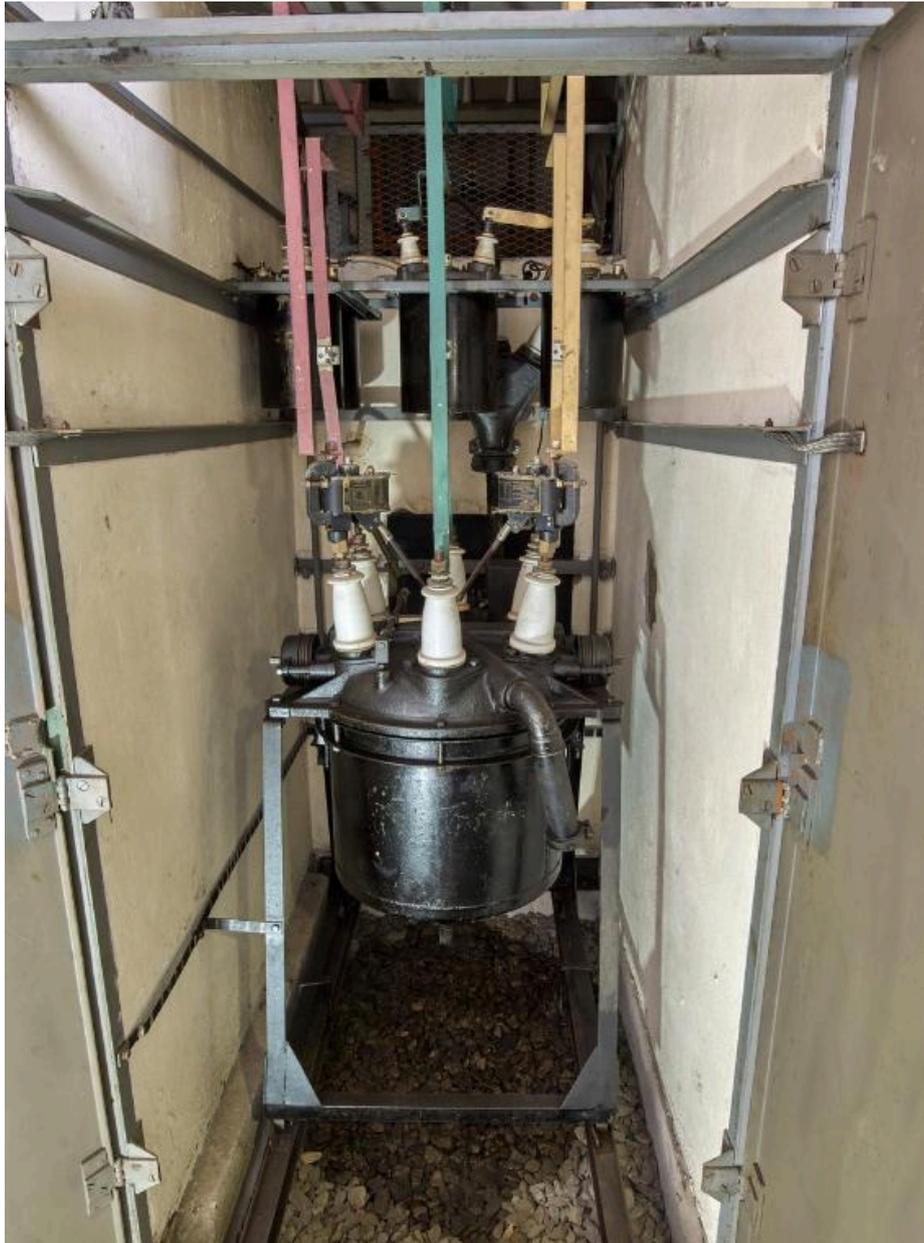
Vue de l'une des cellules hautes-tensions situées au deuxième étage : disjoncteur des Forges et ateliers des productions électriques de Jeumont. La cuve du transformateur est remplie d'huile non conductrice pour dissiper la chaleur
