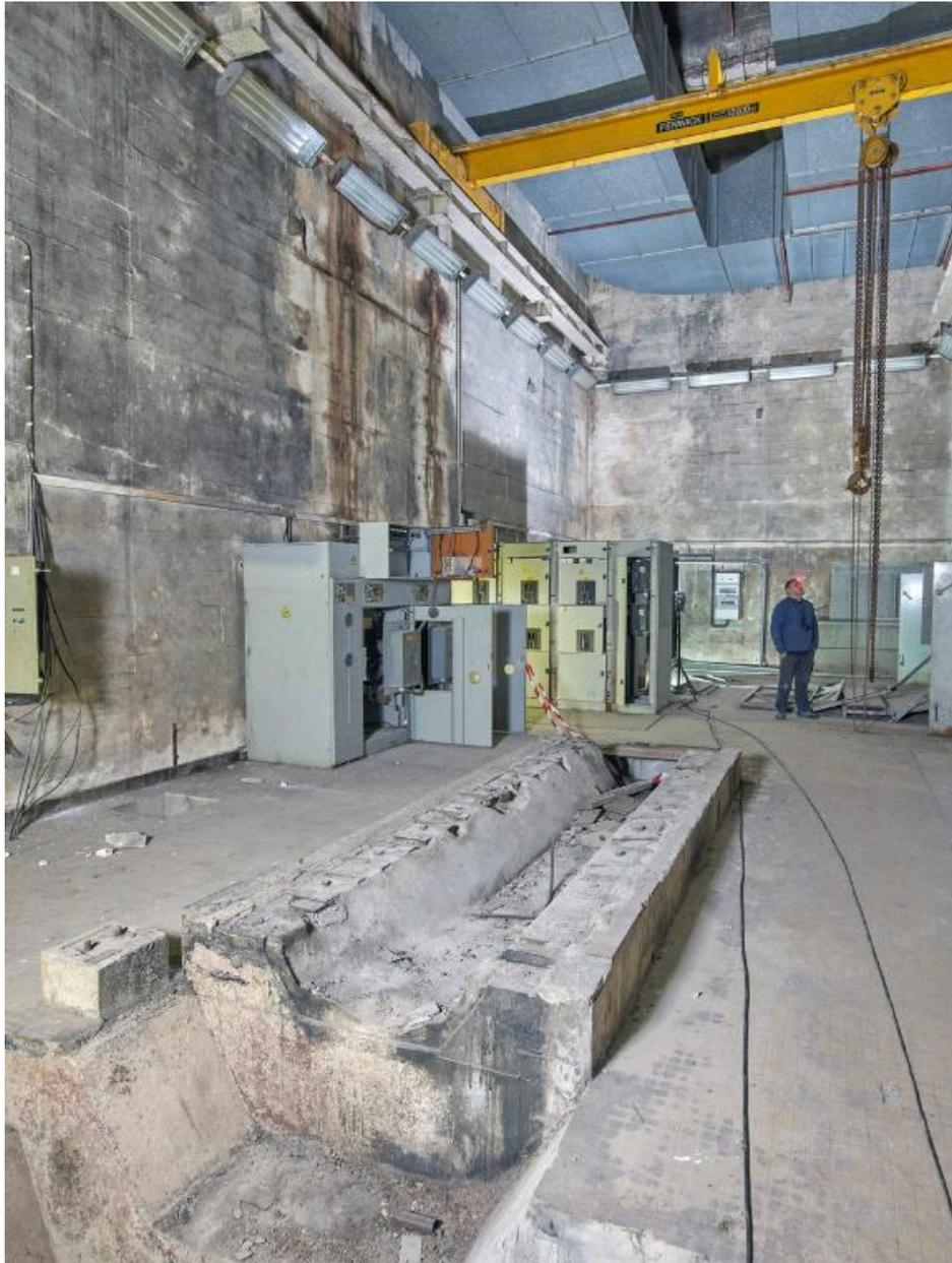
Vue générale de la chaufferie (fonction en 1945) avec son pont roulant. Le pont roulant d'une capacité de 10 tonnes est de marque "FENWICK" (PB2-78). Au premier plan, l'emplacement d'une machine. Sur les murs, plafonniers rectangulaire de type néon
