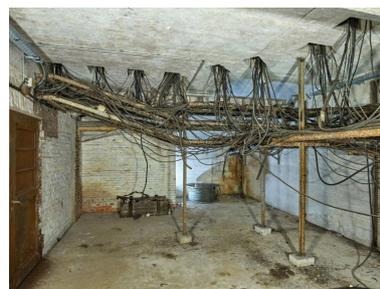
Vue du sous-sol de la centrale électrique : chemin de câble électrique alimentant la salle de commande située au rez-de-chaussée. Les murs de refend sont en brique
