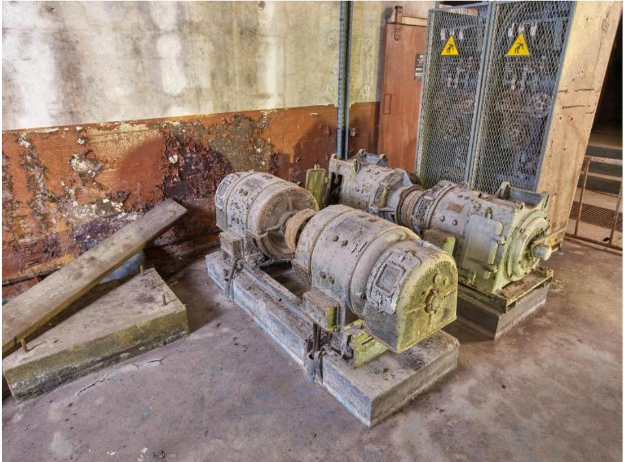
Vue de la salle des groupes électrogènes diesel : ensemble de deux machines à courant continu de la Compagnie générale électrique Nancy
