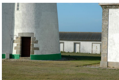
Vue du phare du Stiff, ouvrage tronconique : tourelle à demi hors oeuvre regroupant entrée et escalier à vis Phot. Guillaume Lécueillier IVR53_20062903300NUCA
