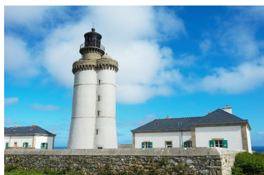
Vue générale du phare du Stiff (état en 2014) Phot. Marine Michel IVR53_20142900392NUCA
