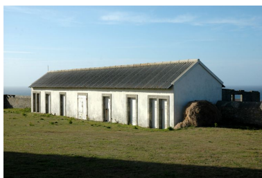
Vue du phare du Stiff, partie constituante Phot. Guillaume Lécueillier IVR53_20062903309NUCA
