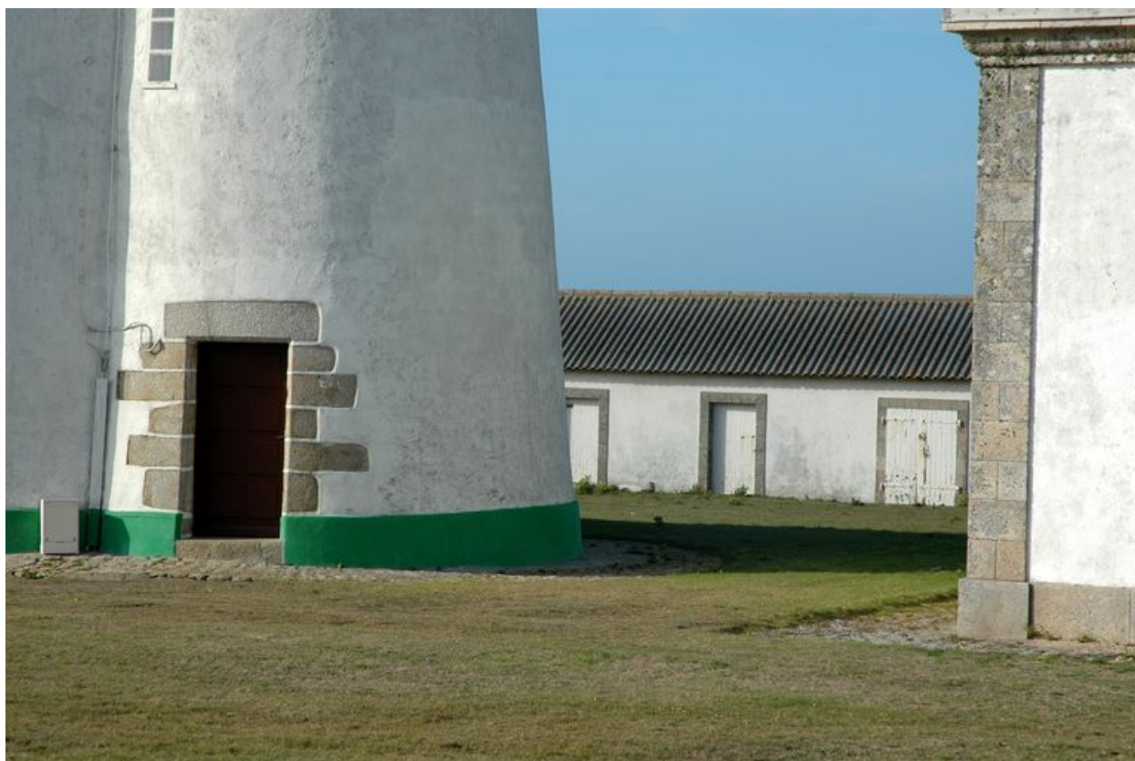
Vue du phare du Stiff, ouvrage tronconique : tourelle à demi hors oeuvre regroupant entrée et escalier à vis
