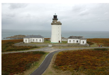
Vue générale du phare du Stiff Phot. Guillaume Lécueillier IVR53_20062903296NUCA
