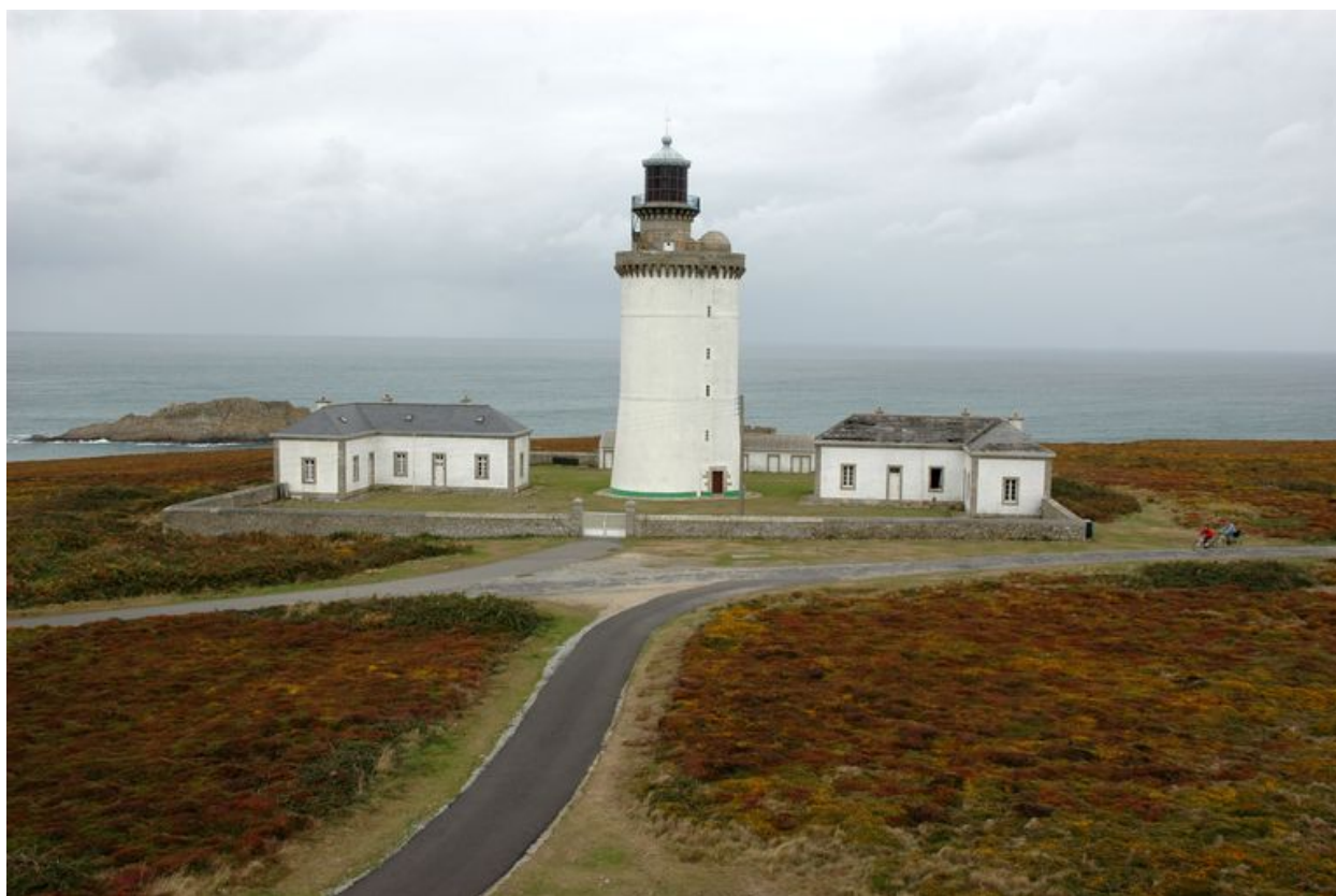
Vue générale du phare du Stiff
