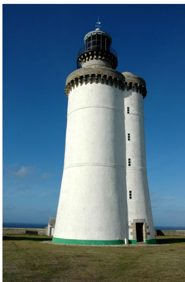
Vue du phare du Stiff, une tour tronconique à 4 niveaux et terrasse surmontée d'une calotte sphérique ou guérite Phot. Guillaume Lécueillier IVR53_20062903298NUCA
