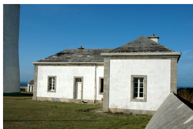
Vue du phare du Stiff, partie constituante Phot. Guillaume Lécueillier IVR53_20062903304NUCA
