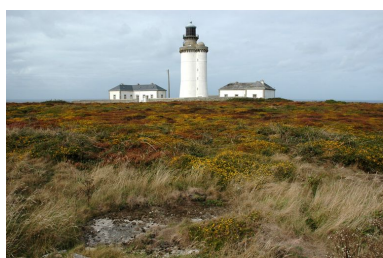
Vue générale du phare du Stiff Phot. Guillaume Lécueillier IVR53_20062903295NUCA
