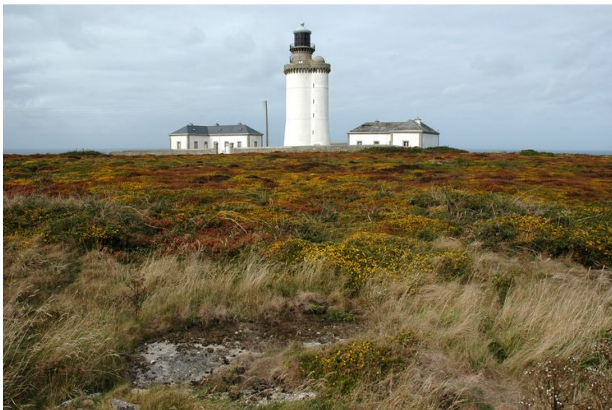
Vue générale du phare du Stiff
