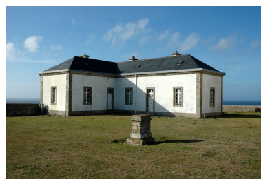
Vue du phare du Stiff, partie constituante Phot. Guillaume Lécueillier IVR53_20062903307NUCA
