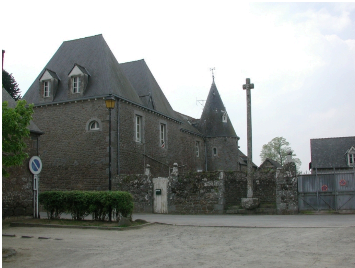
Vue partielle nord-est
