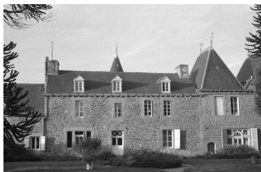
Vue sud du logis en 1972 Phot. Auteur inconnu IVR53_19723500792Z
