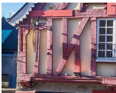
Les mortaises orphelines et trous de chevilles indiquent un appui filant disparu.
