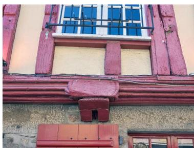
La sablière de chambrée s'orne d'une série de moulures qui s'arrêtent au niveau de son assemblage avec les abouts de solive.
