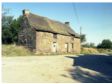
Vue générale sud-est. Phot. François Dagorn IVR53_19775601091XE
