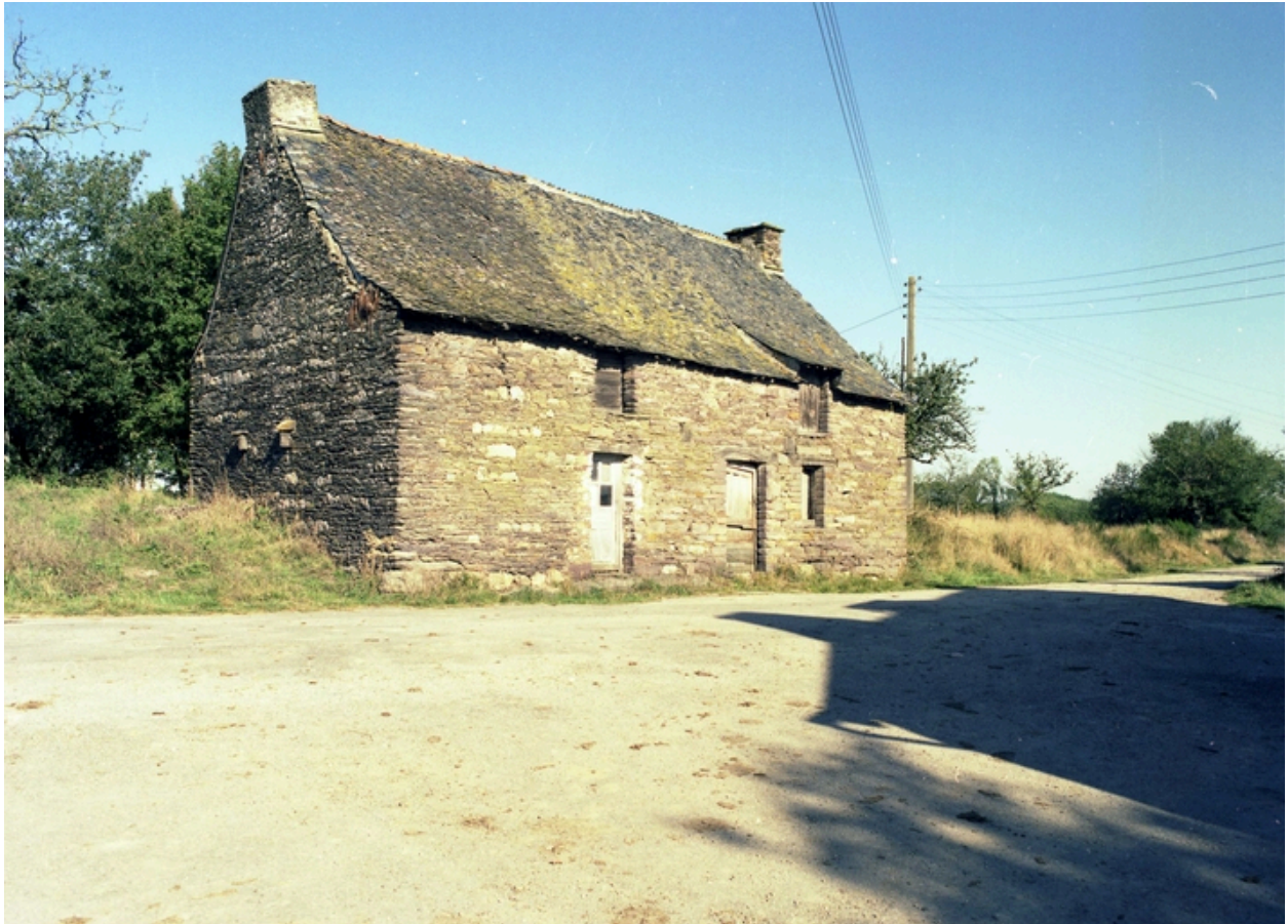
Vue générale sud-est.
