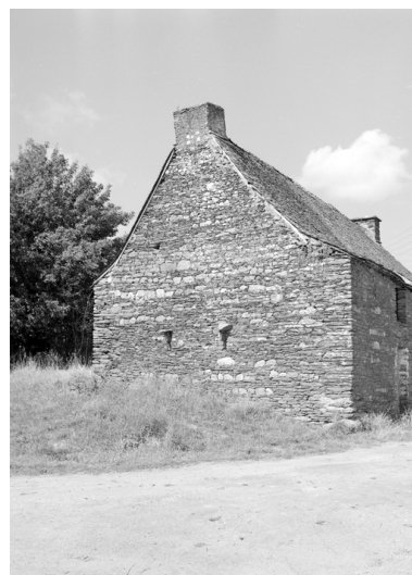
Vue générale sud sud-est Phot. François Dagorn IVR53_19775600924X
