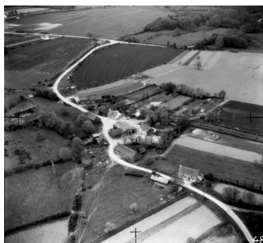
Vue aérienne prise du sud-ouest Phot. G.A.L.R.E.G. IVR53_19795600063P
