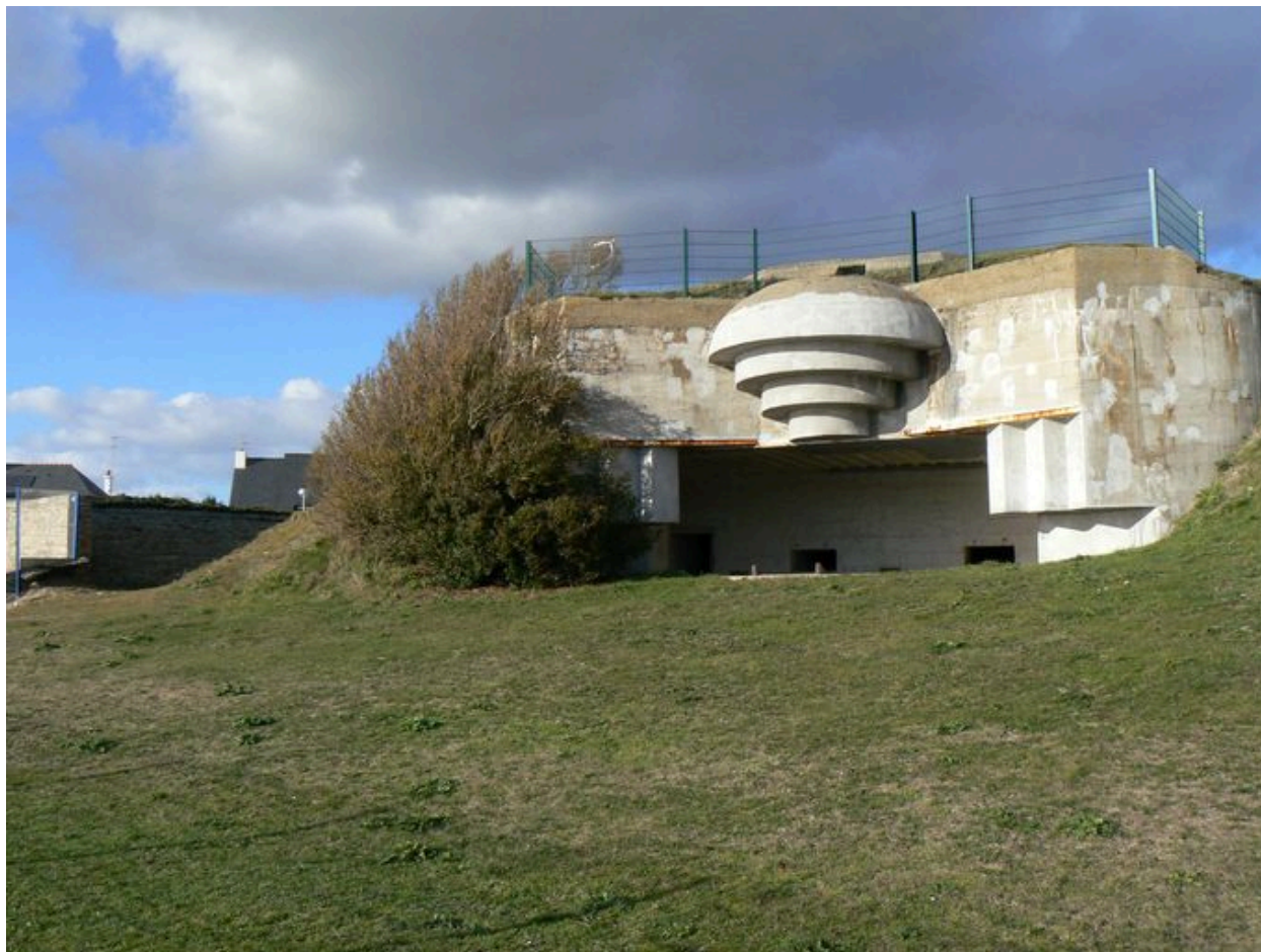
Casemate à proximité du fort de Locquetas
