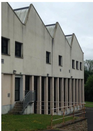
Vue générale prise du nord-ouest Phot. Simon Vely IVR53_20162206734NUCA
