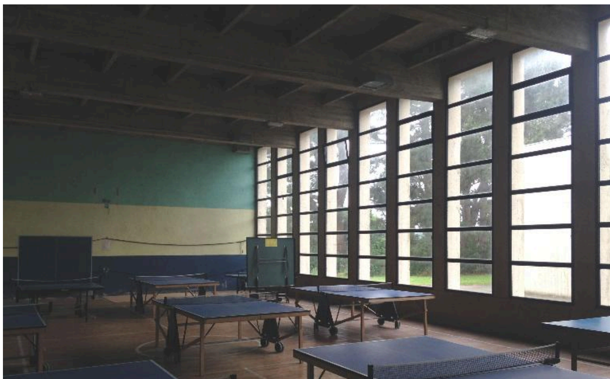
Vue intérieure prise du nord-est
