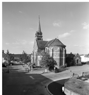
Vue prise du chevet Phot. Guy Artur, Phot. Norbert Lambart IVR53_19943501878X
