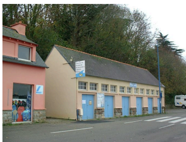
Vue générale Phot. Julien Amghar IVR53_20072908806NUCA
