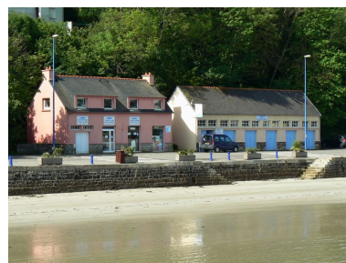
Vue de l'Abri du Marin et de l'Amicale des pêcheurs Phot. Julien Amghar IVR53_20072908817NUCA
