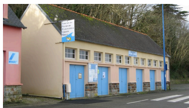
Vue générale Phot. Guillaume Marie IVR53_20072908807NUCA
