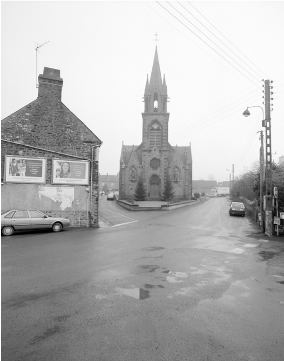
Elévation Ouest : vue générale.
