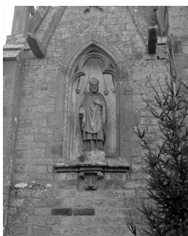
Elévation Ouest, statue Nord : vue générale. Phot. Alain Boden IVR53_19943500007X
