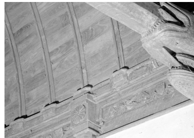
Château, chapelle : sablière décorée de masques et d'écussons ; à droite, deux engoulants d'où sort l'entrait (état en 1984) Phot. Norbert Lambart IVR53_19845601748X
