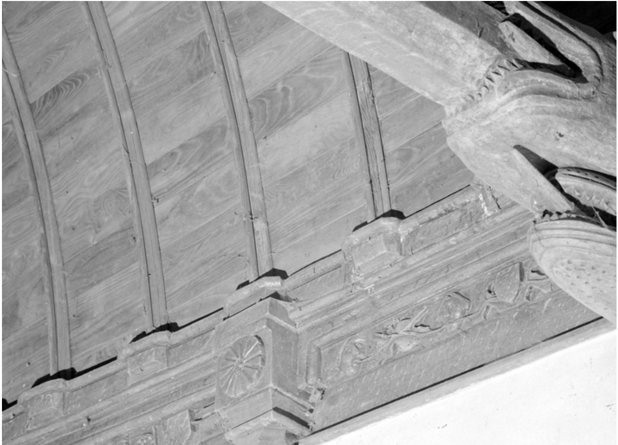
Château, chapelle : sablière décorée de masques et d'écussons ; à droite, deux engoulants d'où sort l'entrait (état en 1984)
