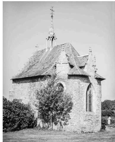
Château : la chapelle Saint-Marc vue de l'est (état en 1984) Phot. Norbert Lambart IVR53_19845601736X
