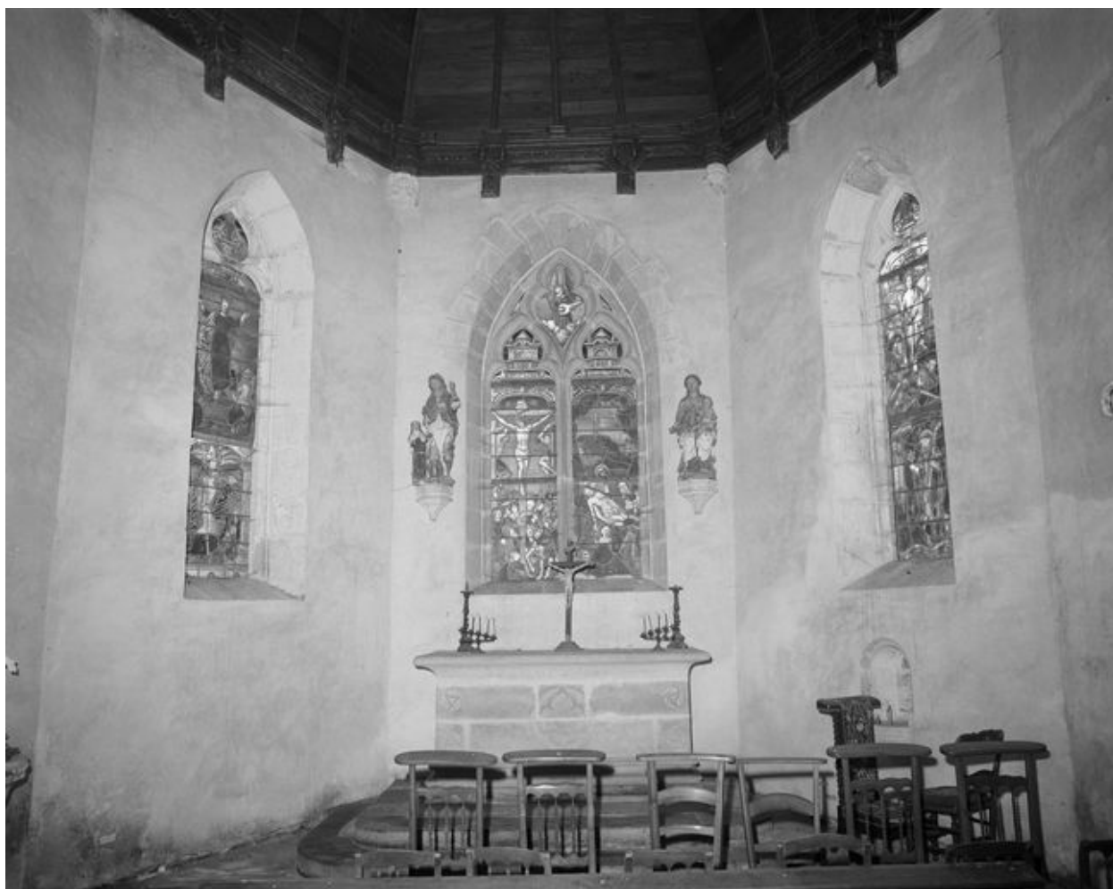
Château, chapelle : vue vers l'autel (état en 1984)
