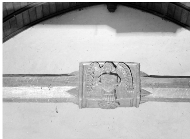
Château, chapelle : entrait sculpté décoré d'un ange portant un blason (état en 1984) Phot. Norbert Lambart IVR53_19845601750X
