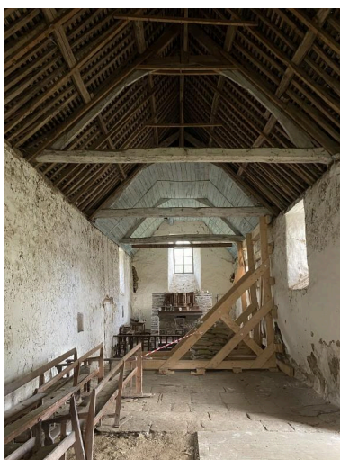
Vue générale de l'intérieur Phot. Baptiste Oligo IVR53_20265610503NUCA
