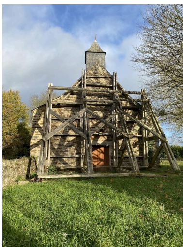
Vue ouest Phot. Baptiste Oligo IVR53_20265610498NUCA
