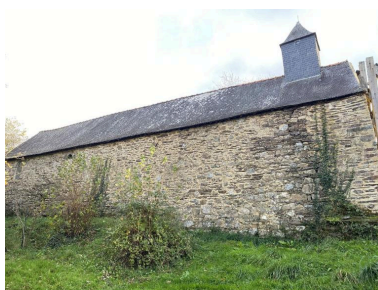
Vue générale nord Phot. Baptiste Oligo IVR53_20265610509NUCA
