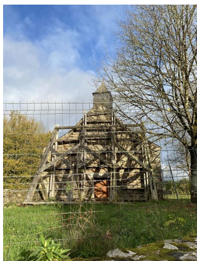
Vue ouest Phot. Baptiste Oligo IVR53_20265610497NUCA
