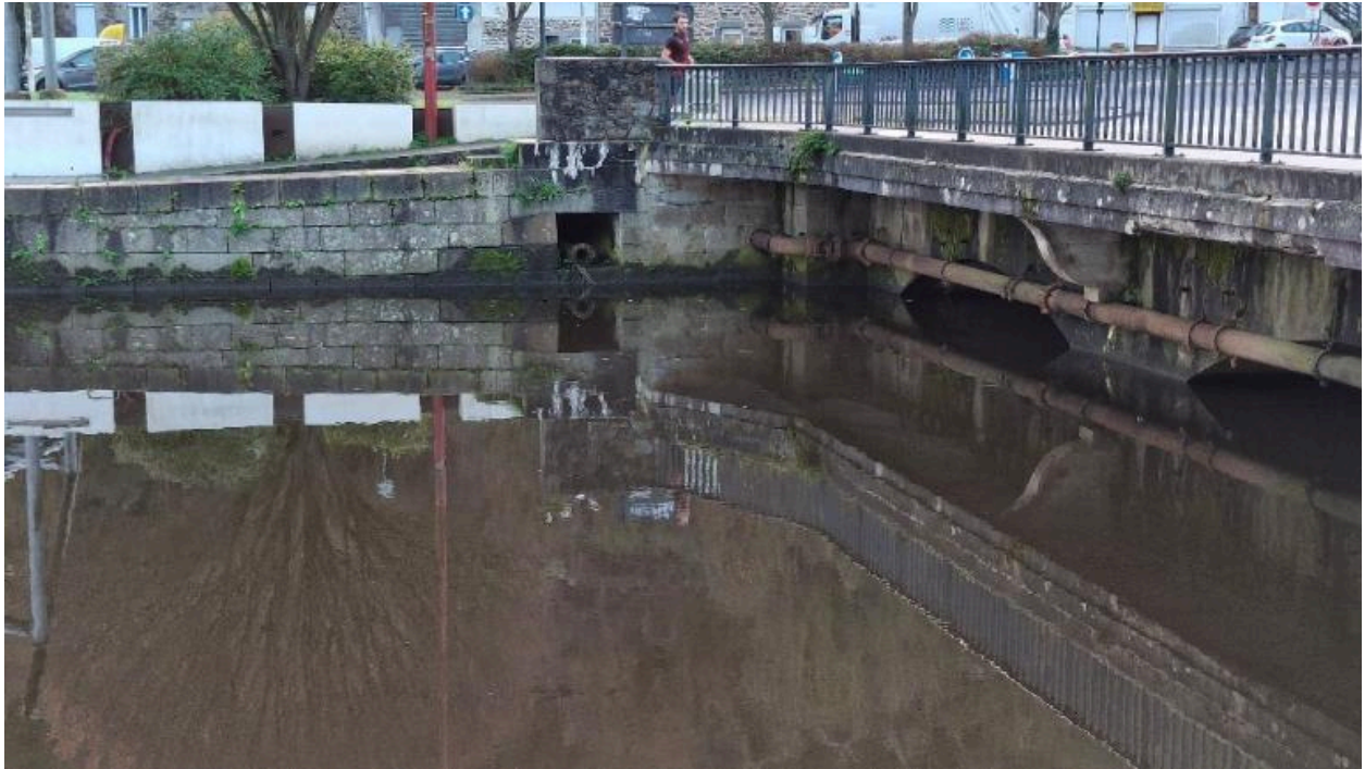
Le pont-de-pierre : tablier et culée rive droite
