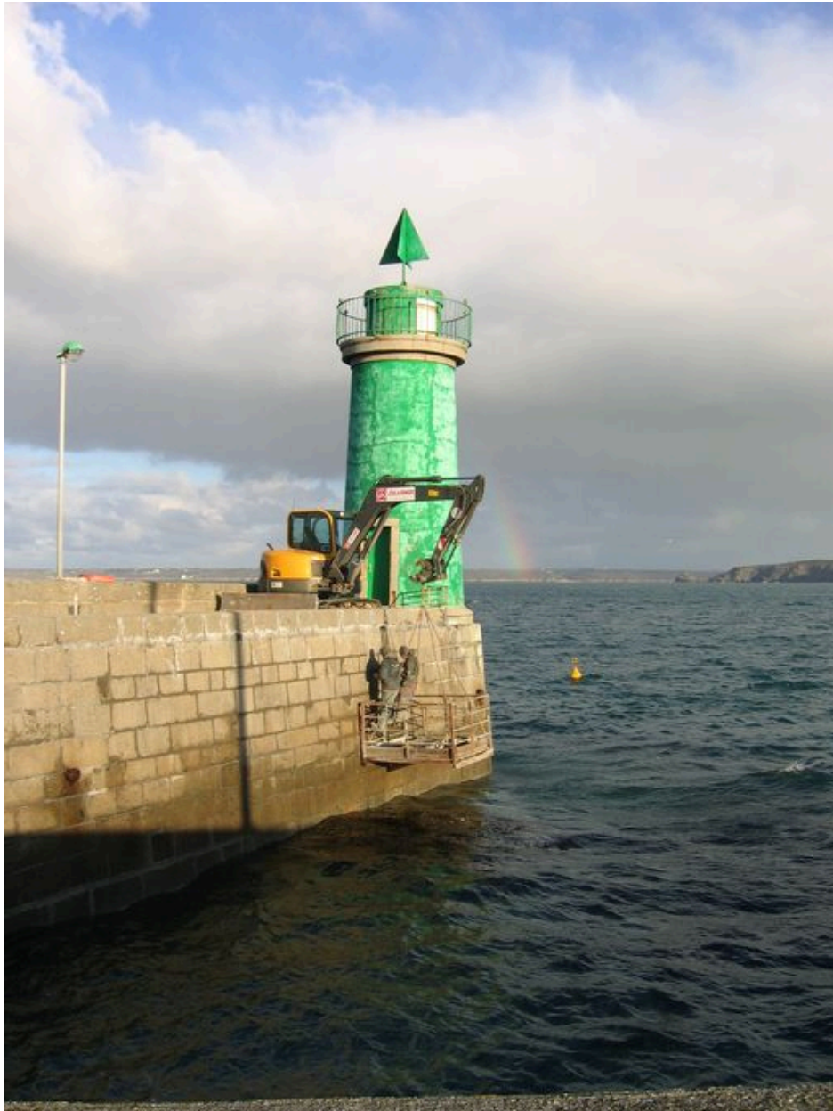
Feu de signalisation du Môle Vert
