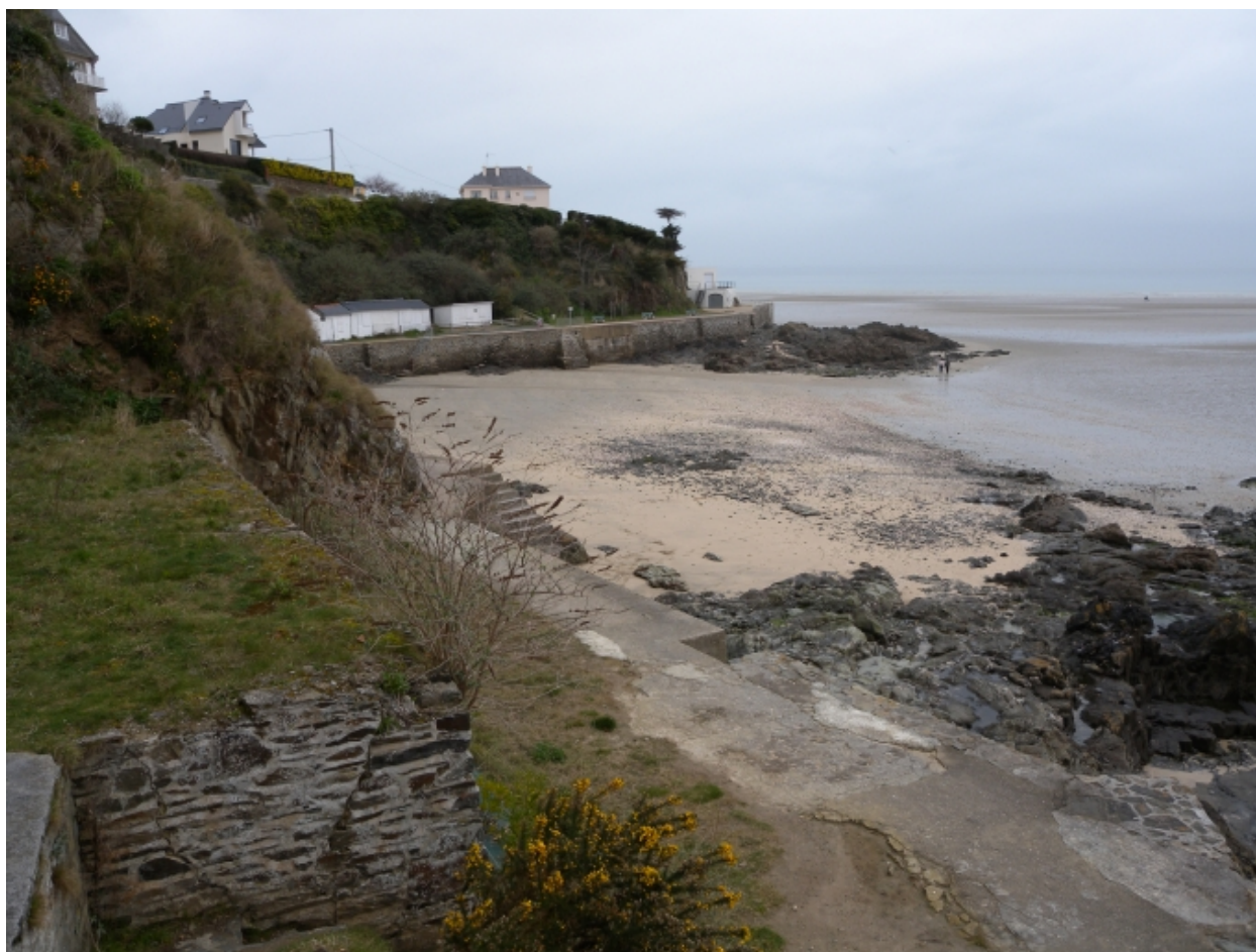
Vue de la digue-promenade Est
