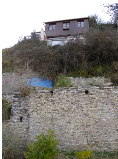
Bâti littoral sur le chemin de la corniche, avec son mur de soutènement Phot. Guy Prigent IVR53_20082213264NUCA
