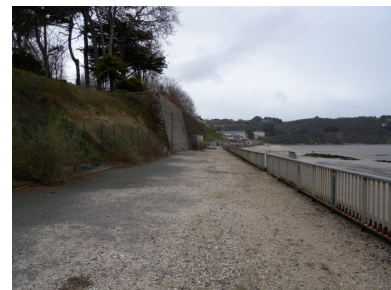
Vue de la digue-promenade en béton, équipée d'un garde-corps Phot. Guy Prigent IVR53_20082213255NUCA
