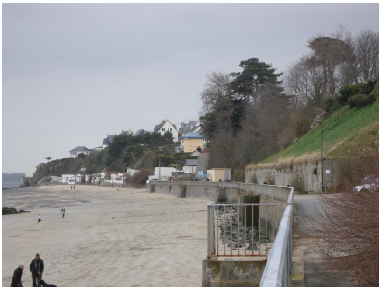
Vue du front de mer : la digue-promenade avec les escaliers de descente et les habitations sur les coteaux
