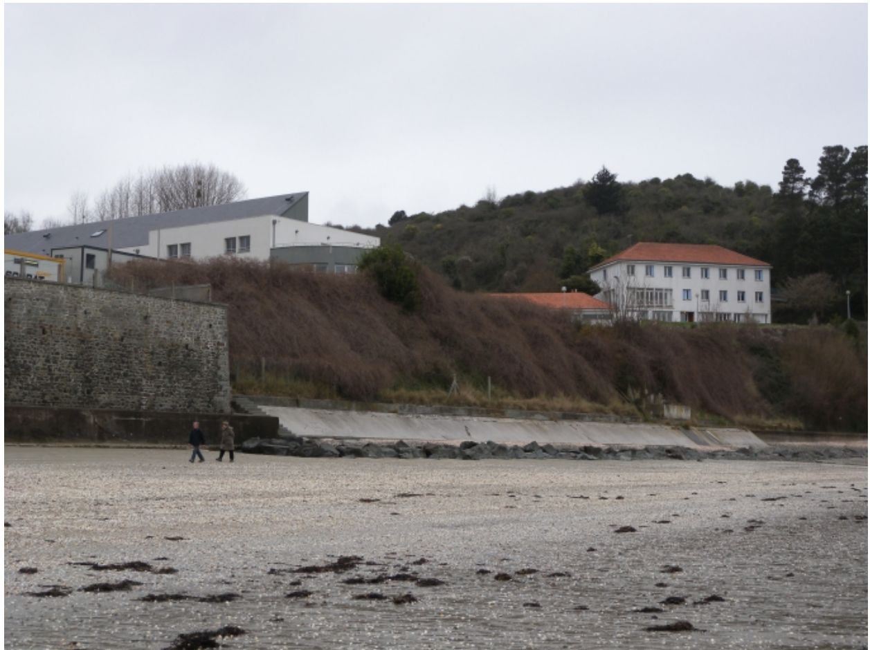
Vue du site de Port-Aurel : mur de soutènement et de défense, forme de digue pour protéger le Préventorium, site archéologique (bâtiment thermal gallo-romain)
