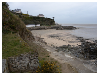
Vue de la digue-promenade Est Phot. Guy Prigent IVR53_20082213265NUCA
