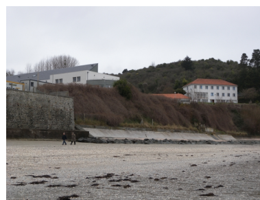
Vue du site de Port-Aurel : mur de soutènement et de défense, forme de digue pour protéger le Préventorium, site archéologique (bâtiment thermal gallo-romain) Phot. Guy Prigent IVR53_20082213262NUCA
