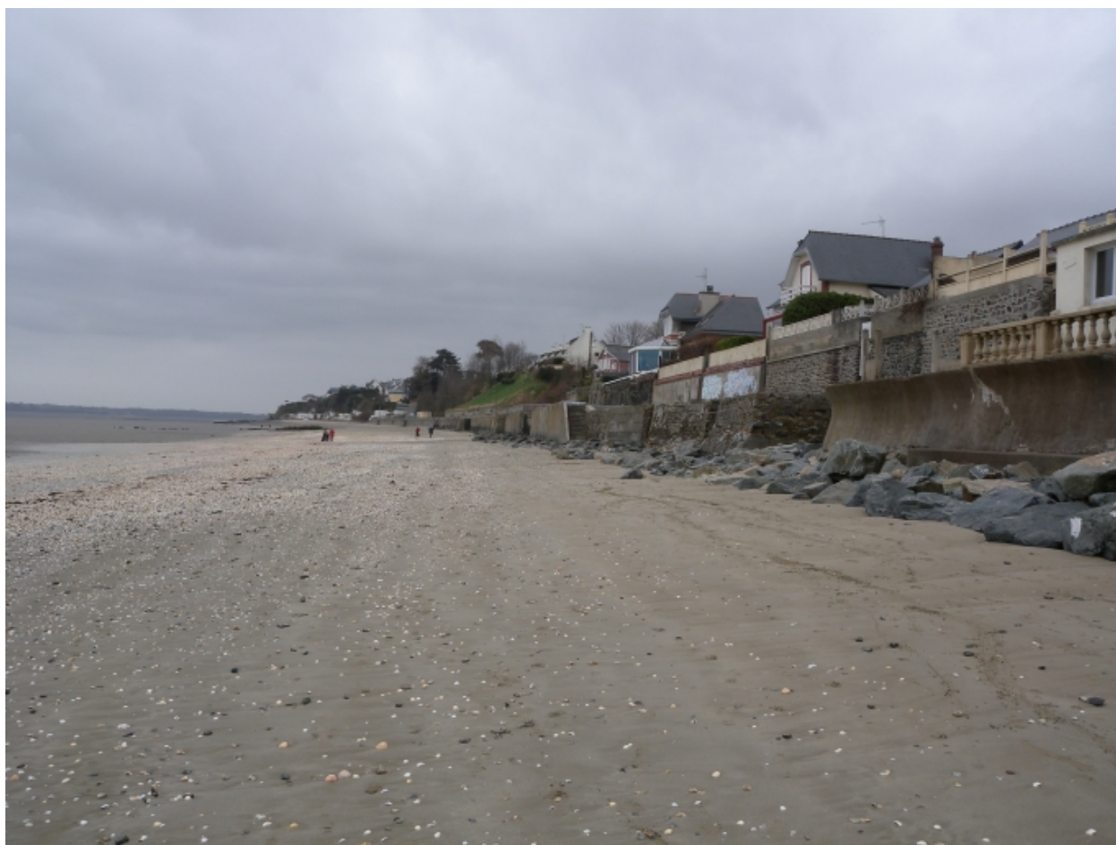
Vue du front de mer des trois plages : remarquer les enrochements, la digue-promenade sur-élevée et les cabines de bain
