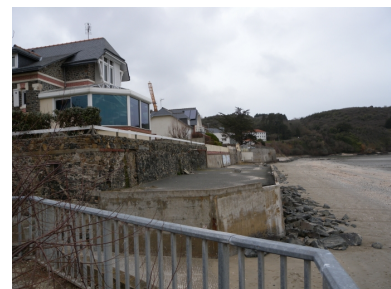
Vue du bâti littoral contemporain en front de mer, près de la rampe d'accès à la grève Phot. Guy Prigent IVR53_20082213256NUCA
