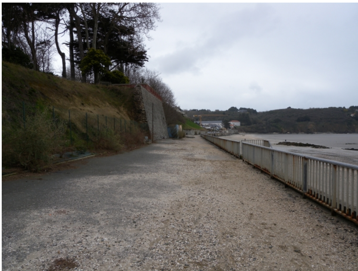
Vue de la digue-promenade en béton, équipée d'un garde-corps
