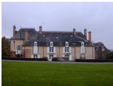
Corps principal, ancien logis, façade postérieure : vue générale nord-est Phot. Xavier Gilbert IVR53_20003515550NUCA
