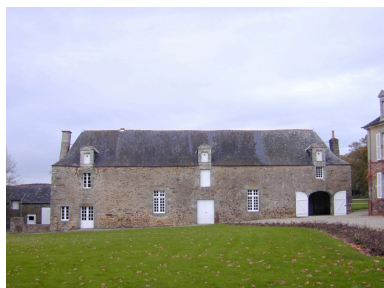
Communs, façade antérieure sur cour : vue générale sud Phot. Xavier Gilbert IVR53_20003515555NUCA
