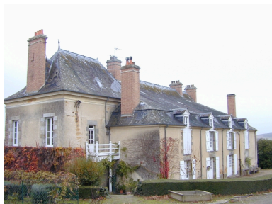
Corps principal, pavillon et ancien logis : vue générale sud-est Phot. Xavier Gilbert IVR53_20003515549NUCA
