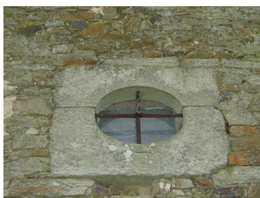
Communs, façade postérieure, oculus : détail
