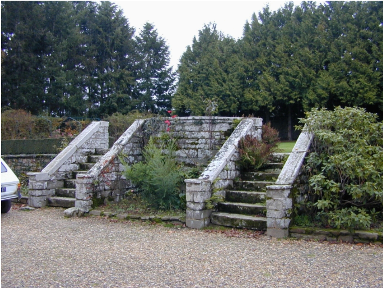
Jardin ou verger derrière le logis, escalier du XVIIIe siècle : vue générale sud-ouest
