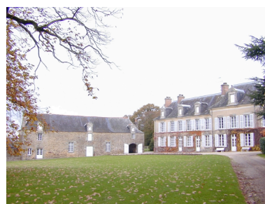
Le château vu depuis l'accès principal : vue de situation sud-ouest Phot. Xavier Gilbert IVR53_20003515548NUCA
