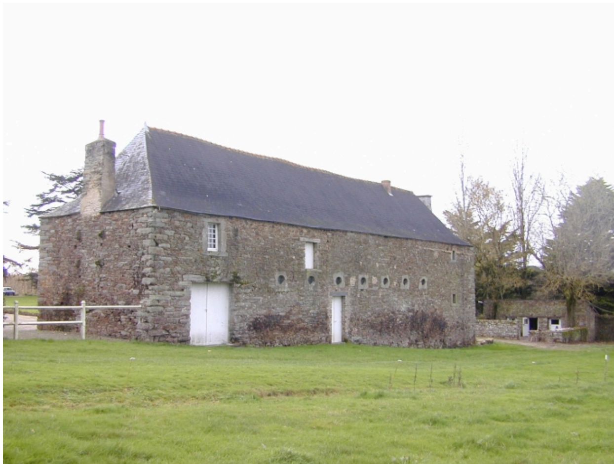
Communs, façade postérieure : vue générale nord-est
