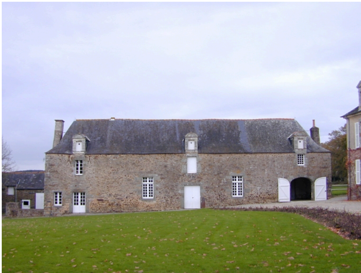
Communs, façade antérieure sur cour : vue générale sud
