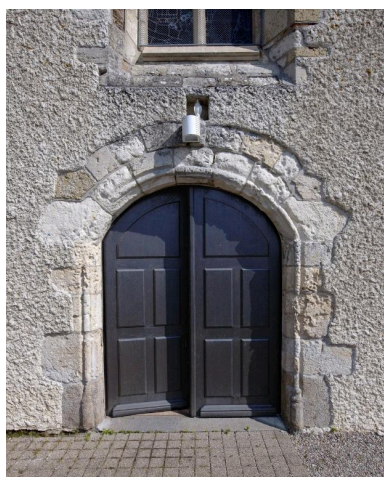
Eglise Saint-Melaine, entrée ouest Phot. Bernard Bègne IVR53_20173500299NUCA
