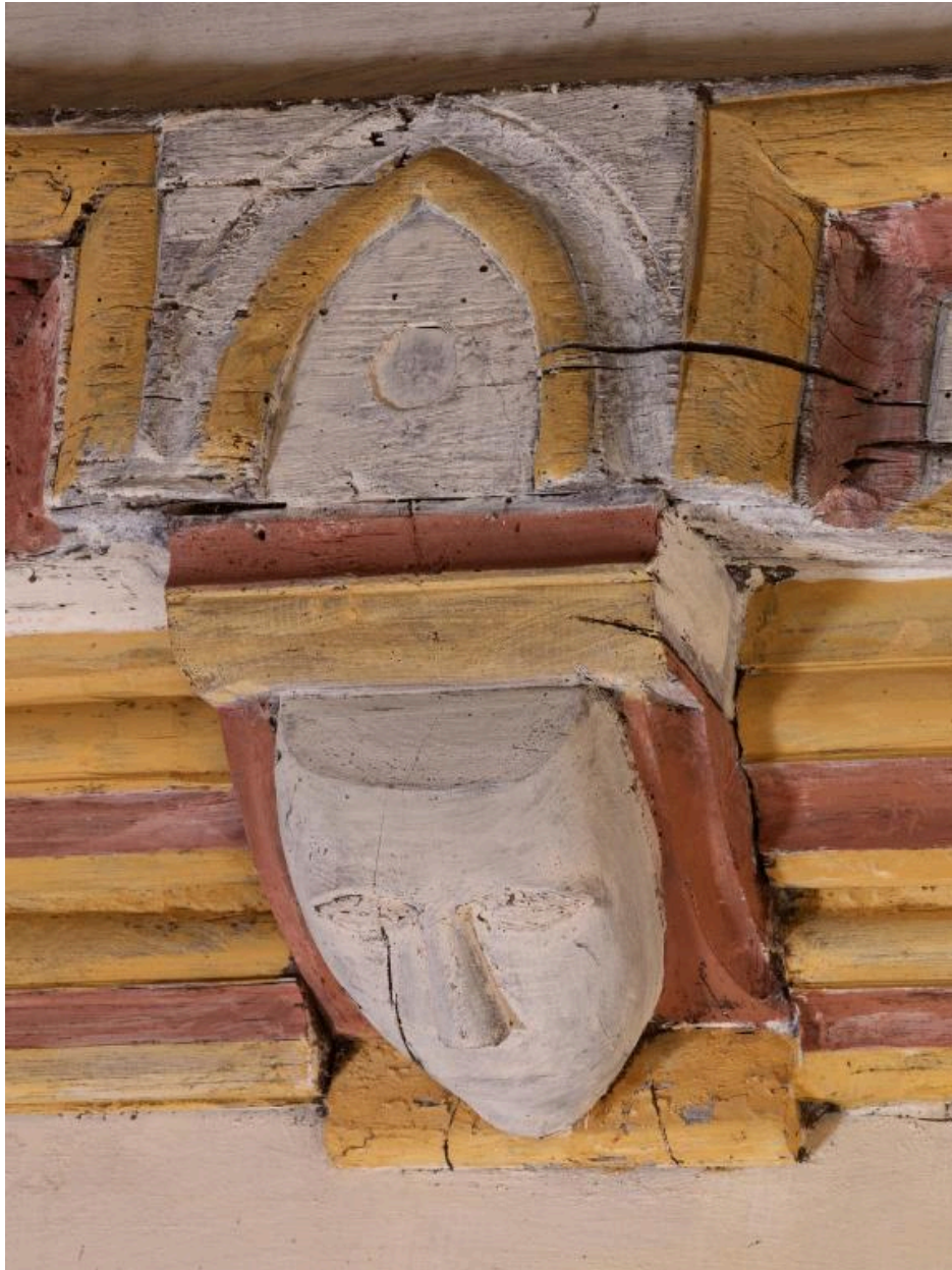
Eglise Saint-Melaine, détail de la charpente de la sacristie Saint-Giles
