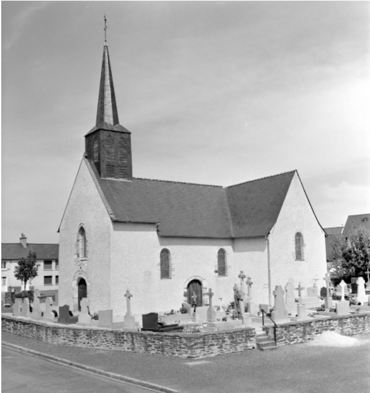
Elévation Sud-Ouest : vue générale
