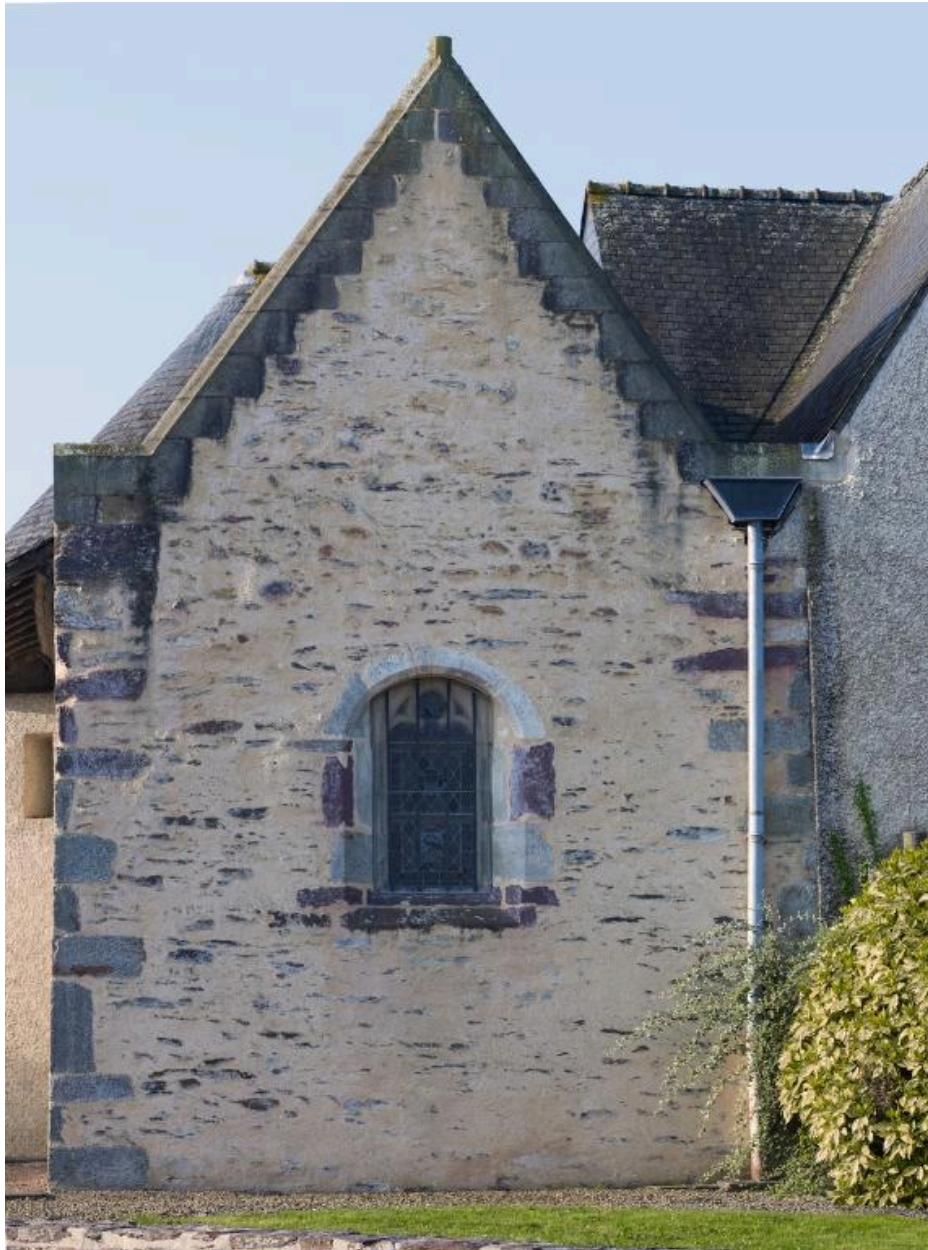
Eglise Saint-Melaine, façade nord de la sacristie Saint-Gilles
