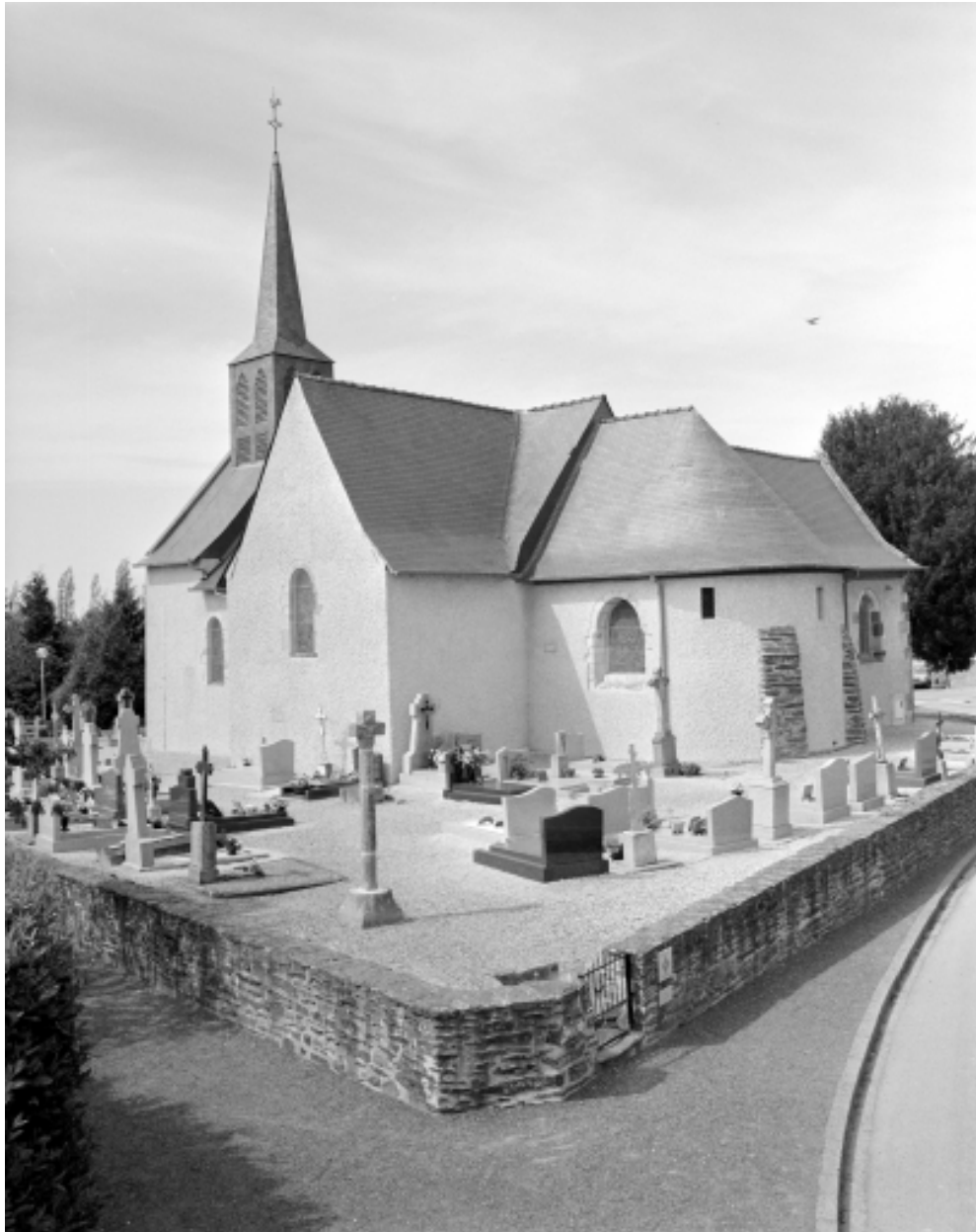
Elévation Sud-Est : vue générale
