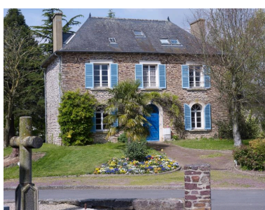
Ancien presbytère, façade principale vue depuis le cimetière de Moigné Phot. Bernard Bègne IVR53_20173500282NUCA
