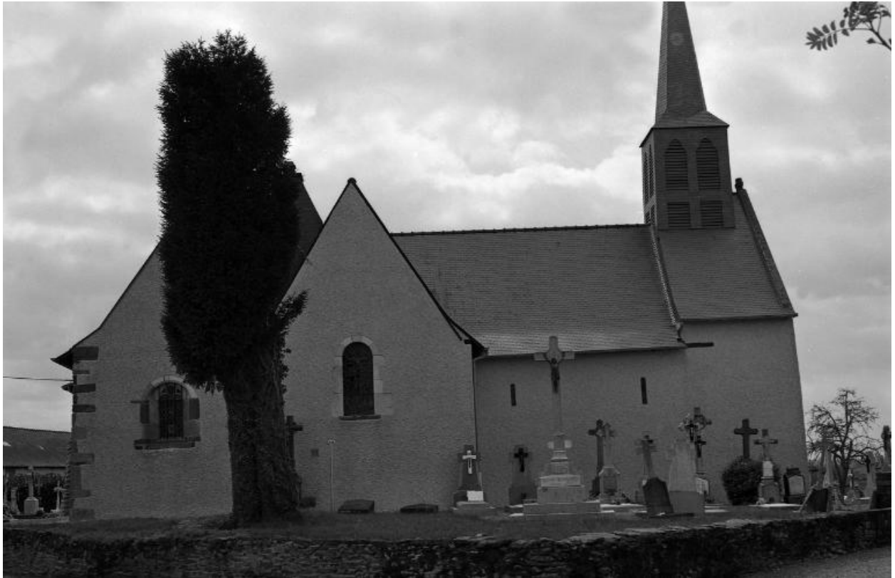
Eglise Saint-Melaine, façade nord
