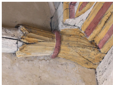
Eglise Saint-Melaine, détail de la charpente de la sacristie Saint-Gilles Phot. Bernard Bègne IVR53_20173500335NUCA
