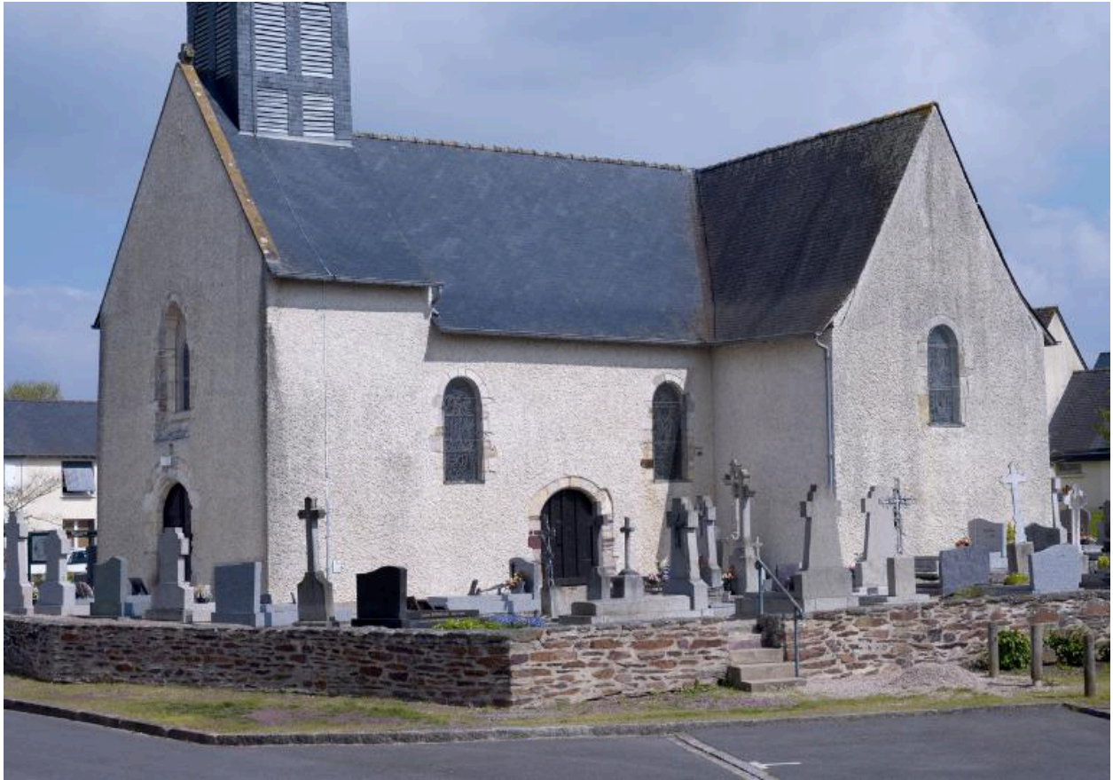
Eglise Saint-Melaine, façade nord
