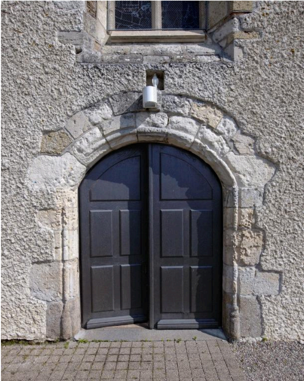
Eglise Saint-Melaine, entrée ouest
