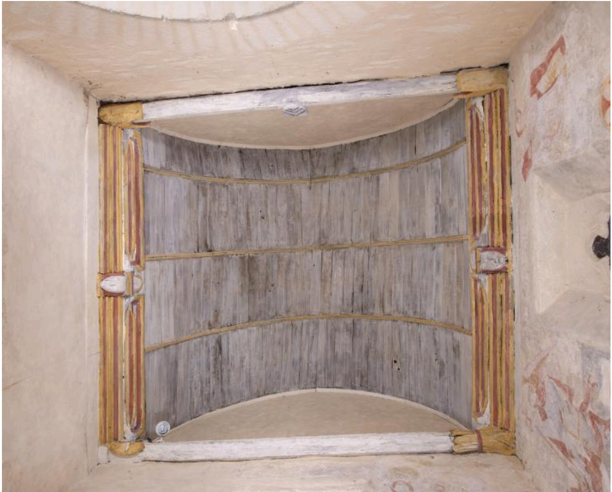
Eglise Saint-Melaine, vue intérieure de la charpente de la sacristie Saint-Gilles
