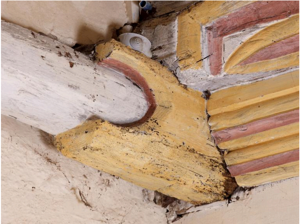
Eglise Saint-Melaine, détail de la charpente de la sacristie Saint-Gilles
