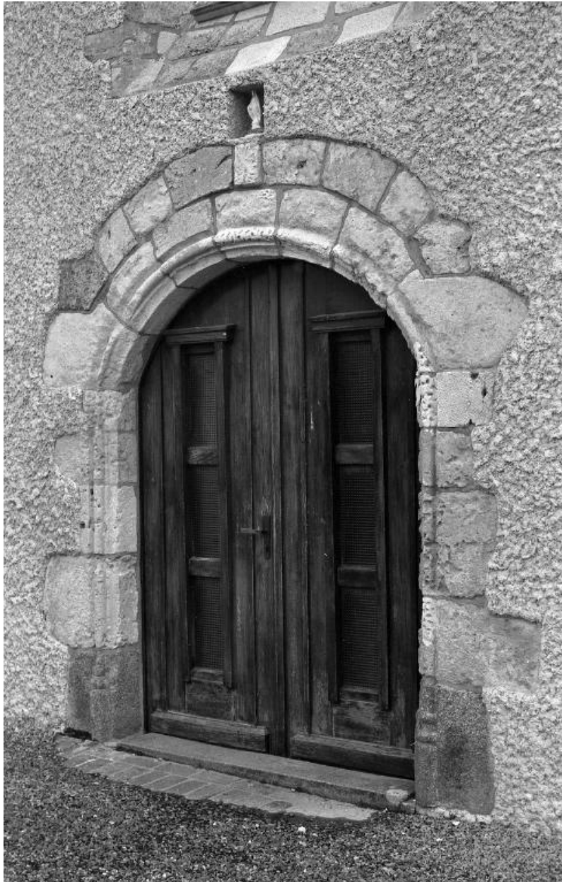
Eglise Saint-Melaine, entrée sud
