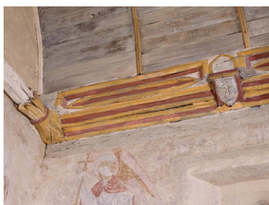
Eglise Saint-Melaine, détail de la charpente de la sacristie Saint-Gilles Phot. Bernard Bègne IVR53_20173500330NUCA
