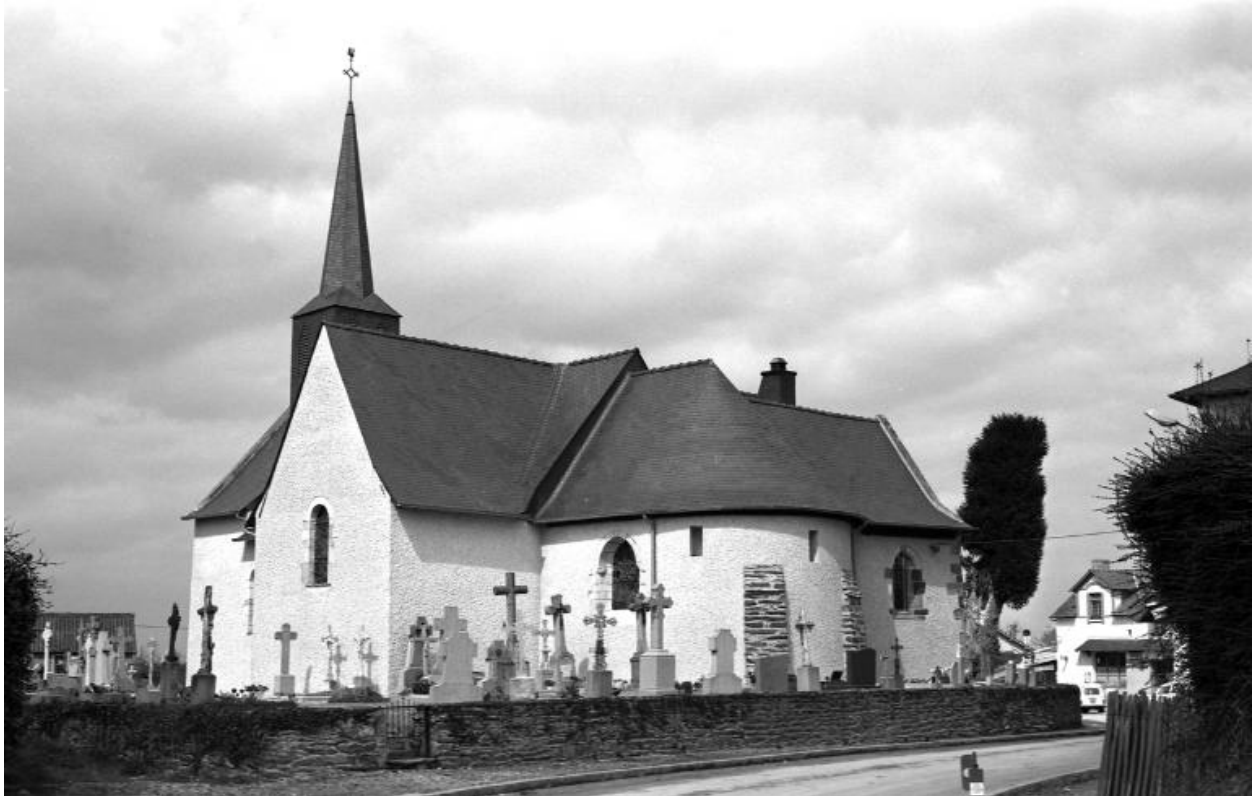
Eglise Saint-Melaine et cimetière, vue sud-est
