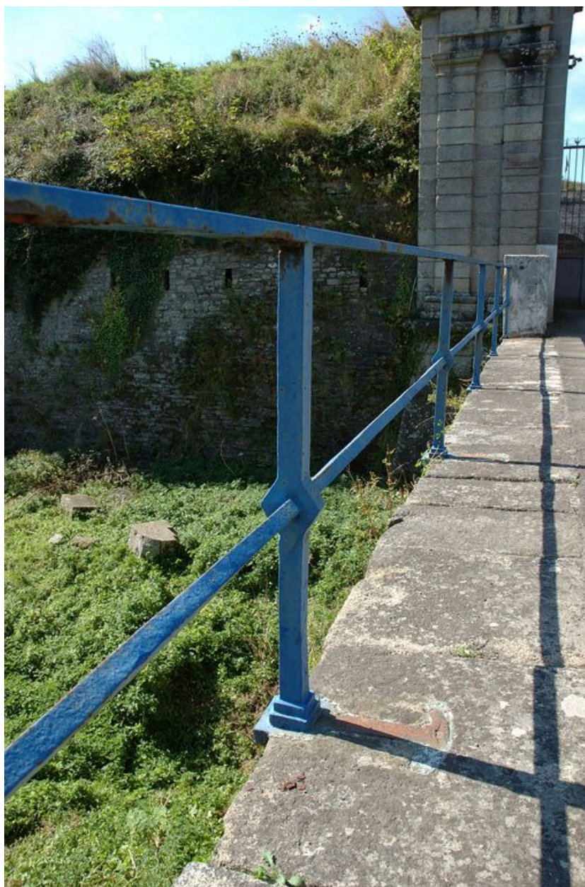
Vue de l'entrée monumentale : garde-corps en ferronnerie
