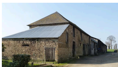
Vue générale nord est des dépendances Phot. Laurence Marquet IVR53_20243531333NUCA
