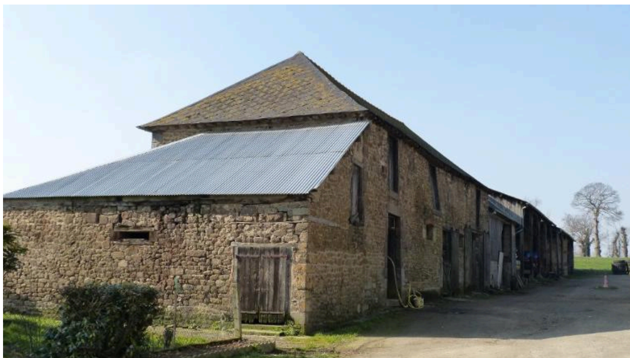
Vue générale nord est des dépendances
