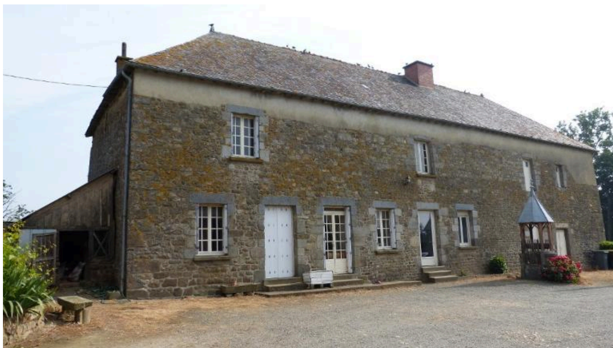
Vue générale sud ouest du bâtiment principal
