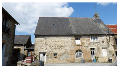
Vue générale de la façade sud, porte cintrée et appuis moulurés, maison du 17e siècle Phot. Marquet Laurence IVR53_20243530706NUCA
