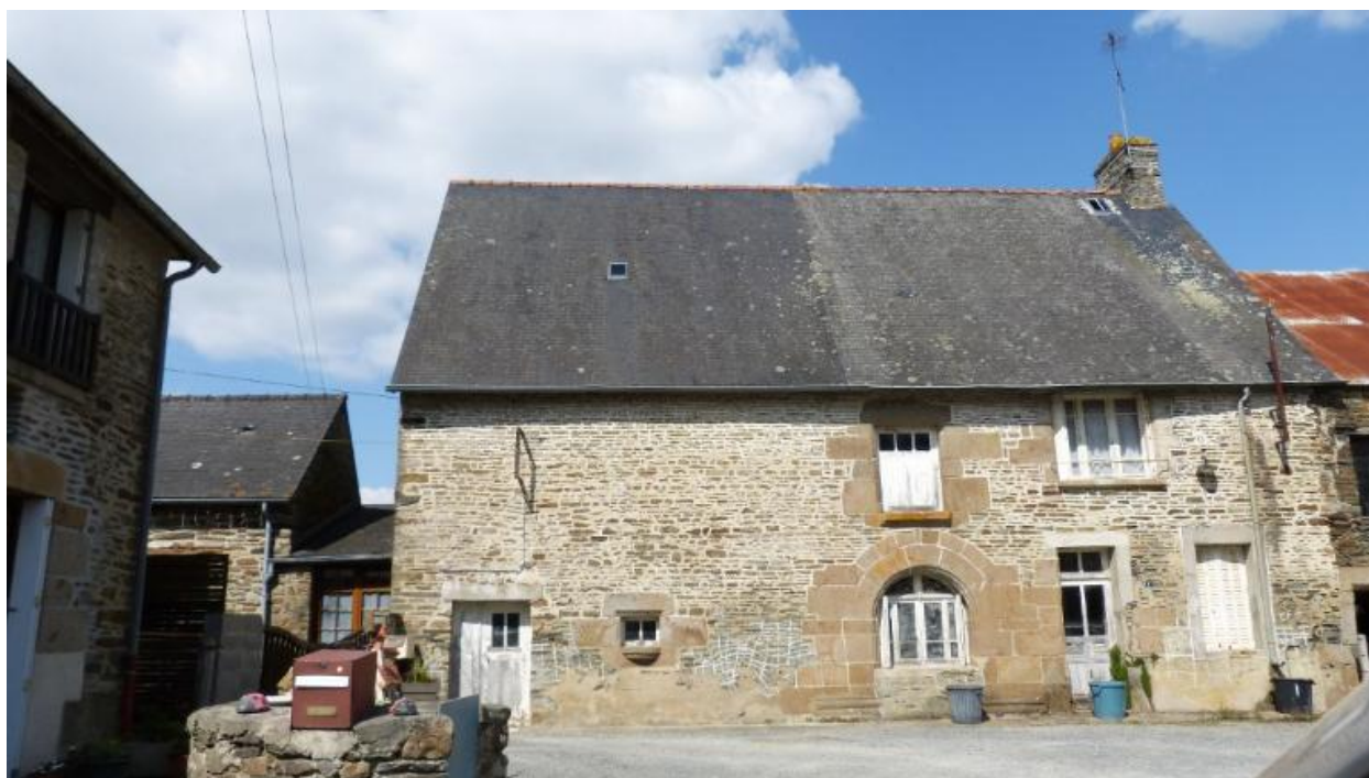
Vue générale de la façade sud, porte cintrée et appuis moulurés, maison du 17e siècle
