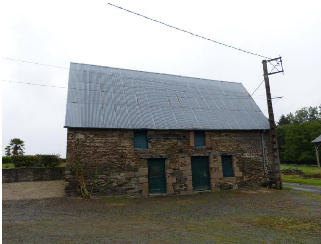
Vue générale de la façade ouest
