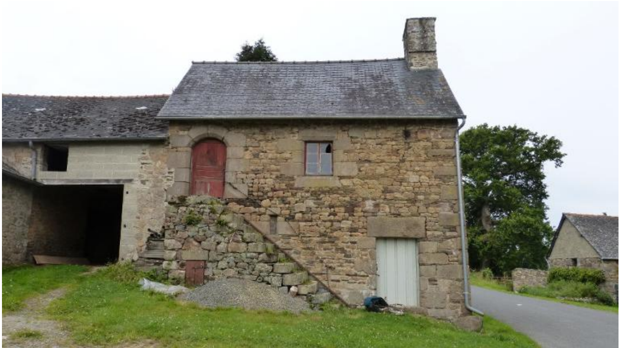
Vue générale de la façade est, maison à escalier extérieur
