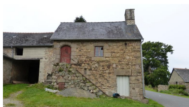
Vue générale de la façade est, maison à escalier extérieur Phot. Marquet Laurence IVR53_20243530384NUCA
