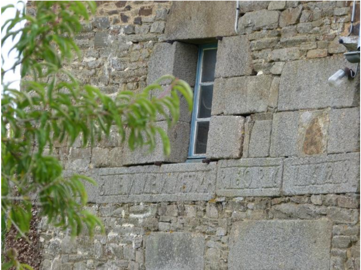
Détail d'un linteau gravé 1628
