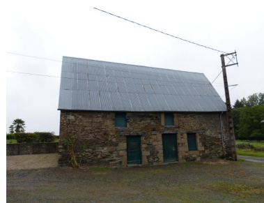
Vue générale de la façade ouest Phot. Marquet Laurence IVR53_20243530458NUCA
