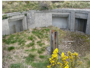
Encuvement de la batterie de Flak Phot. Guillaume Marie IVR53_20082908442NUCA
