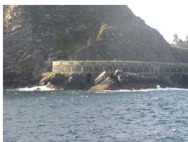
Batterie basse de Cornouaille Phot. Guillaume Marie IVR53_20082908519NUCA
