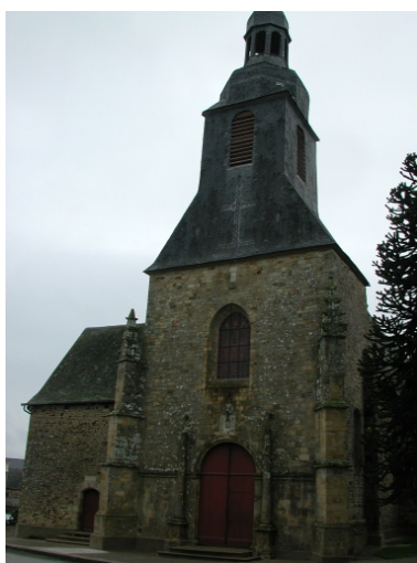
Elévation ouest Phot. Anne-Cécile Le Ninivin IVR53_20043518082NUCA
