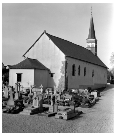
Elévation nord et sacristie accollée au chevet. Phot. Guy Artur, Phot. Norbert Lambart IVR53_19943500772X
