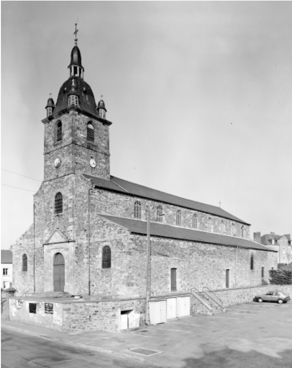
Elévation sud-ouest : vue générale
