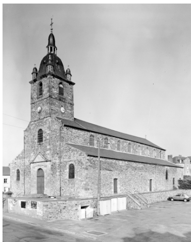
Elévation sud-ouest : vue générale Phot. L. Lamandé IVR53_19853501605V
