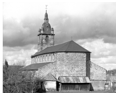
Elévation est : vue générale Phot. L. Lamandé IVR53_19863500551X
