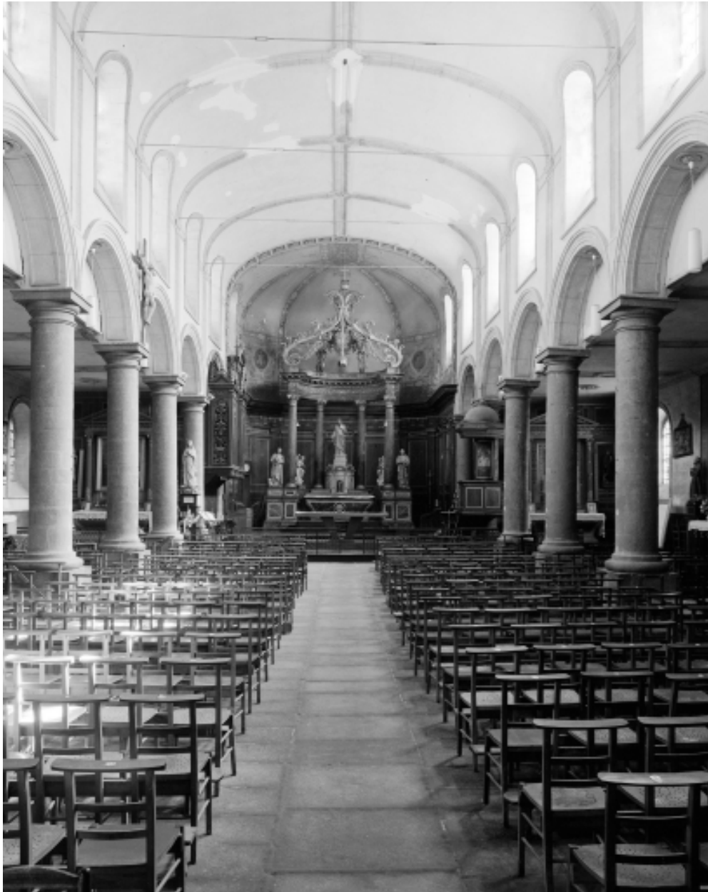
Intérieur : vue générale vers le chœur.
