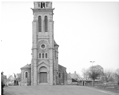
Elévation Ouest : vue générale
