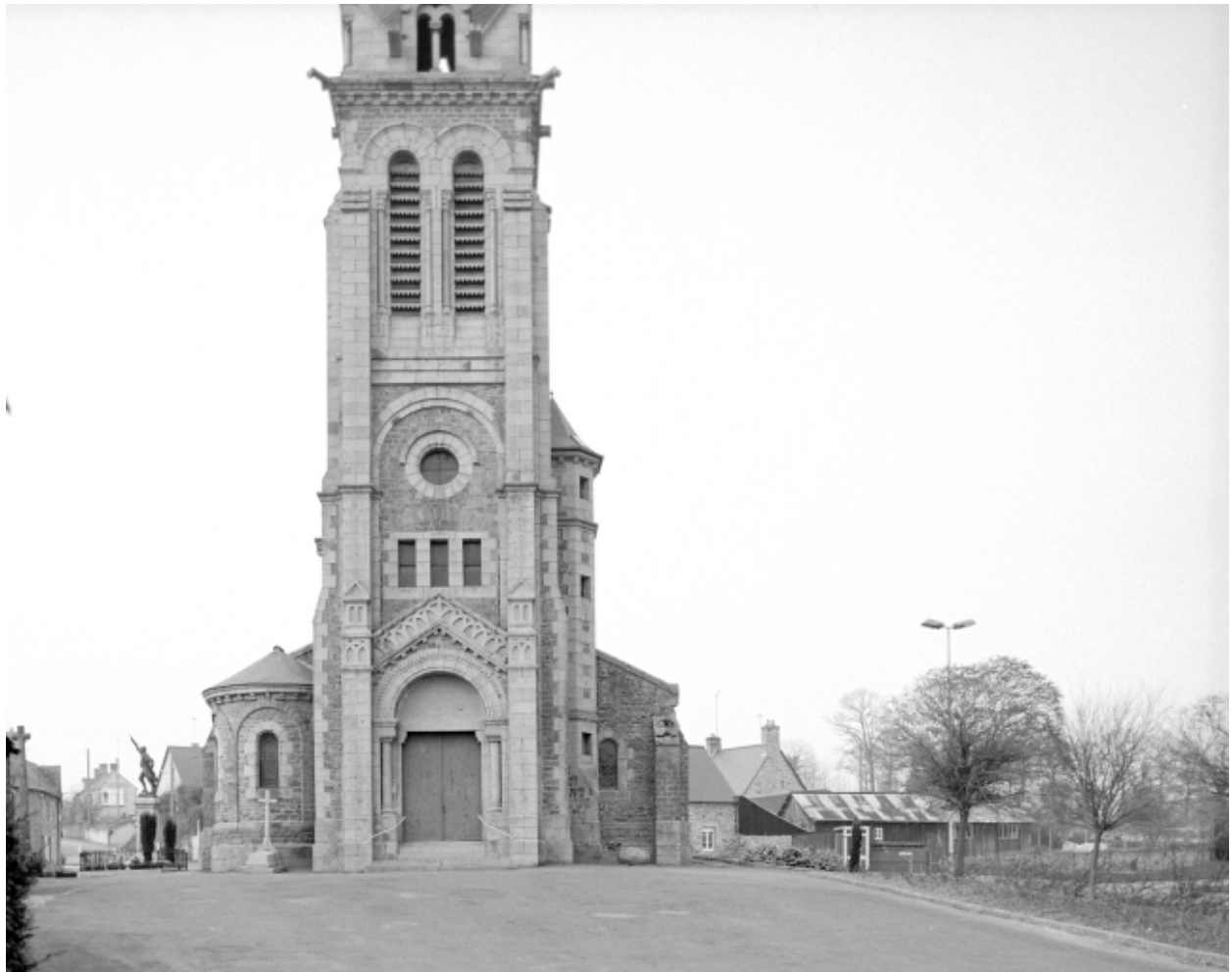
Elévation Ouest : vue générale
