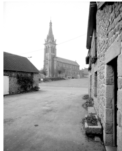
Elévation Sud-Ouest : vue générale
