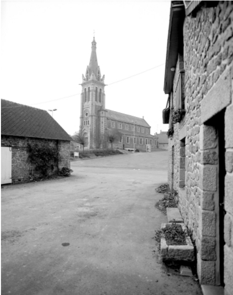
Elévation Sud-Ouest : vue générale
