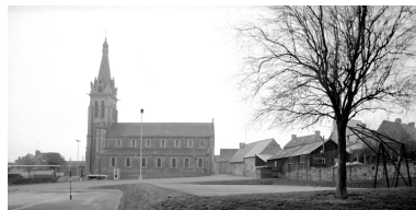
Elévation Sud : vue générale
