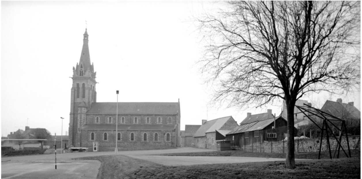
Elévation Sud : vue générale
