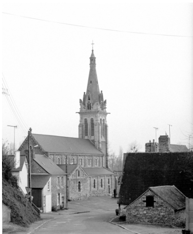
Elévation Nord : vue générale
