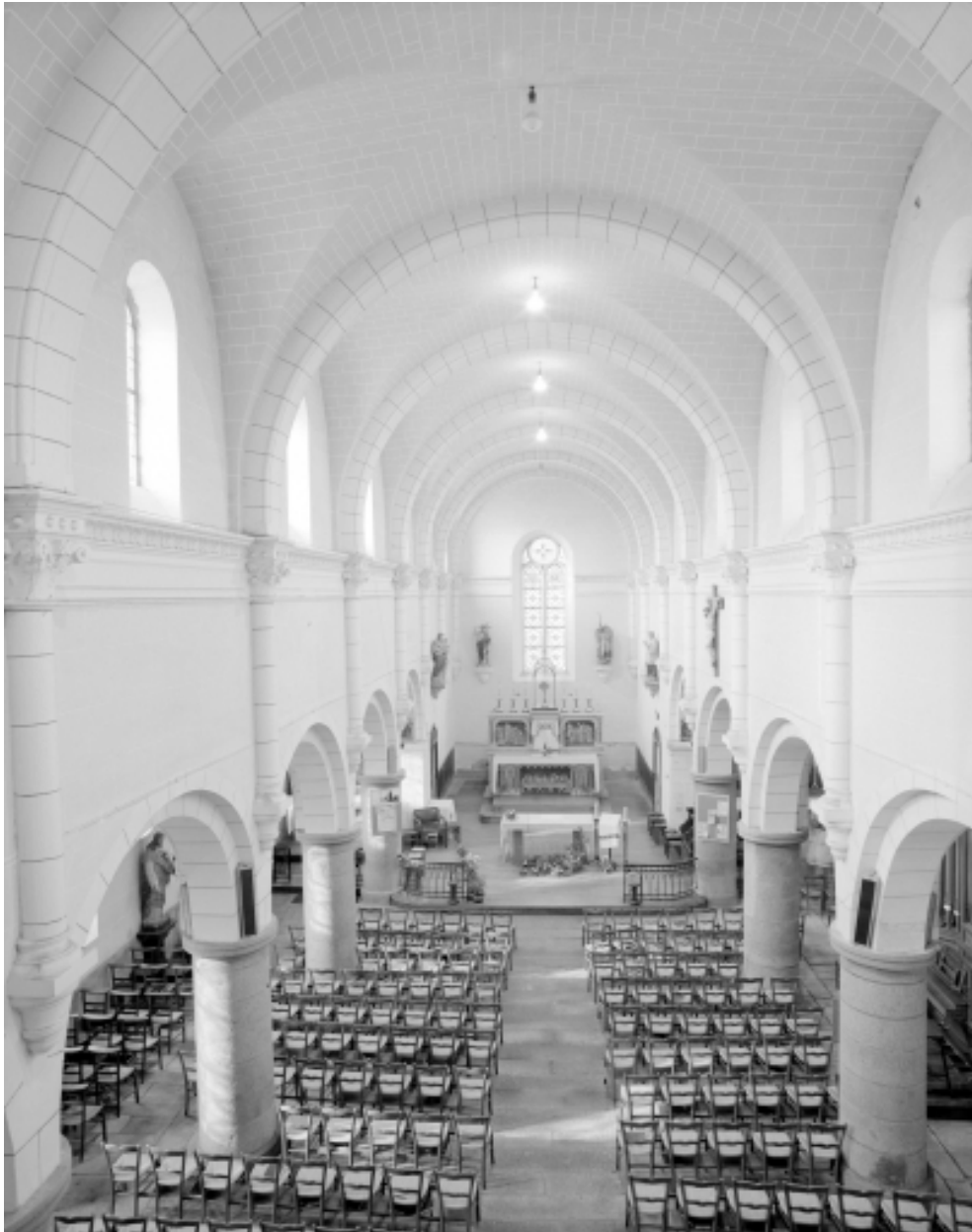
Intérieur : vue générale vers le chœur.
